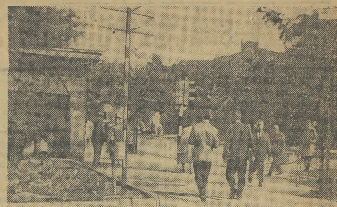
Na włosnę odnowiono słupy sygnalizacji świetlnej przy Głównej Poczcie. Równocześnie zdjęto drogowskazy i zapomniano o nich. Pozostał pusty słup, znakomicie dezorientujący przyjeżdżających do śródmieścia. Fot. J. Zarzecki
