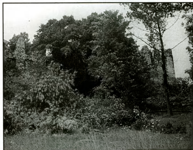
Widok przed rozpoczęciem prac
