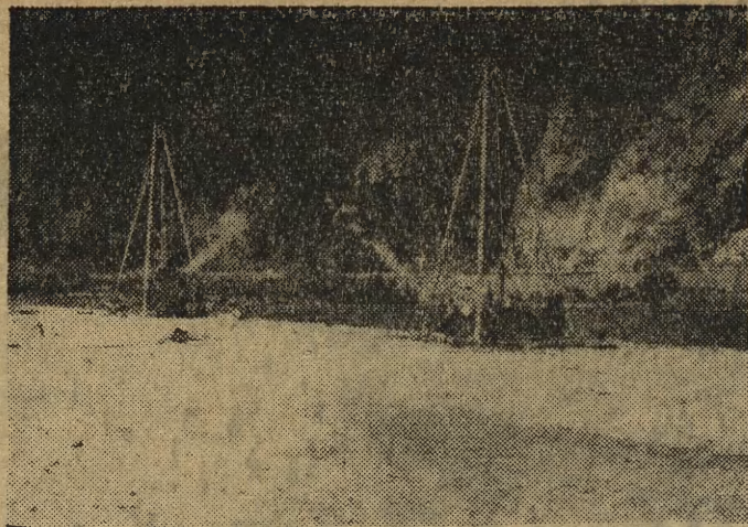
Na brzegach Dunajca pod niedzielnym zamkiem pojawiły się nowe elementy w krajobrazie: trójnogi wiertnicze. Trwają tam już intensywne badania podłoża geologicznego dna przysięgłego sztucznego jeziora i zapory wodnej.
