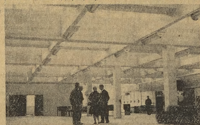
Wnętrze nowej hali produkcyjnej „Horyzontu”.
