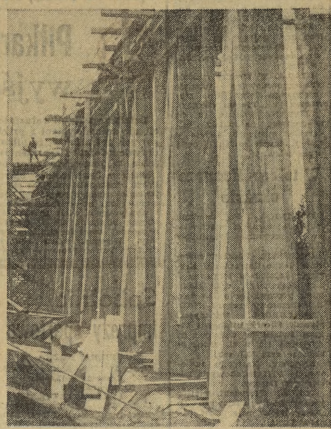
Na trasie Nowogródzko-Kocmyrzowska — Kieleckiej Przedsiębiorstwo Robót Mostowych buduje wiadukt nad rzeką Białuchą.
