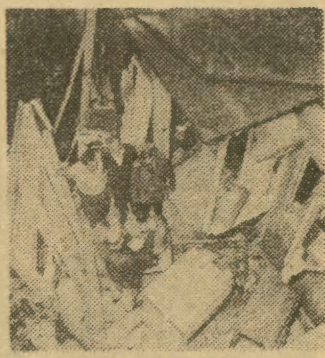
Eksplzja gazu, uchodzącego z nie zakreconej butli, zniszczyła wnętrze jednorodzinnego domu przy ul. Słiwowej w Łodzi. Na szczęście nikt z mieszkańców nie odniósł obrażeń.
