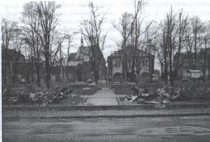
Remontowany rynek w Żarnowcu
