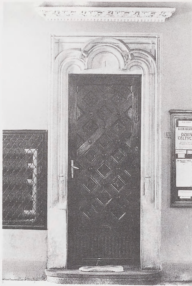
6a. Portal kamienny z korytarza Collegium Novum
