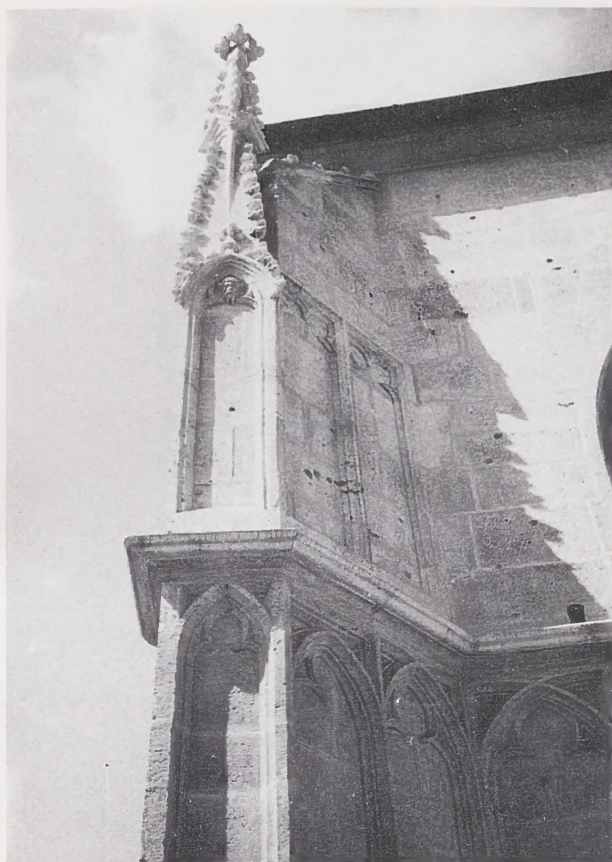
20. Przypora południowo-wschodniego narożnika kruchty (fot. M. Szyma)
