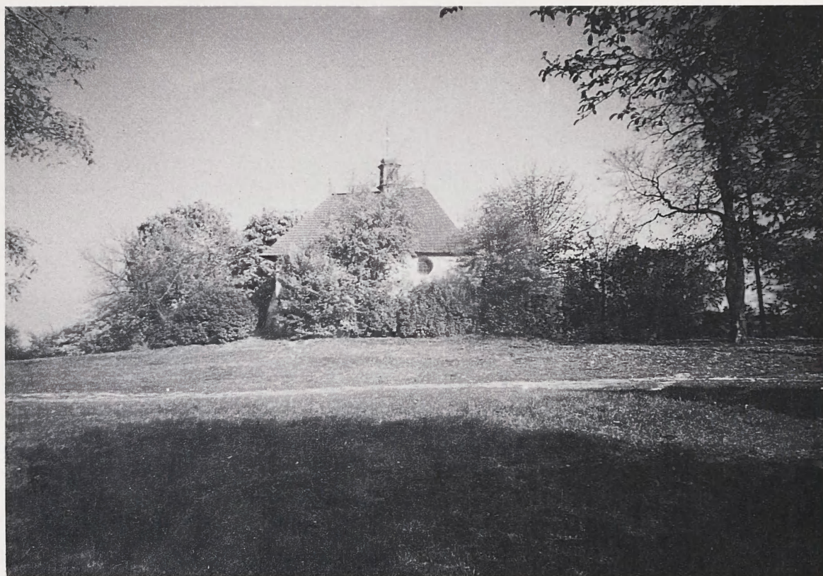
3. Widok ogólny kościoła od strony południowo-zachodniej (fot. J. Rajman)
