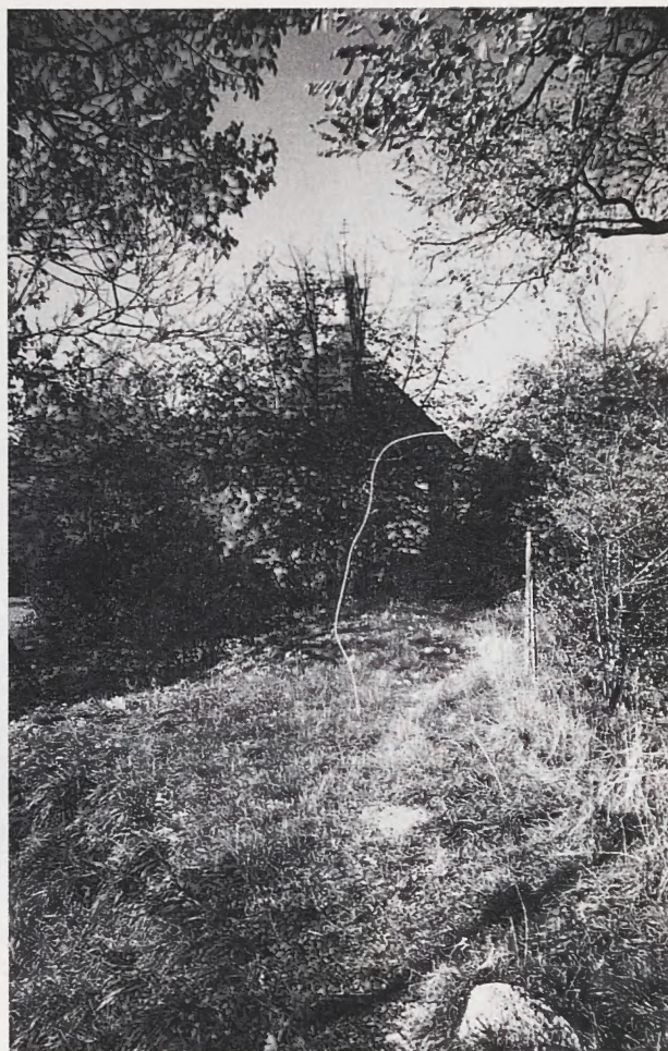
1. Kościół Św. Benedykta od strony prezbiterium (stan obecny; fot. J. Rajman)
