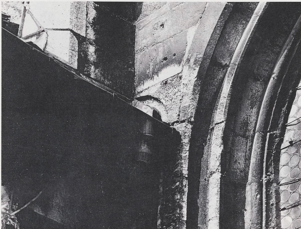
7. Arkada w murze nawy południowej przecięta przez wschodni mur kruchty (wg M. i B. Krasnowolscy, Kraków, kościół poaugustiański pw. św. Katarzyny, nawa południowa i kruchta, dokumentacja historyczna ; fot. T. Kalarus)
