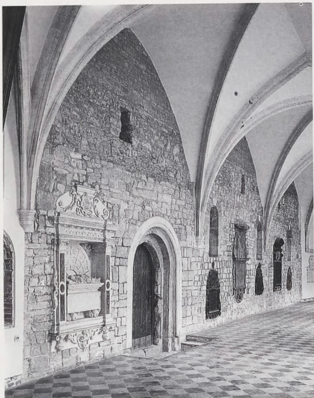
5. Północne skrzydło krużganków dominikańskich z romańską elewacją pierwotnego kościoła Św. Trójcy po konserwacji; fot. M. Grychowski
