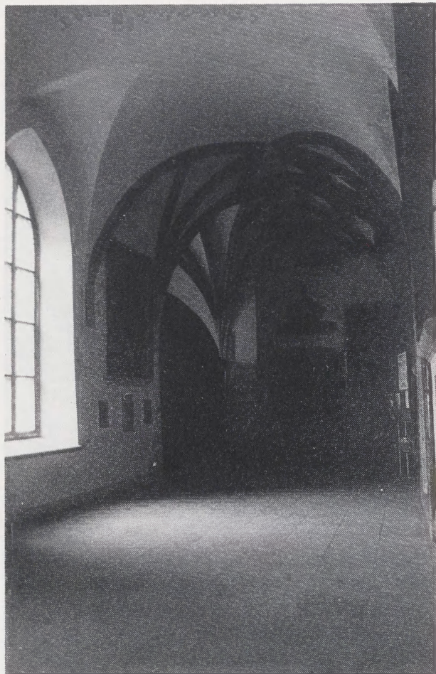
2. Odsłonięte sklepienia w przykościelnej części wschodniego skrzydła krużganków klasztoru franciszkanów w Krakowie; fot. Agnieszka Solewska
