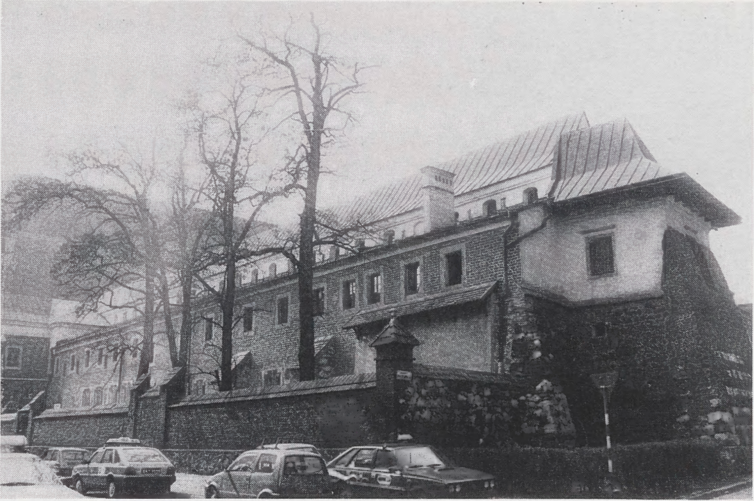
3. Odsłonięty mur ceglany fasady klasztoru augustianów w Krakowie, widoczna także baszta; fot. A. Solewska
