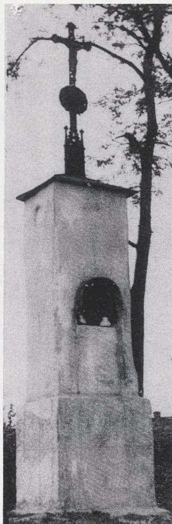
5. Krzyż na cokole ustawiony przy ulicy Łokietka (dawnej Poznańskiej), stan z 1967 roku
