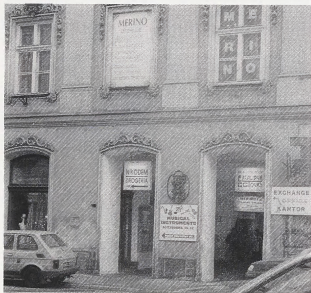
2. Fragment podcieni pałacu Pod Kozłem hr. Stadnickich przy ul. Grodzkiej 40 (fot. M. Christian)
