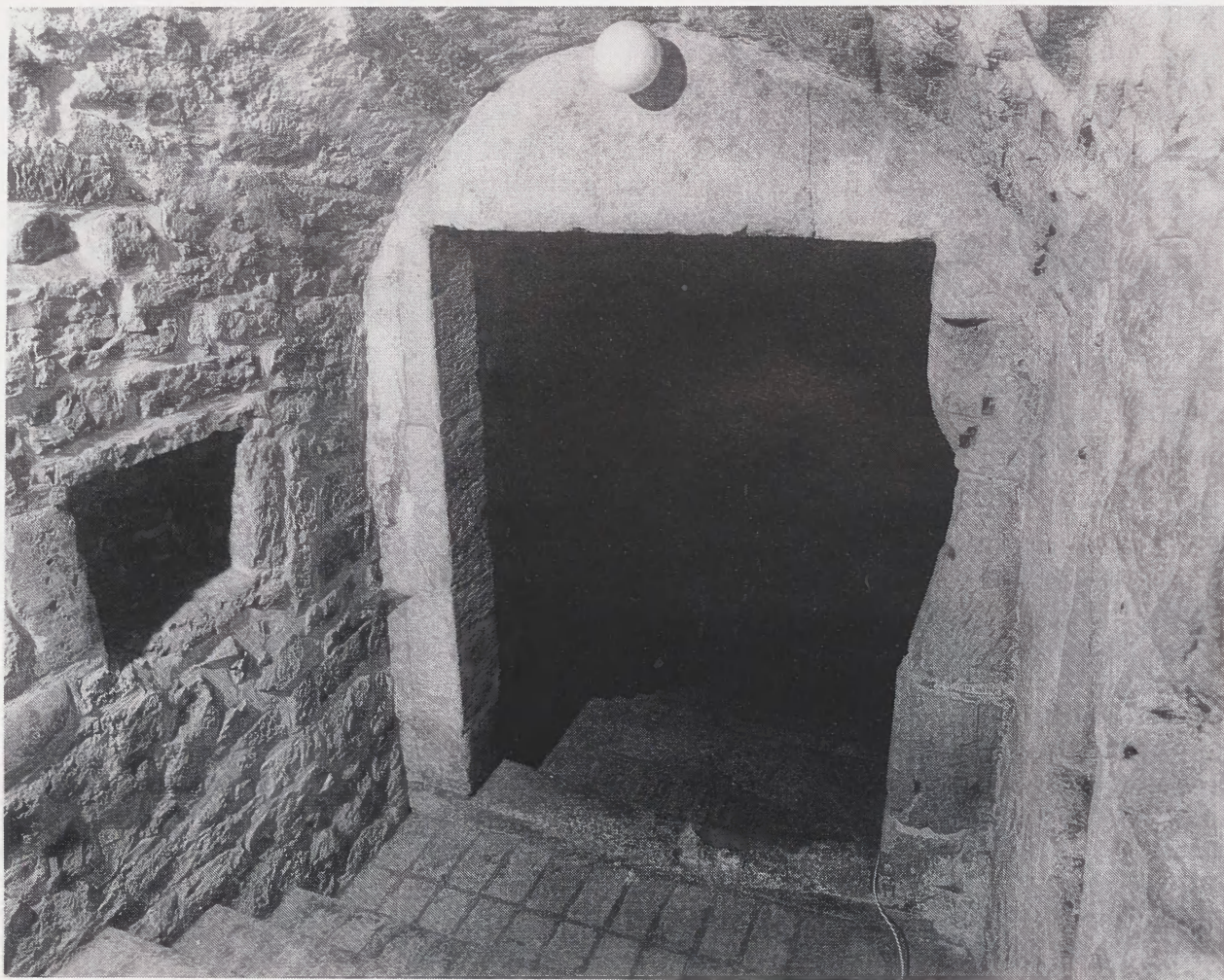
6. Kraków, klasztor dominikanów, pierwotne zejście do piwnicy pod refektarzem (fot. T. Kalarus)
