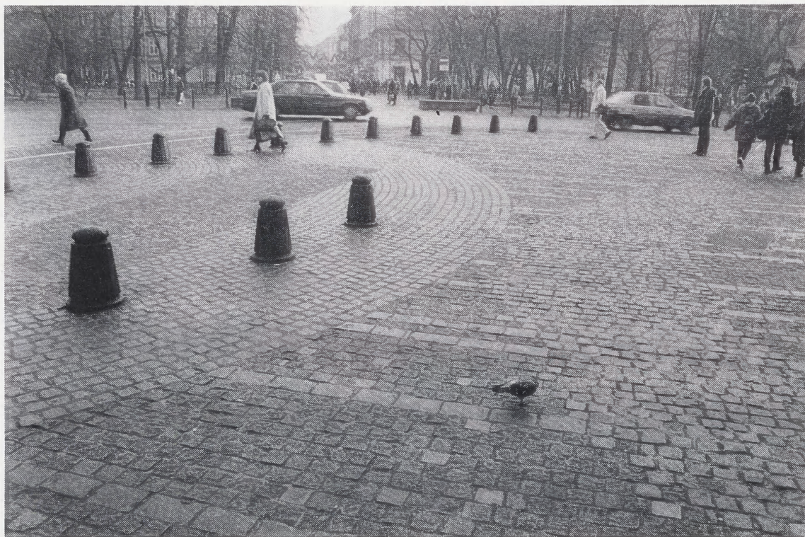
9. Nawierzchnia ul. Karmelickiej po remoncie. Skrzyżowanie ul. Karmelickiej i Podwala (fot. Jerzy Duda)
