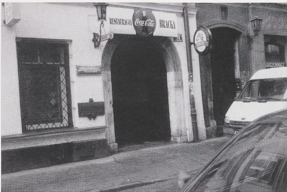
3. Portal domu przy ul. Brackiej 13 (fot. M. Christian)
