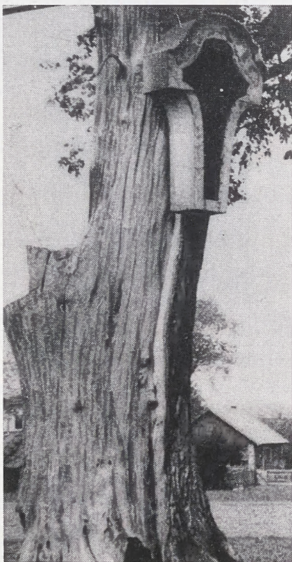
9. Obudowa nie istniejącej kapliczki przybita do starego wiazu (róg ul. Raławickiej i Litewskiej), stan z 1967 roku
