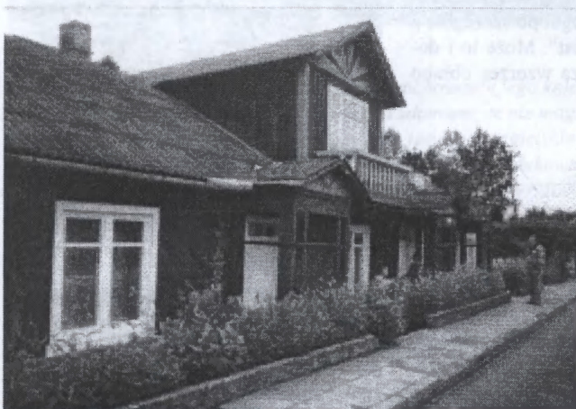
Budynek przedwojennej poczty
