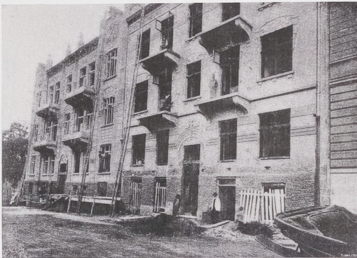
8. Ulica Głęboka, system domów budowanych bez udziału architekta we Lwowie; „Architekt”, R. 9: 1908, z. 9, s. 96
