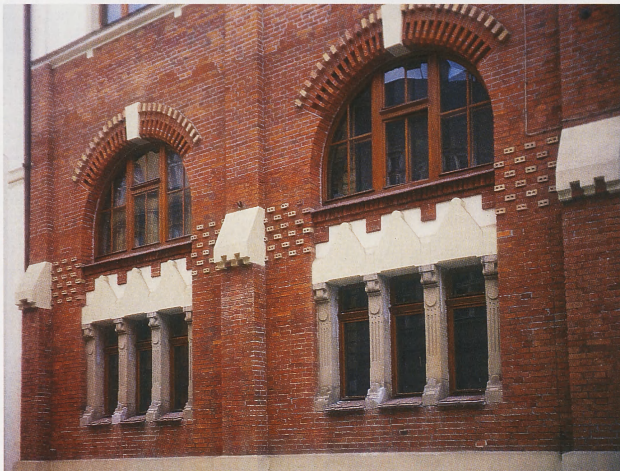
3. Detale okna hali maszyn w zespole elektrowni krakowskiej przy ul. Św. Wawrzyńca. Stan obecny. Fot. A. Sudacka
