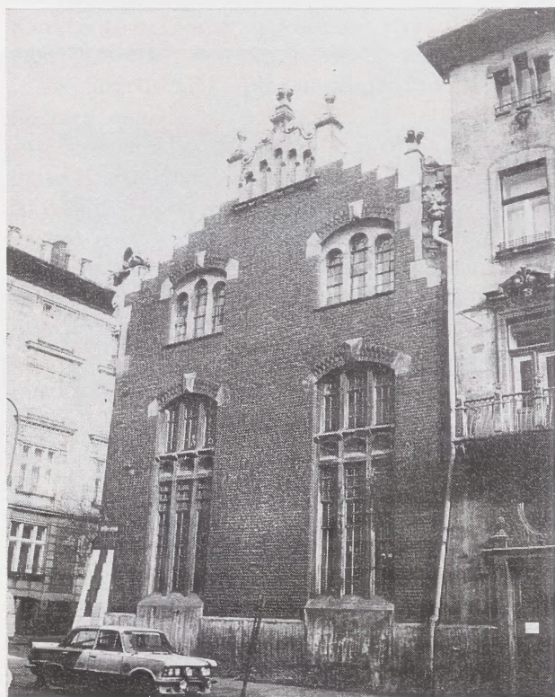
12. Elewacja podstacji elektrycznej. Stan obecny. Fot. Pracownia Fotograficzna PKZ, Kraków 1980
