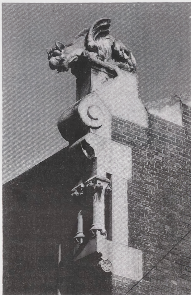
13. Podstacja elektrowni przy ul. Łobzowskiej: postać Chimery na narożniku elewacji. Stan obecny. Fot. T. Kalarus
