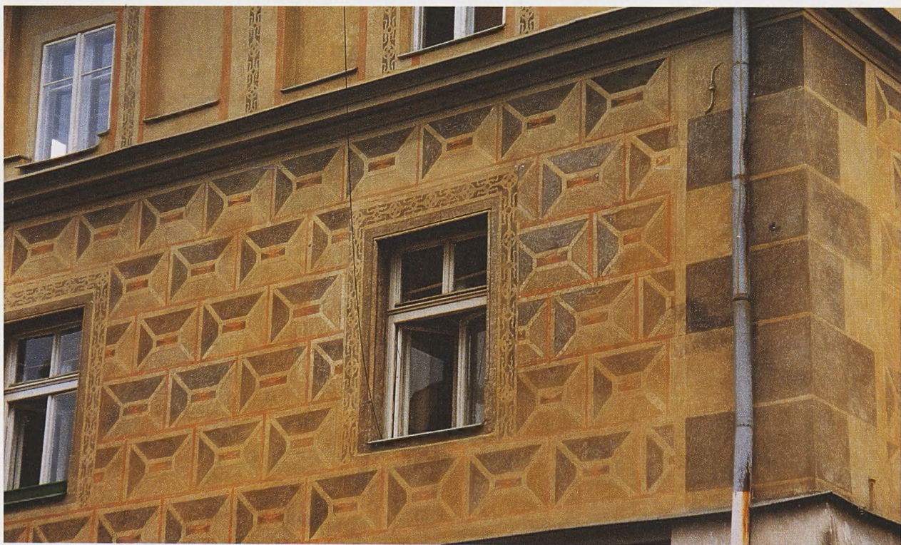
3. Sgraffito pierwszego piętra fasady północnej
