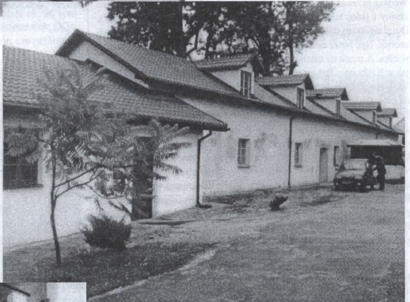
Odremontowane dawne zabudowania gospodarcze przy klasztorze w Pilicy
