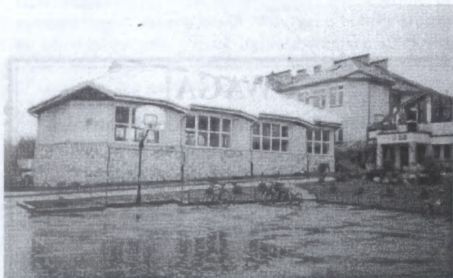
Sala gimnastyczna przy nowoczesnej Szkole Podstawowej w Bydlinie.
