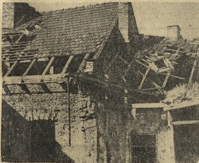
Ul. Józefa 27. Budynek umieszczony w planie rozbiórki dopiero w 5-lacie 1971—75.
