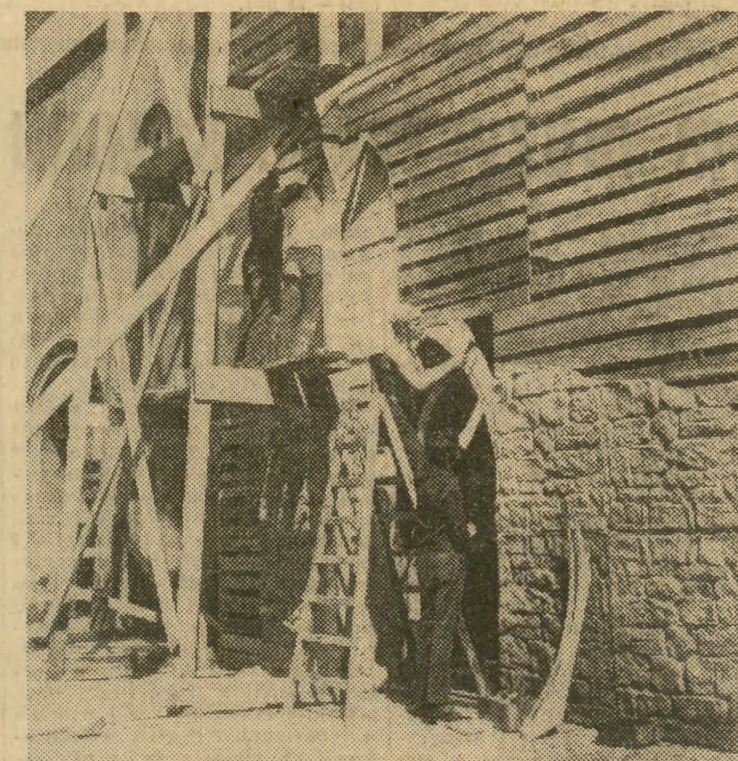
Drewniane rusztowania pokryte są gipsowymi płytami, które do złudzenia będą imitować średniowieczną fakturę murów. Fot. LECH KŁECZEK
