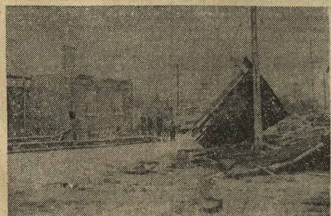
Nad Nowym Młastem (woj. łódzkie) przeszła trąba powietrzna. N/ż: zniszczony dach na budynku mieszkalnym. CAF — Rozmysłowicz — telefoto
