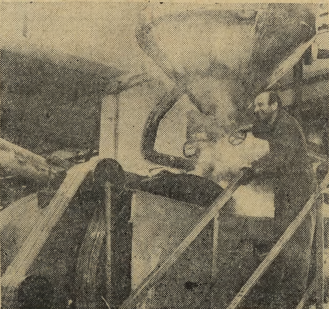
Kaprolaktam w trakcie produkcji może przybierać rozmaite postacie. Oto półfabrykat w procesie przedzenia z niego taśmy. Autoklawy obsługuje Wincenty Kraso.
