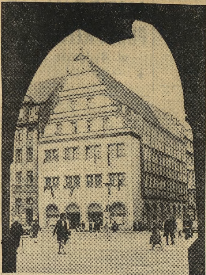
Odbudowany po wojnie gmach Starej Wagi przy lipskim Rynku. Przyjęto tu oryginalną metodę połączenia nowoczesnego wnętrza ze zrekonstruowaną zabytkową fasadą.
