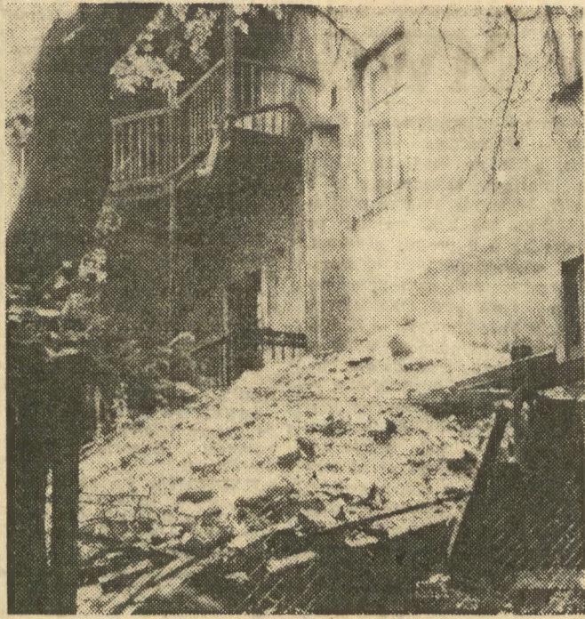
Już podobno dwa lata leży ta siera gruzu w ogródku przy ul. Filareckiej 21, zasłaniając okna, dając przy najłżejszych podmuchach wiatru tumany kurzu zasypujące okoliczne mieszkania. Jak długo jeszcze będzie trwał taki stan rzeczy? — zapytują mieszkańcy.
