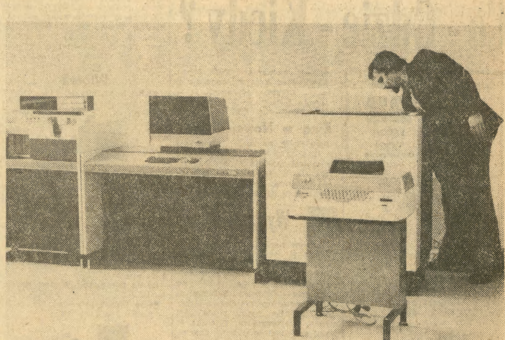
„Cyfronet” wykorzystany jest na zasadach abonenckich. Na zdjęciu: końcówka ciężka, z lewej strony czytnik kart, w środku monitor ekranowy, pod nim konsola operatorska, z prawej strony drukarka wierszowa. Z prawej strony z przodu tzw. końcówka lekka (dalekopisowa).
