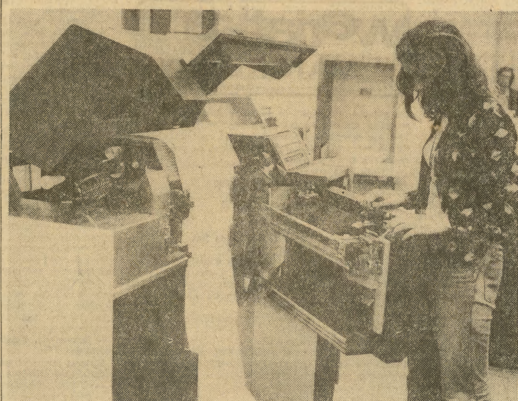
Pracownica obsługująca komputer przy drukarce wierszowej maszyny (1200 wierszy na minutę).
