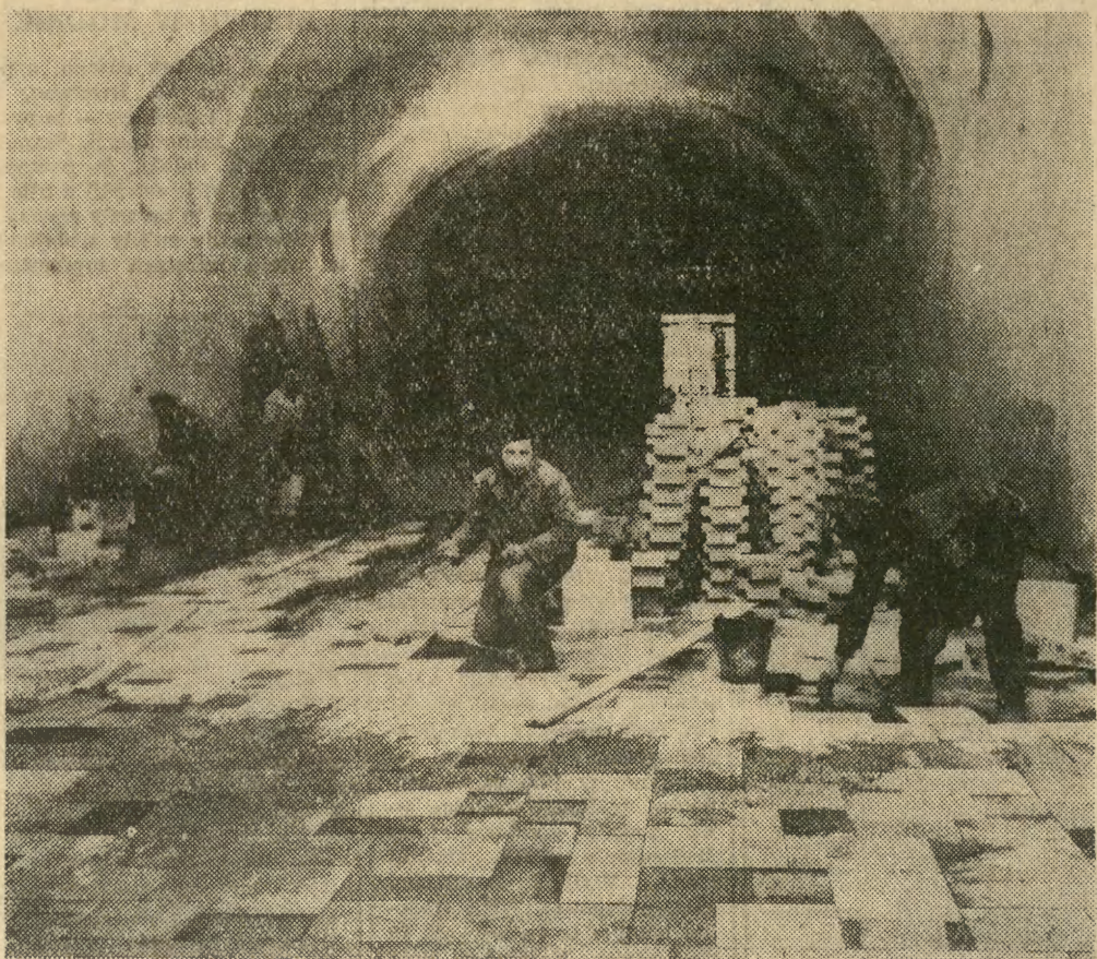
Brygada Józefa Jelenia (na zdjęciu w środku) z krakowskich PKZ-ów układa płytki dolomitowe na posadzce Sukiennic. Zdjęcia: J. RUBIŚ
