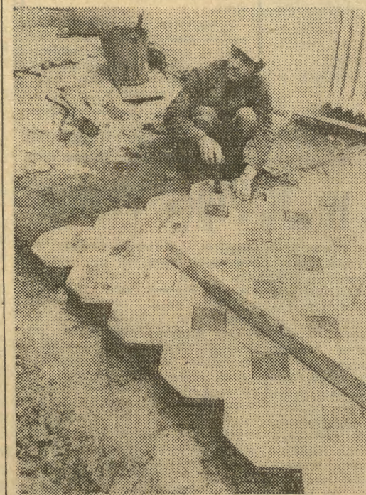
Układanie posadzki w Szarej Kamienicy. Zdjęcia: J. RUBIS
