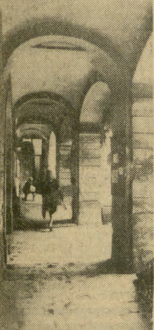
Fragment malowniczych podcieni głównego skrzydła Collegium Kółtataja od strony ul. Anny. W kolejnym etapie i tutaj prowadzić się będzie prace rewaloryzacyjne.
