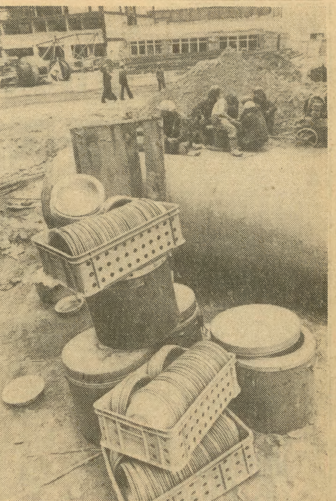
Romantyzm wielkiej budowy ma różne oblicza.
