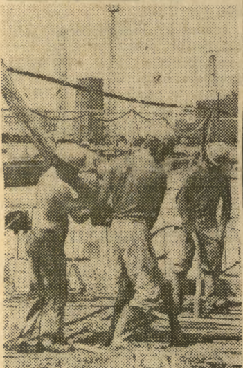
Brygada Mariana Rojka z „Budostalu” betonuje estakadę surówki na tzw. linii stali. CAF — Seko
