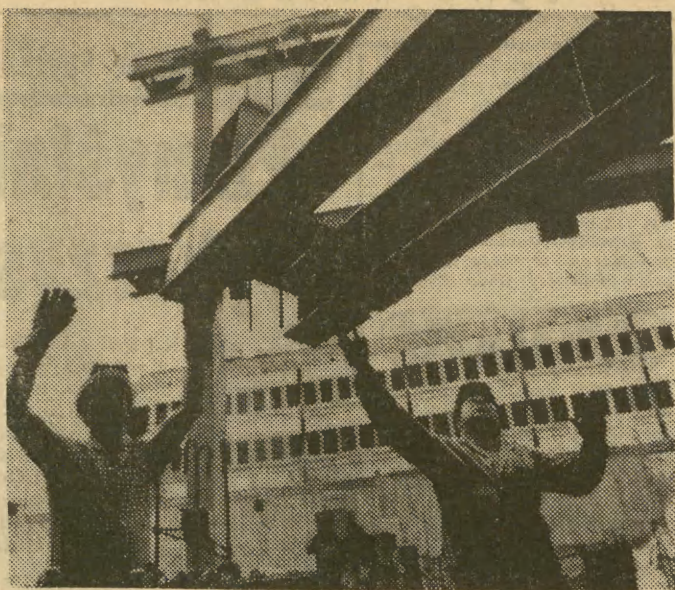
Oto migawka placu budowy Centrum Zdrowia Dziecka. Na zdjęciu: brygadziści Kazimierz Bielecki i Feliks Buraczynski podczas montażu konstrukcji stalowych budynku zabiegowego. CAF — Radkiewicz — telefoto
