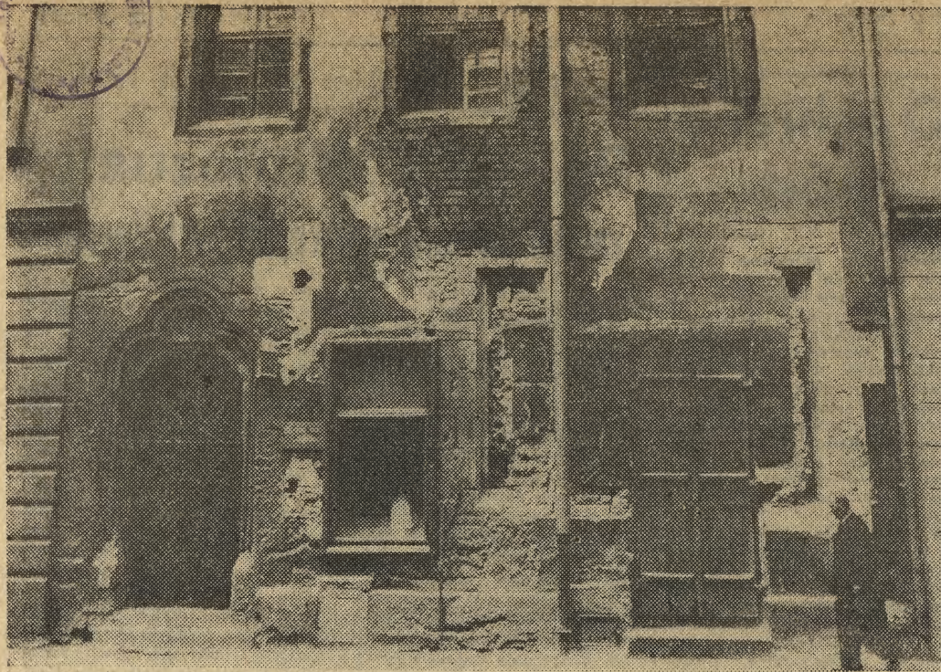
Kamienica przy ul. Szpitalnej 8, która w trakcie badań ujawnia rewelacyjne tajemnice.
