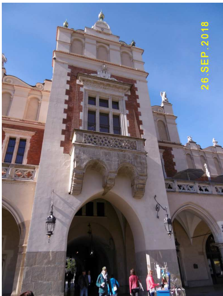
Fot. nr 40 (40-42). Kilka ujęć Sukiennic. Tu ryzalit od strony wschodniej.
