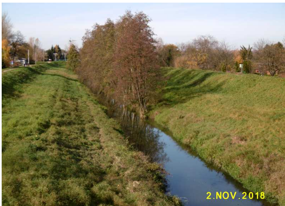
Fot. nr 277. Koryto Rudawy pomiędzy mostami trzecim i czwartym.
