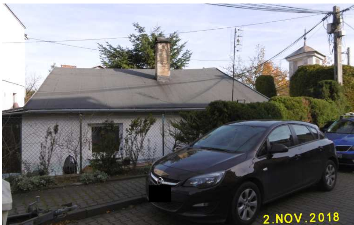
Fot. nr 260. Widok z ulicy Do Sikornika.
