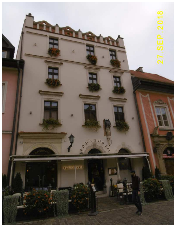
Fot. nr 99 (99-102). Wzdłuż ulicy Kanoniczej. Uporządkowana fasada kamienicy nr 22.
