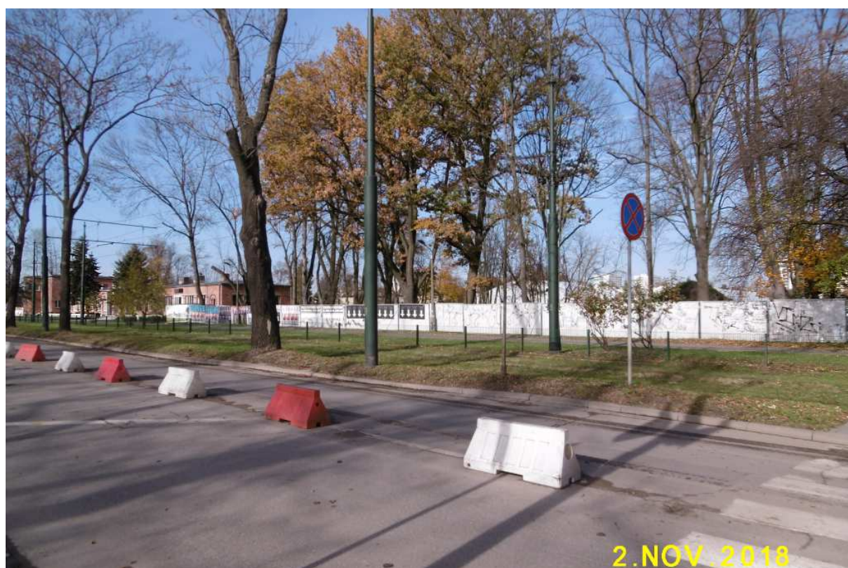
Fot. nr 209 (209-211). Kompleks dawnych basenów Cracovii na etapie remontu budynku szatni i rozbudowy zaplecza. Same baseny zostały zrównane z ziemią.
