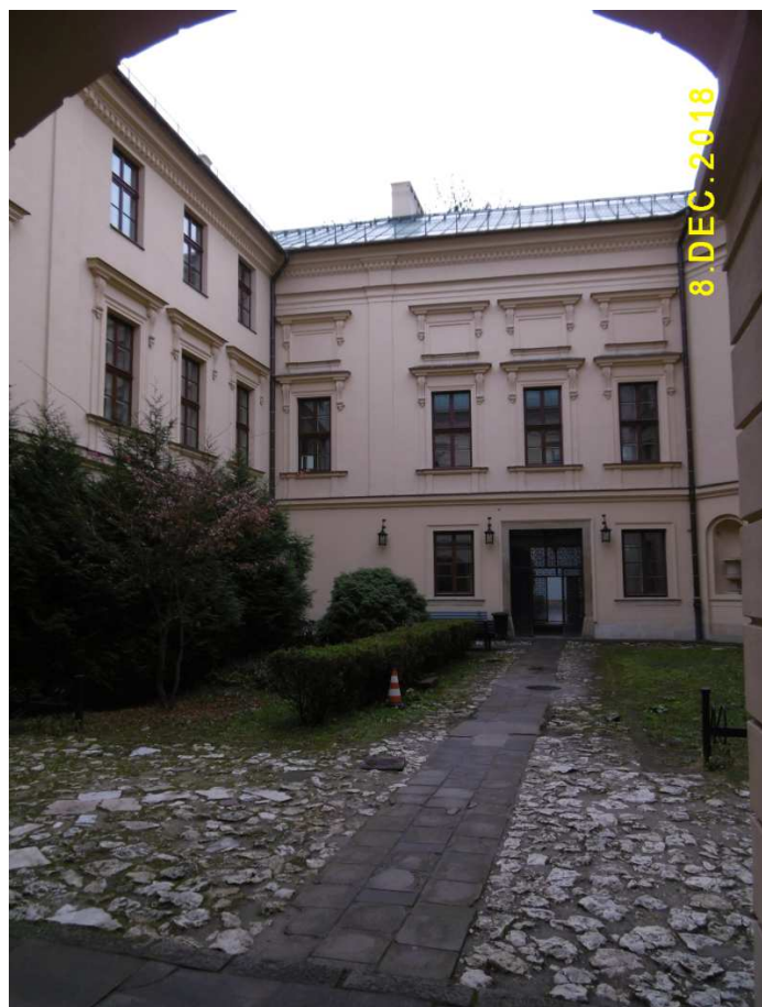
Fot. nr 139. Na dziedzińcu kamienicy przy ulicy św. Anny 6.
