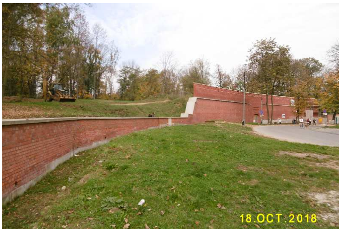
Fot. nr 225. Zrekonstruowana ściana wewnętrzna bastionu nr II fortu Kościuszko.
