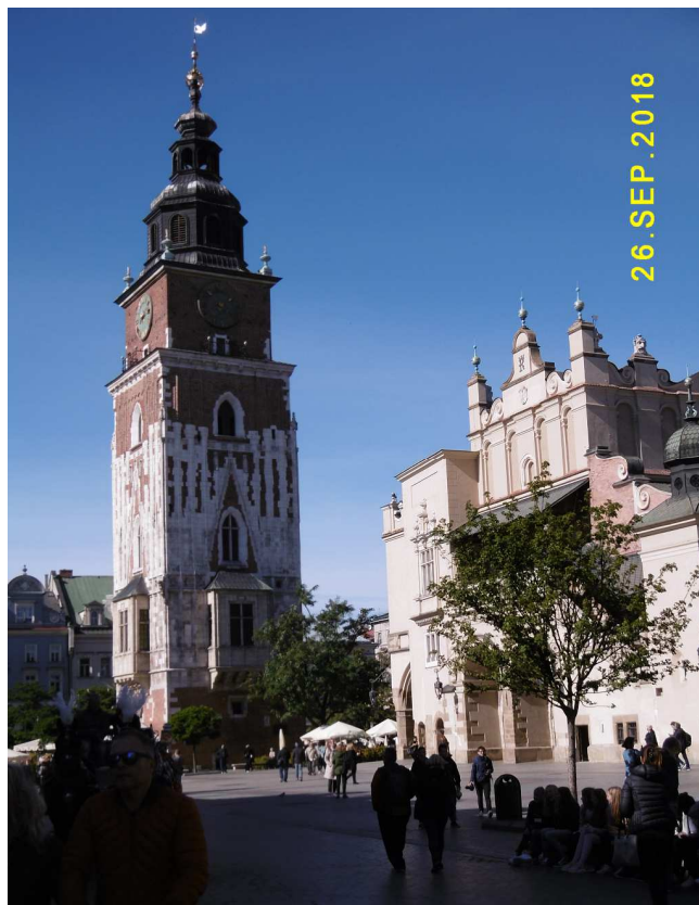
Fot. nr 60. Wschodni fragment wieży ratuszowej.
