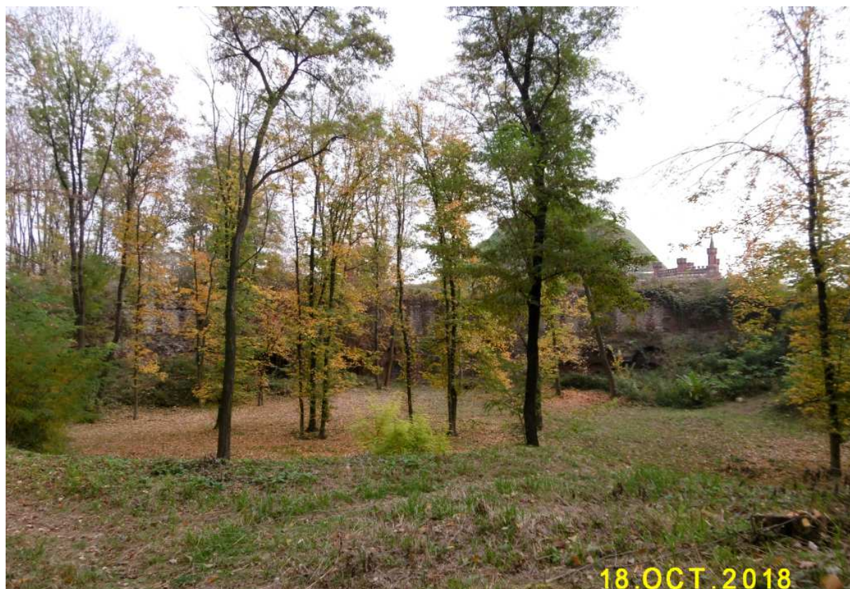
Fot. nr 230 (230-231). Ruina zewnętrznej części bastionu nr II.
