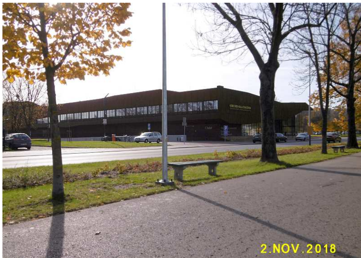
Fot. nr 218 (218-219). Nowa hala sportowa Cracovii przy alei Focha.
