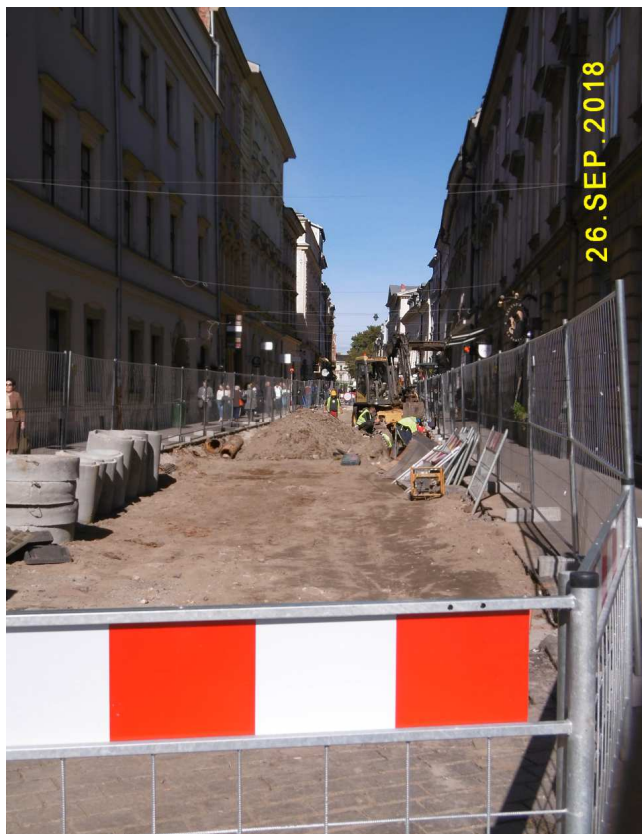
Fot. nr 46. Rozkopana ulica Sławkowska.
