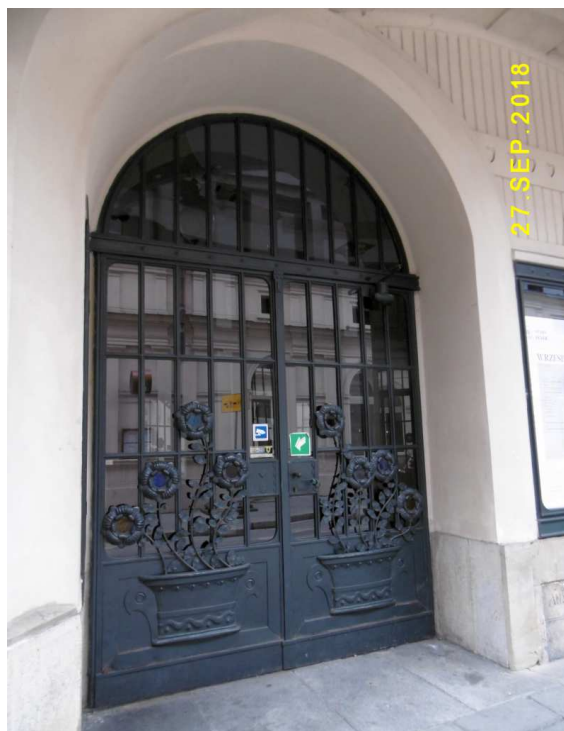
Fot. nr 151 (151-153). Detale Teatru Starego. Tu secesyjne drzwi.
