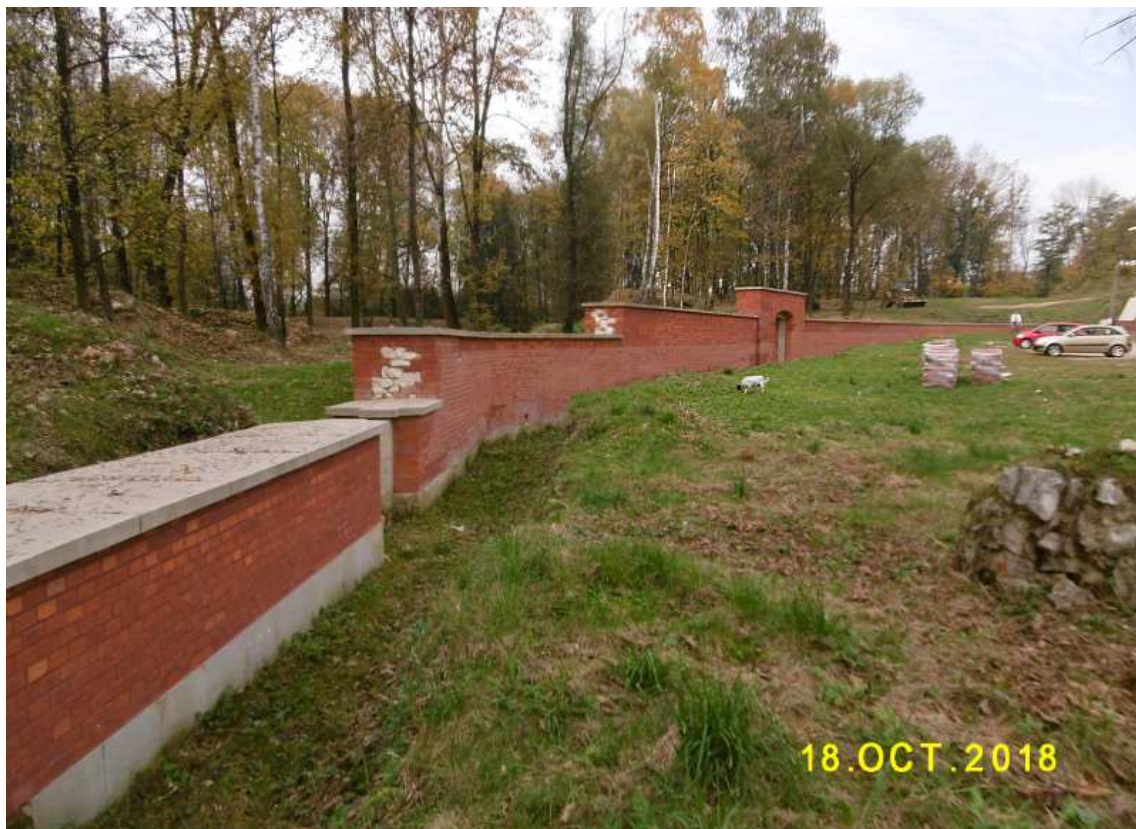
Fot. nr 224. Ukończony narys kurtyny I-II fortu Kościuszko.
