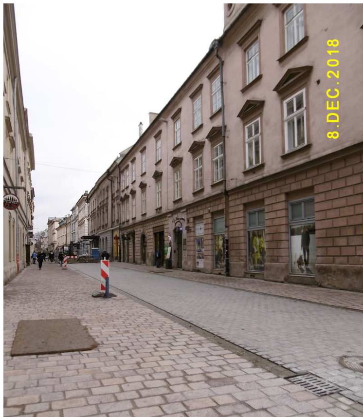
Fot. nr 158. Ujęcie z Rynku Głównego po założeniu nowej kostki.
