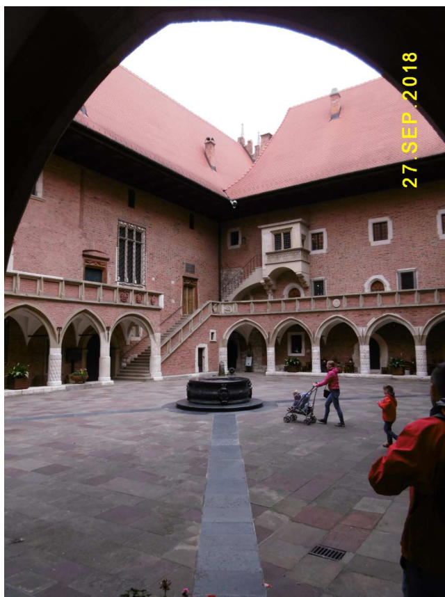
Fot. nr 132. Narożnik północno-wschodni.
