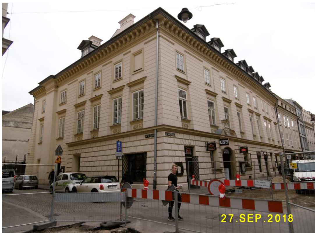
Fot. nr 159. Pałac Tarnowskich pod nr 13.
