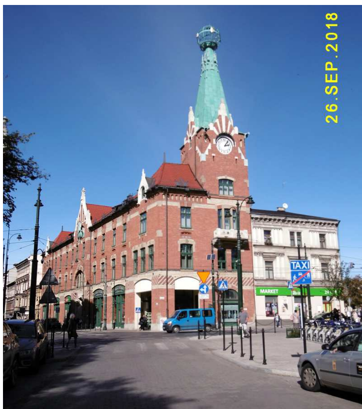
Fot. nr 180. Dom Pod Globusem przy ulicy Długiej 1.
