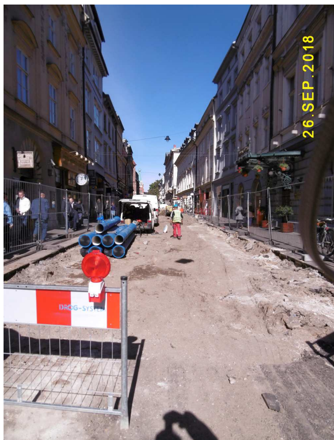
Fot. nr 157 (157-163). Wzdłuż ulicy Sławkowskiej. Etap remontu nawierzchni.
