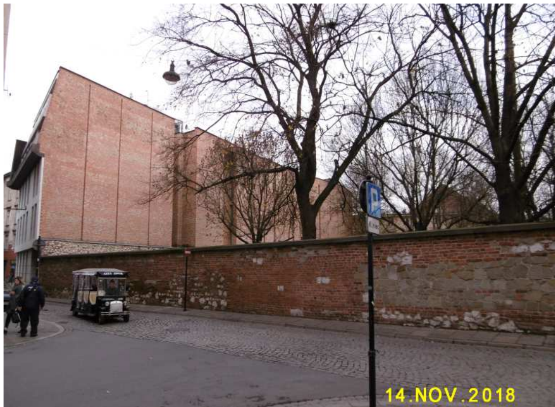
Fot. nr 132(132-137). Przy ulicy Jakuba w klimacie cmentarza Remuh. Tu mur cmentarny.
