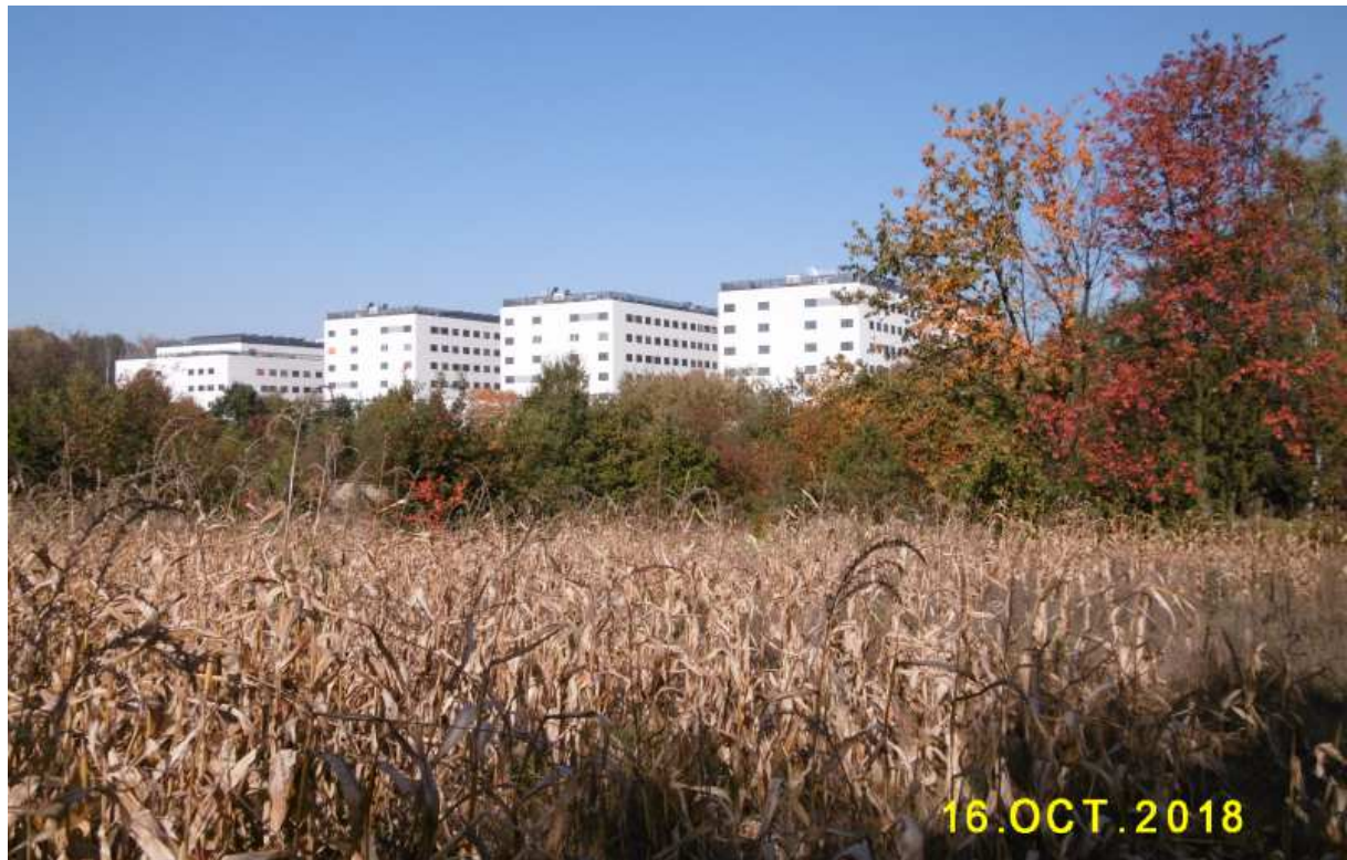
Fot. nr 479 (479-481). Niemal gotowy kompleks szpitalny UJ w ujęciach od strony ulicy Kosocickiej.
