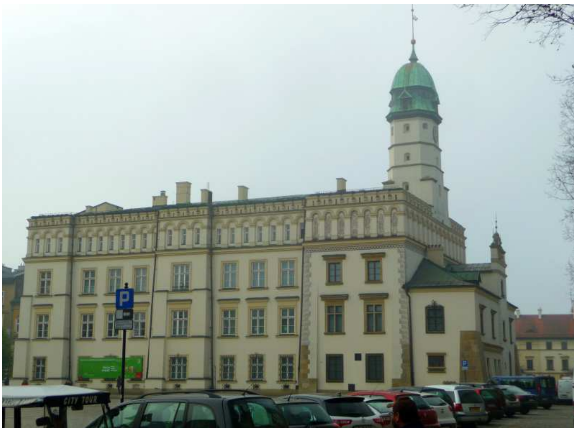
Fot. nr 183 (182-183). Ujęcia z wylotu ulicy św. Wawrzyńca. (07.11.2018)
