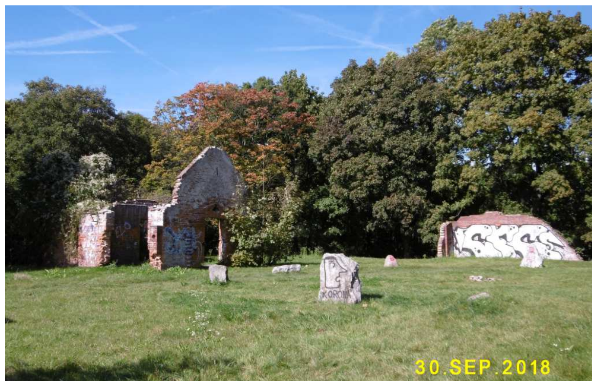
Fot. nr 316 (316-319). Ruina dawnej prochowni z czasów Twierdzy Kraków w bliskości ulicy Swoszowickiej.
