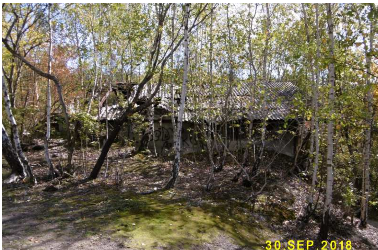
Fot. nr 337 (337-339). Kolejny fragment przardzewiałej i zdewastowanej instalacji przeróbczej od strony Kopca Kraka, która nie działa już od czasów III RP.
