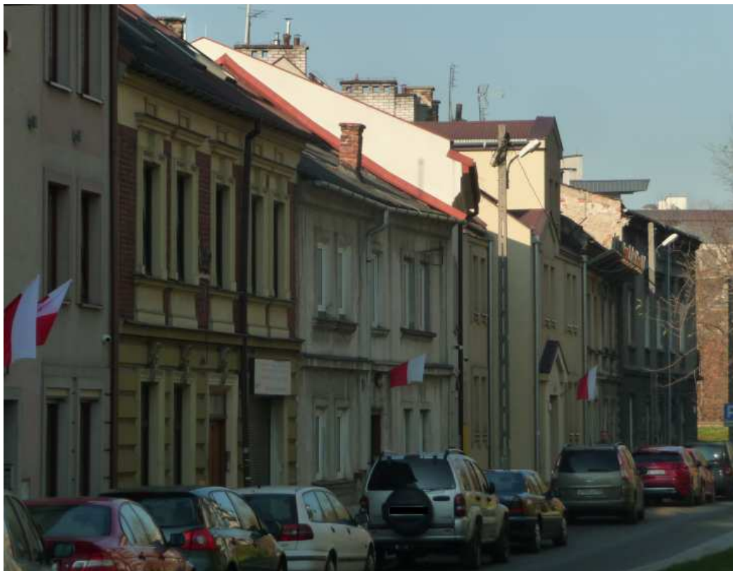
Fot. nr 69. Ujęcie z ulicy Orawskiej. (11.11.2018)
