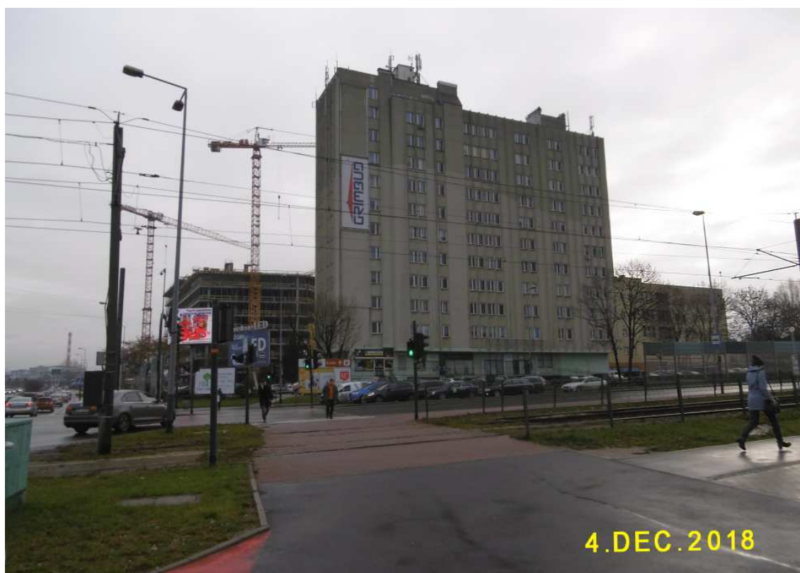
Fot. nr 515. Trwa zabudowa fragmentu ulicy Tischnera w sąsiedztwie ulicy Zakopiańskiej.
