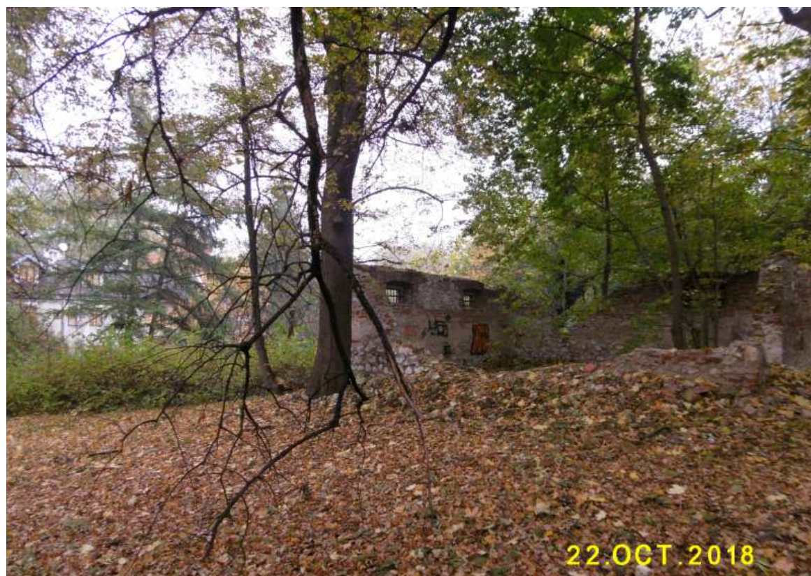
Fot. nr 396. Ruina budynku gospodarczego przy starym dworze Bemów.
