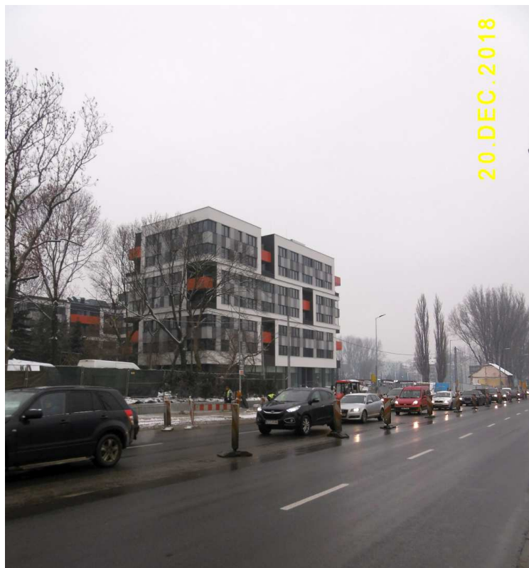
Fot. nr 353 (353-354). Wyburzony fragment ulicy Wielickiej jeszcze z domem pod nr 105 (w tle).
