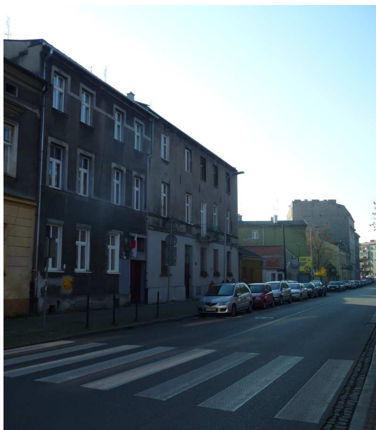
Fot. nr 276. Fragment zabudowy placu od nr 2 w ujęciu z ul. Warneńczyka. (11.11.2018)
