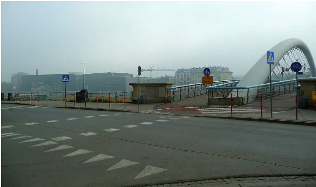
Fot. nr 196 (196-198). Kładka ojca Bernatka, która została zbudowana w miejscu starego mostu podgórskiego, na jego zachowanych przyczółkach. (07.11.2018)
