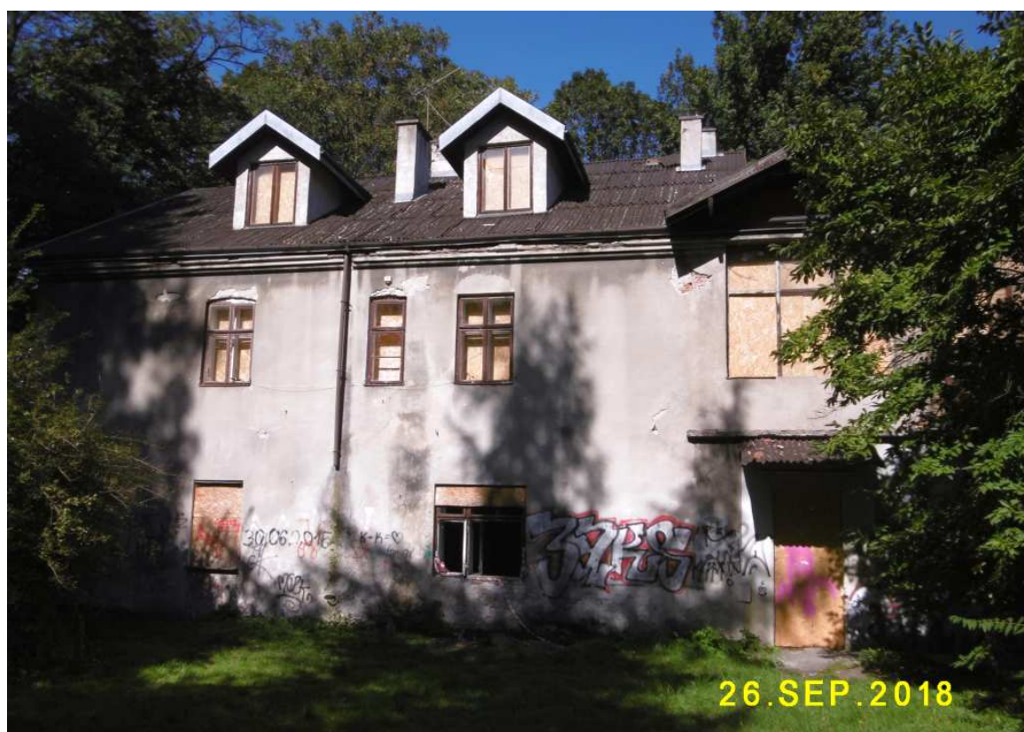
Fot. nr 397 (397-404). Kilka ujęć starego domu Bemów z ulicy Estońskiej (formalnie Mochnackiego 71). Fot. nr: 397-400 – fasada budynku.
