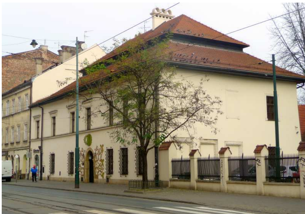
Fot. nr 203. Dom z pięknym, łamanym dachem z ulicy Krakowskiej 46. (07.11.2018)
