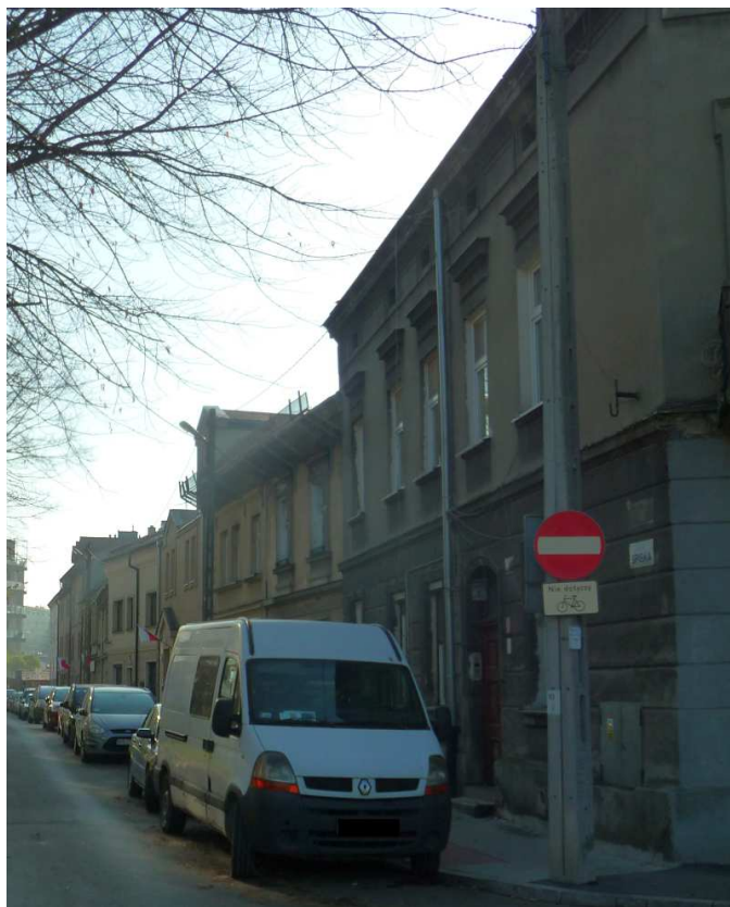
Fot. nr 70. Widok od strony Wilgi i ulicy Przedwiośnie. (11.11.2018)
