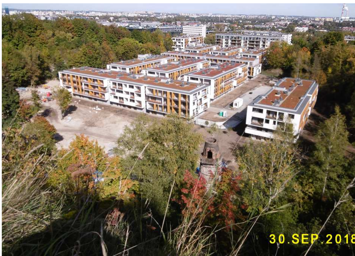
Fot. nr 296(296-299). Błokowisko „koncentracyjne” przy ulicy Wielickiej 57 w miejscu dawnego kamieniołomu miejskiego, gdzie w czasie II wojny światowej w katorżniczych warunkach pracowali i ginęli z wycieńczenia więźniowie z pobliskiego KL Płaszów
