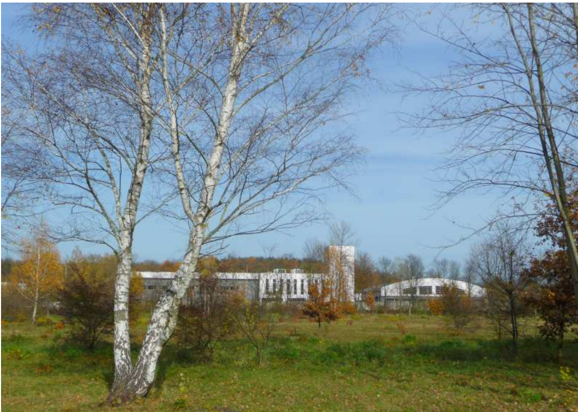
Fot. nr 125. Kompleks sportowy na terenie jednostki pychowickiej. (01.11.2018)
