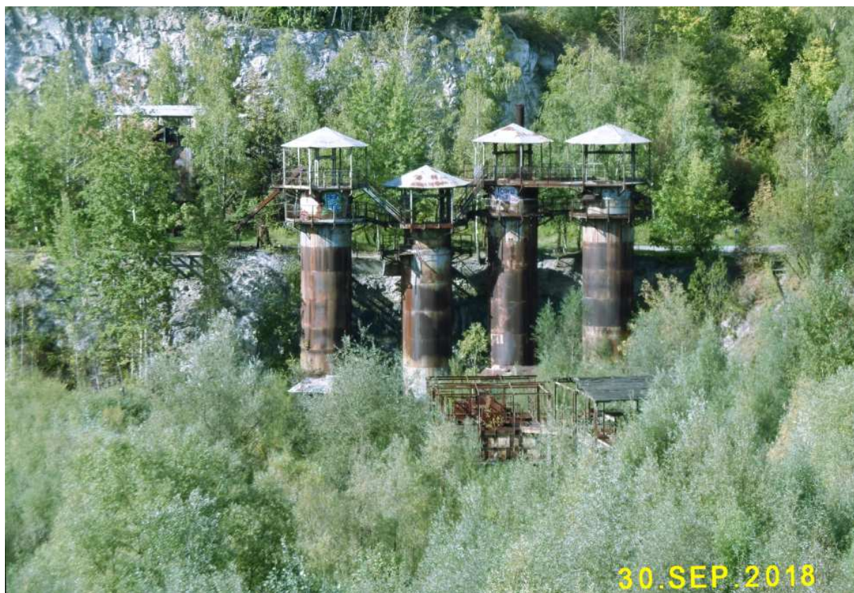
Fot. nr 333. Tyle dziś pozostało po instalacji przeróbki skały wapiennej na kruszywo.
