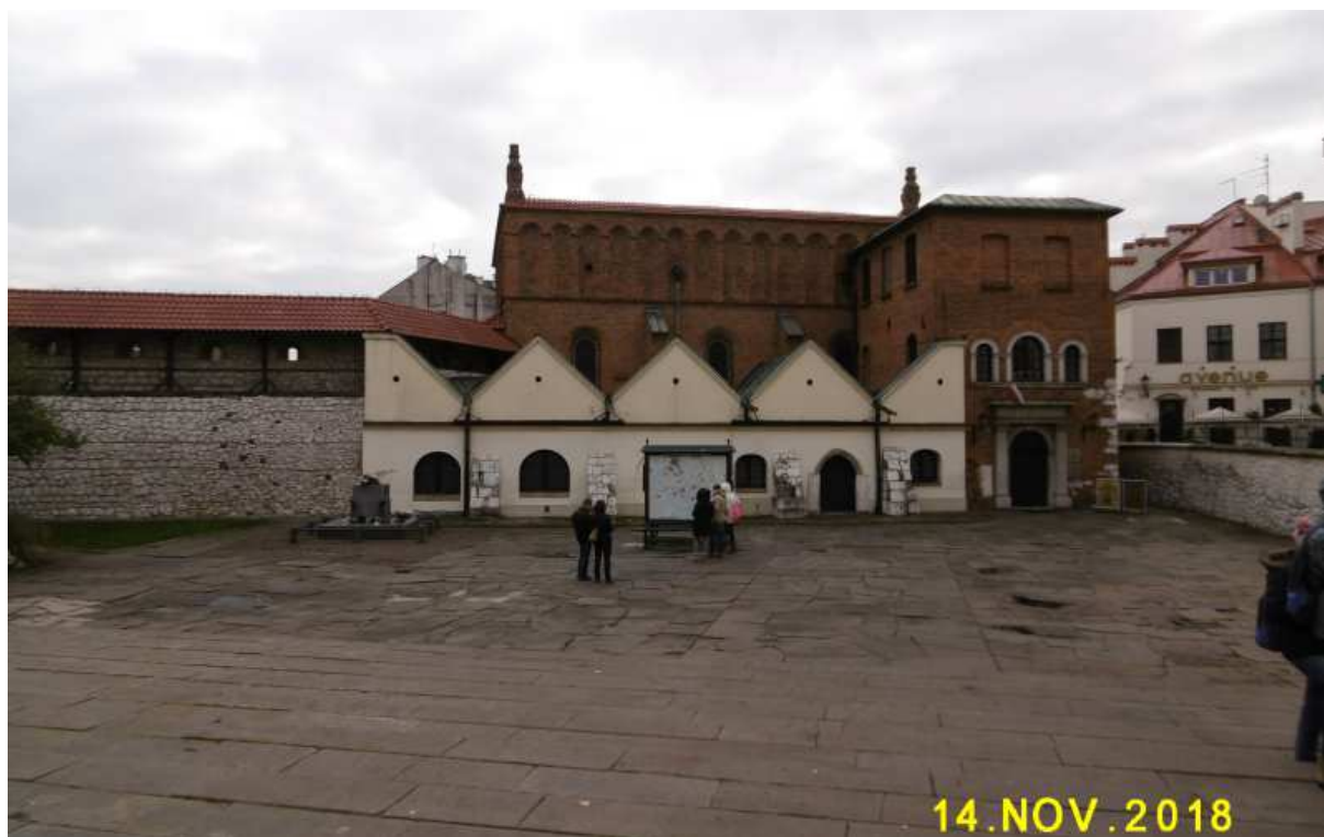
Fot. nr 142 (142-143). Stara Synagoga i przylegający do niej fragment muru obronnego.
