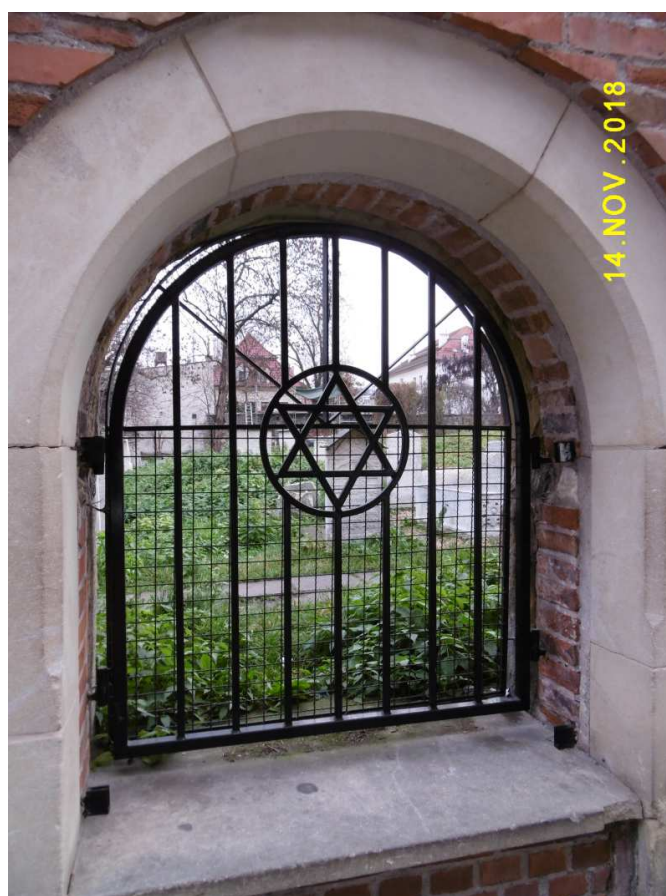
Fot. nr 133. Okno w murze cmentarnym.
