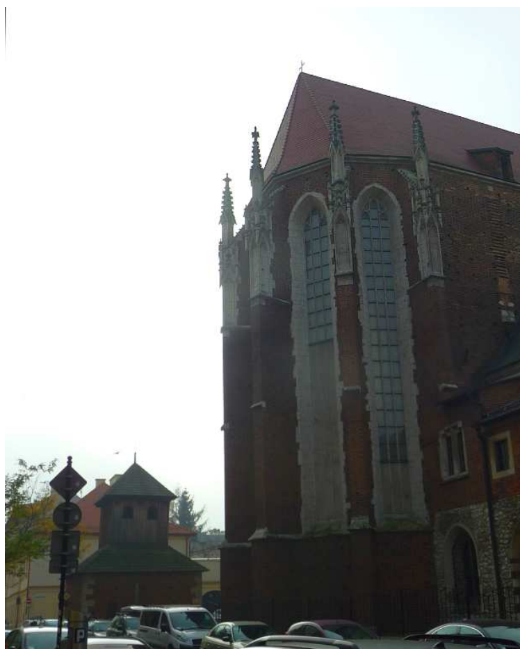
Fot. nr 237. Prezbiterium Kościoła św. Katarzyny i stara dzwonnica. (07.11.2018)
