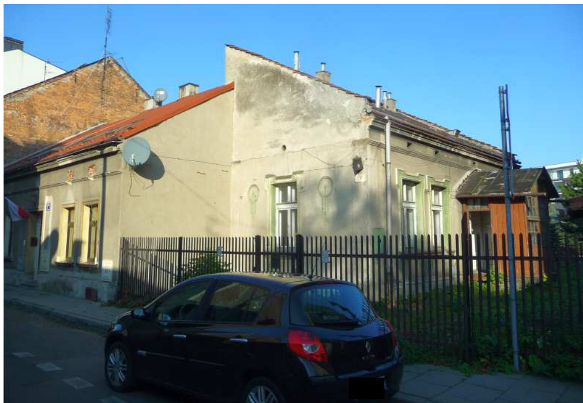
Fot. nr 79. Domy spod nr 7 i 9. (11.11.2018)
