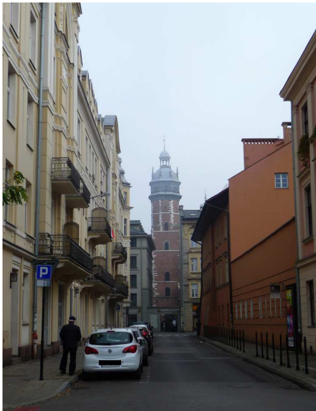
Fot. nr 238 (238-242). Różne ujęcia wieży i fasady kościoła Bożego Ciała od strony zachodniej. Fot. nr: 238-239 – ponad ulicą Skąleczną. (07.11.2018)
