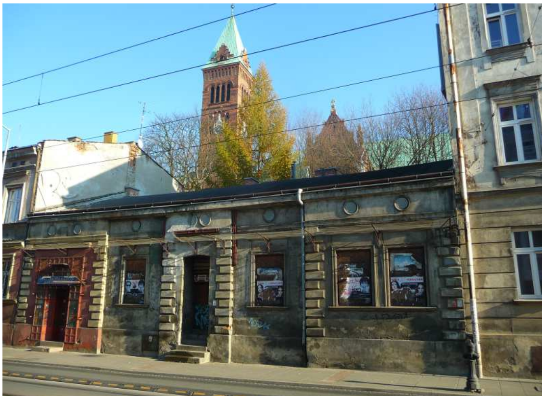
Fot. nr 257. Parterowy dom pod nr 55. Jak długo przetrwa? (11.11.2018)
