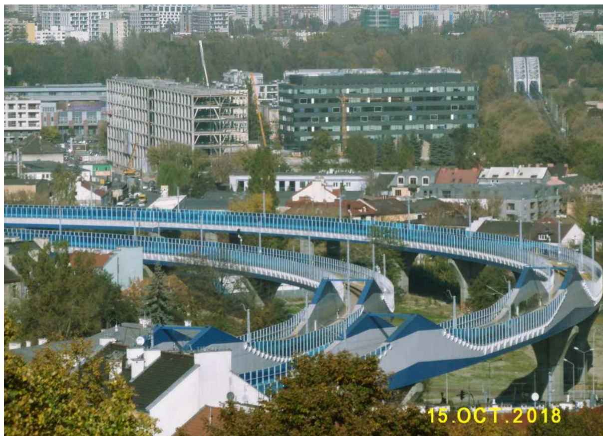
Fot. nr 291. Dawny budynek fabryczny Telpodu na etapie przebudowy na nowoczesny akademik.
