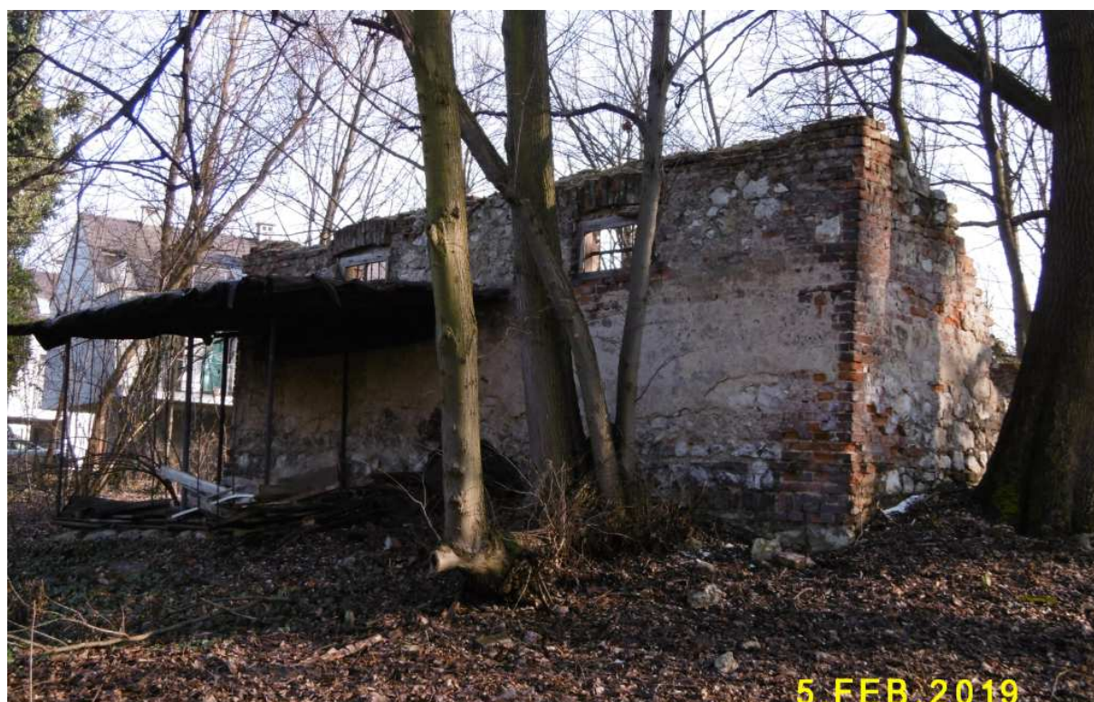
Fot. nr 345. Ruina budynku gospodarczego przy dworze Bemów w sąsiedztwie ulicy Łaszczki.
