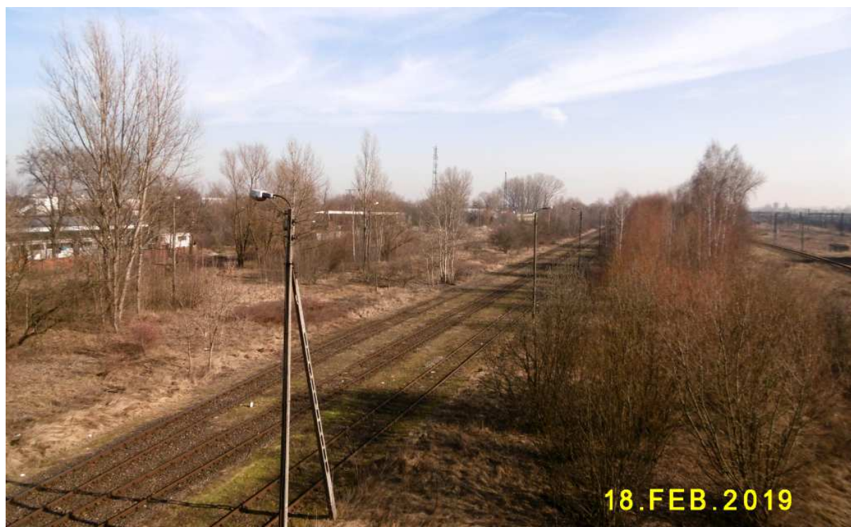
Fot. nr 403. Tory stacji rozrządowej w Prokocimiu w stronę ulicy Mierzeja Wiślana w ujęciu z kładki dla pieszych.
