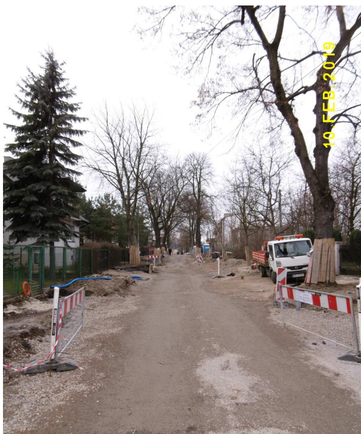
Fot. nr 393. Rozkopany początkowy fragment ulicy Dygasińskiego.
