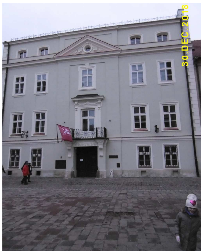
Fot. nr 28. Kamienica pod nr 9.
