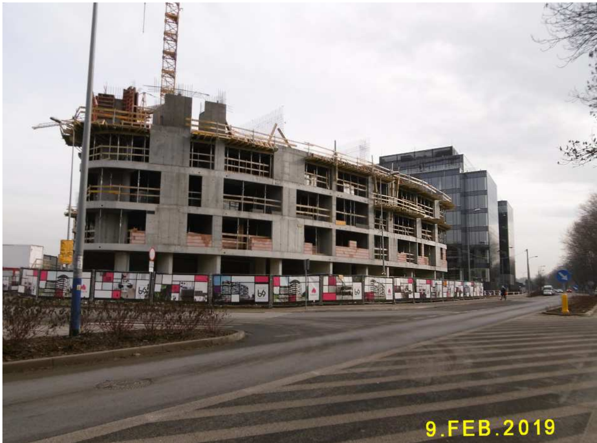
Fot. nr 290. Nowy betonowo-szklano-żelazisty twór na styku ulic: Konopnickiej i Barskiej, który powstaje w miejscu ludwinowskiego sadu.
