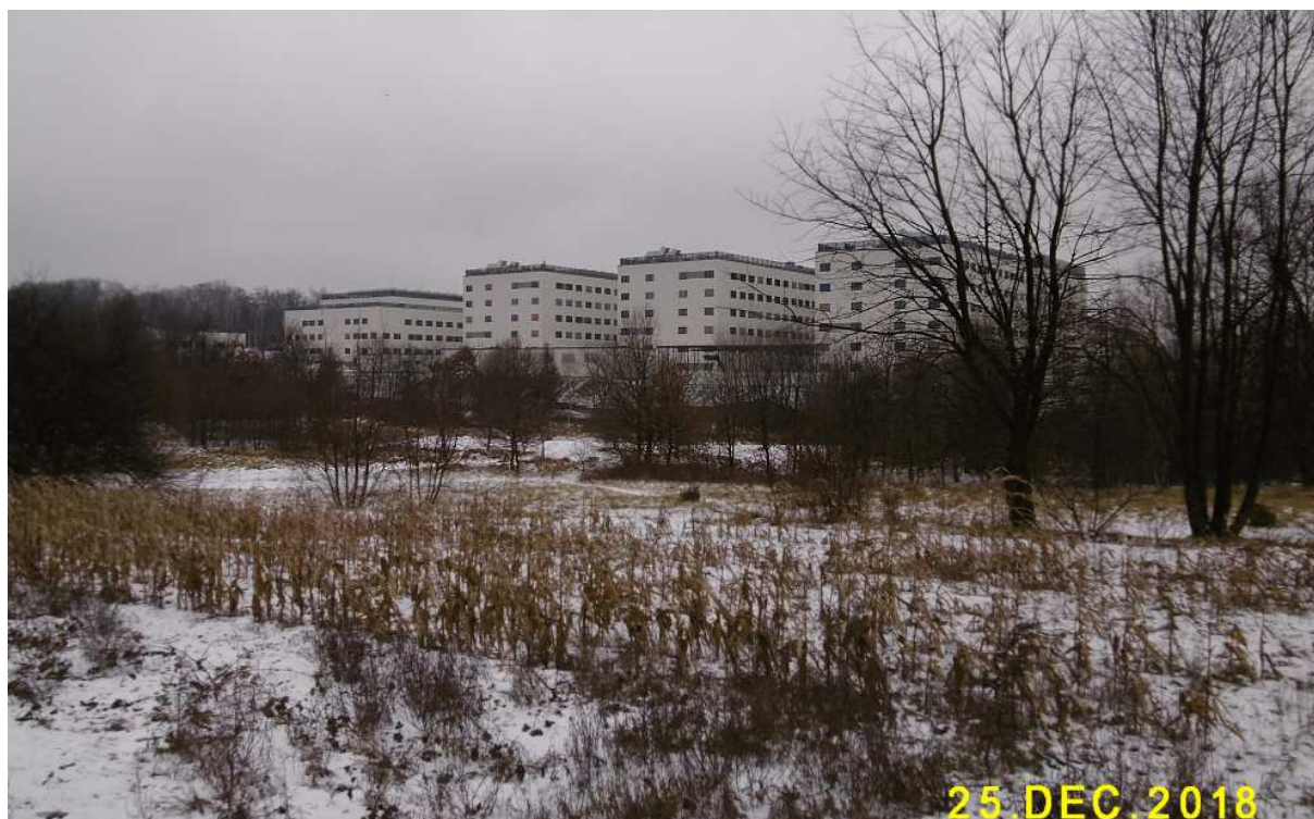
Fot. nr 428 (428-429). Niemal gotowy kompleks szpitalny UJ przy ulicy Jakubowskiego.
