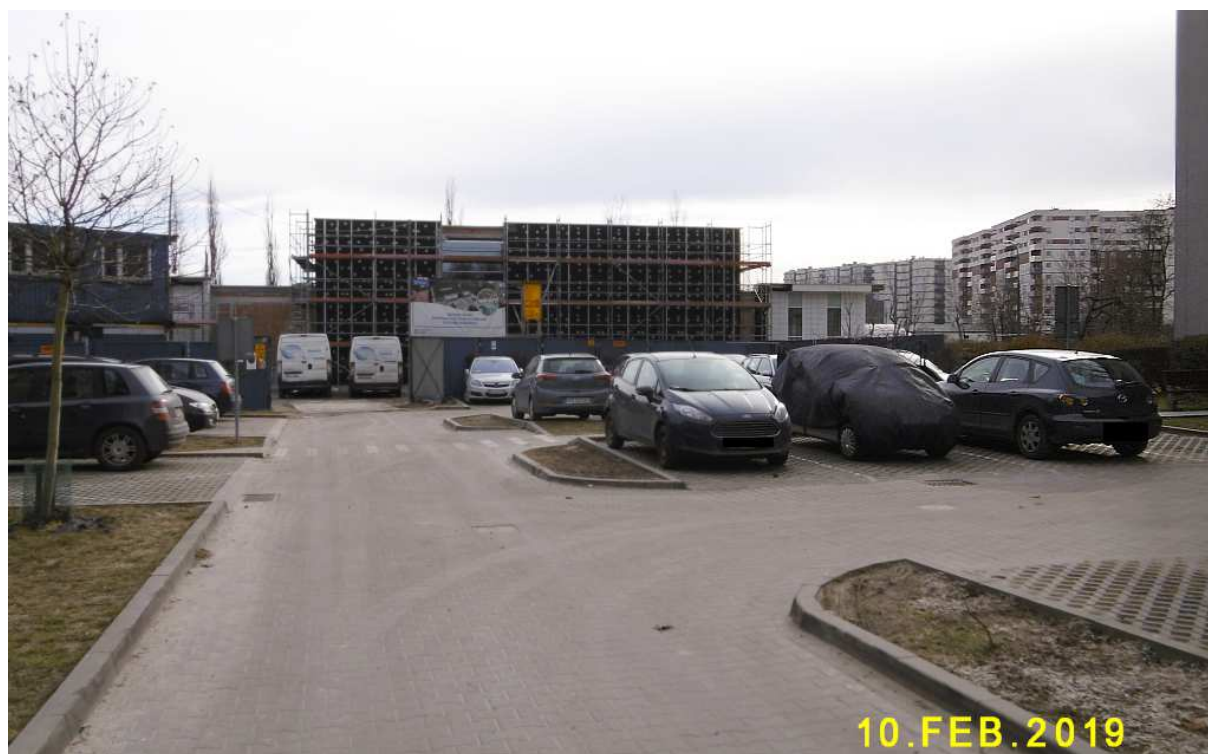
Fot. nr 382. Trwa budowa kompleksu basenu na zielonym skwerze przy ulicy Spółdzielców.
