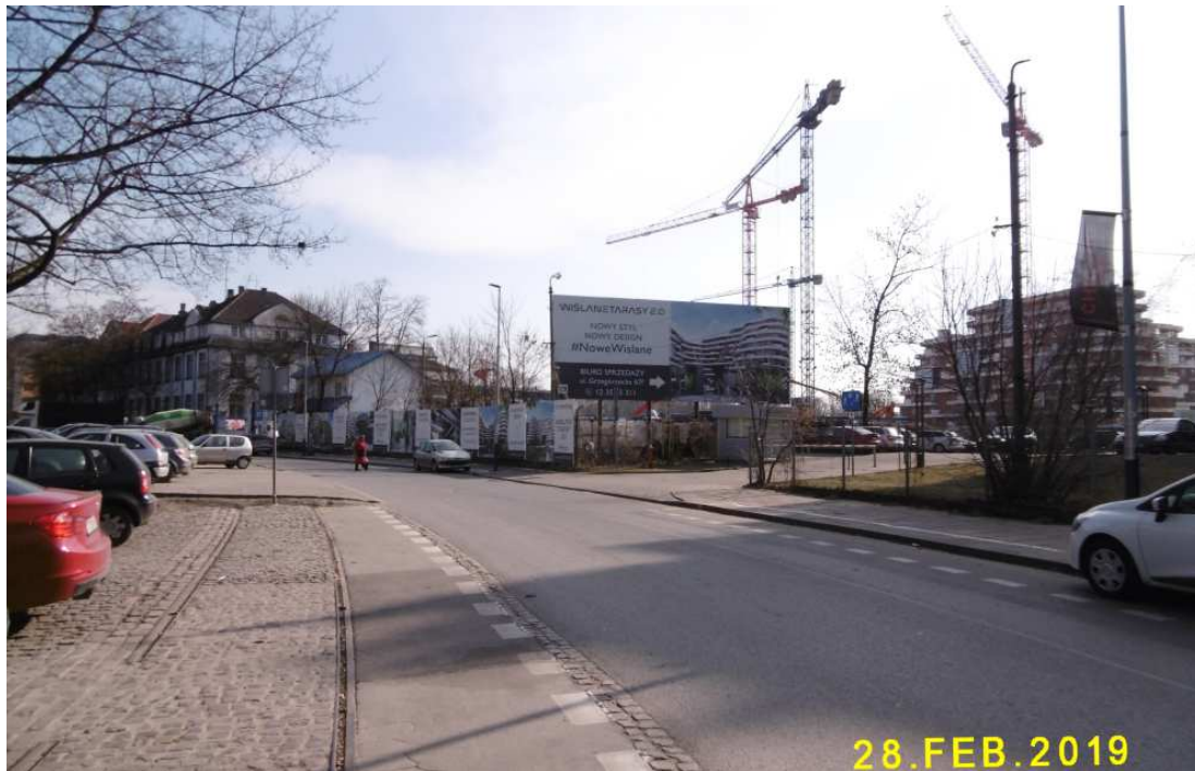
Fot. nr 152 (152-158). Wzdłuż ulicy Grzegórzeckiej. Z prawej trwa zabudowa terenu po dawnych zakładach Zieleniewskiego pod nr 69.
