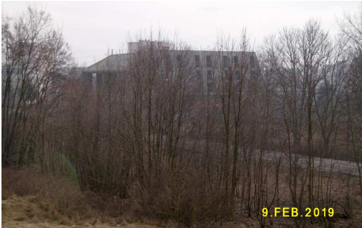
Fot. nr 278. Trwa budowa bunkrowatego budynku na styku ulic: Norymberskiej i Pychowickiej – widok ze skarpy zalewu.
