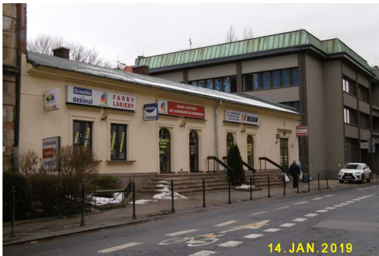
Fot. nr 185. Parterowy dom pod nr 11.
