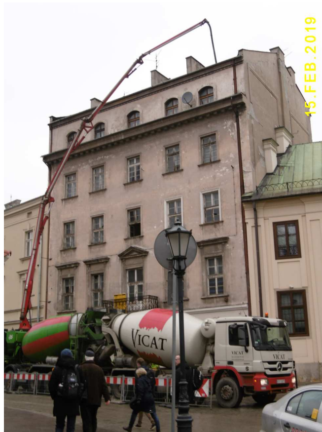
Fot. nr 6. Kamienica pod nr 14 na etapie remontu.
