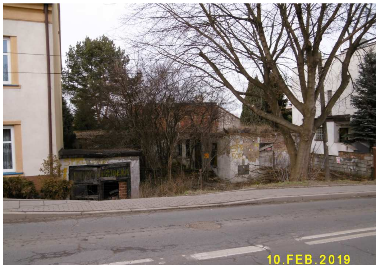
Fot. nr 397. Ruina domu pod nr 3.
