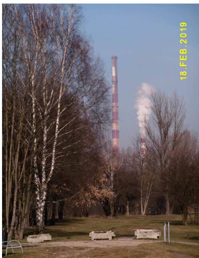
Fot. nr 365. W stronę elektrociepłowni w Łęgu.
