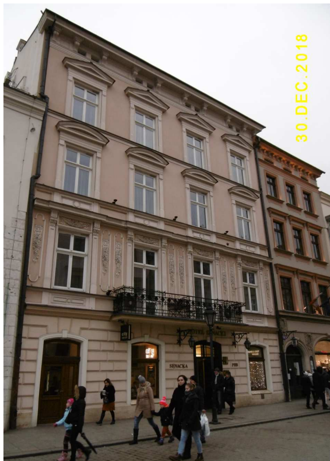
Fot. nr 16. Kamienice pod nr: 49 i 51.
