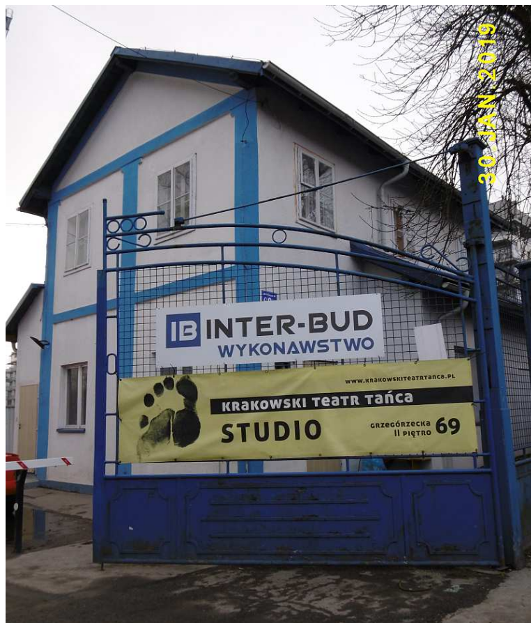
Fot. nr 154 (154-155). Przy bramie wjazdowej.
