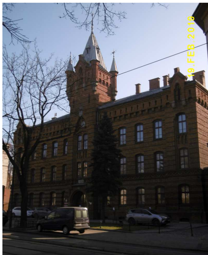
Fot. nr 125 (125-126). Budynek Straży Pożarnej pod nr 19.
