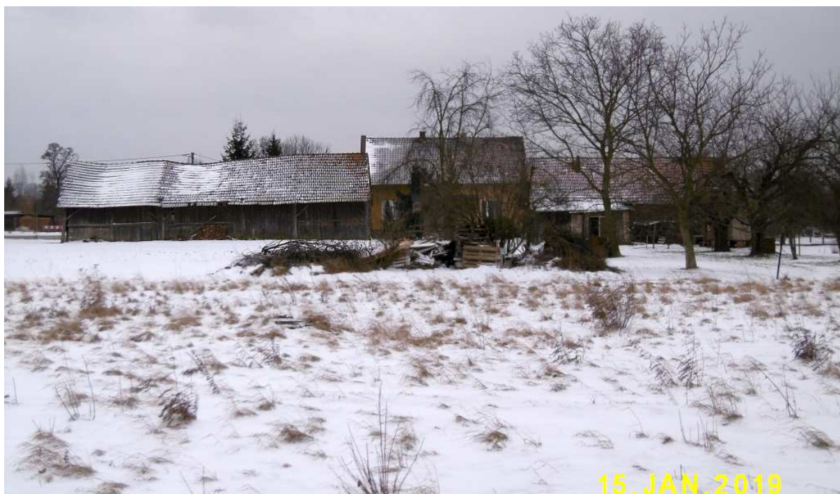
Fot. nr 407 (407-408). Może to już ostatnia zagroda w tej okolicy, przy ulicy Przewiewnej 9-11?
