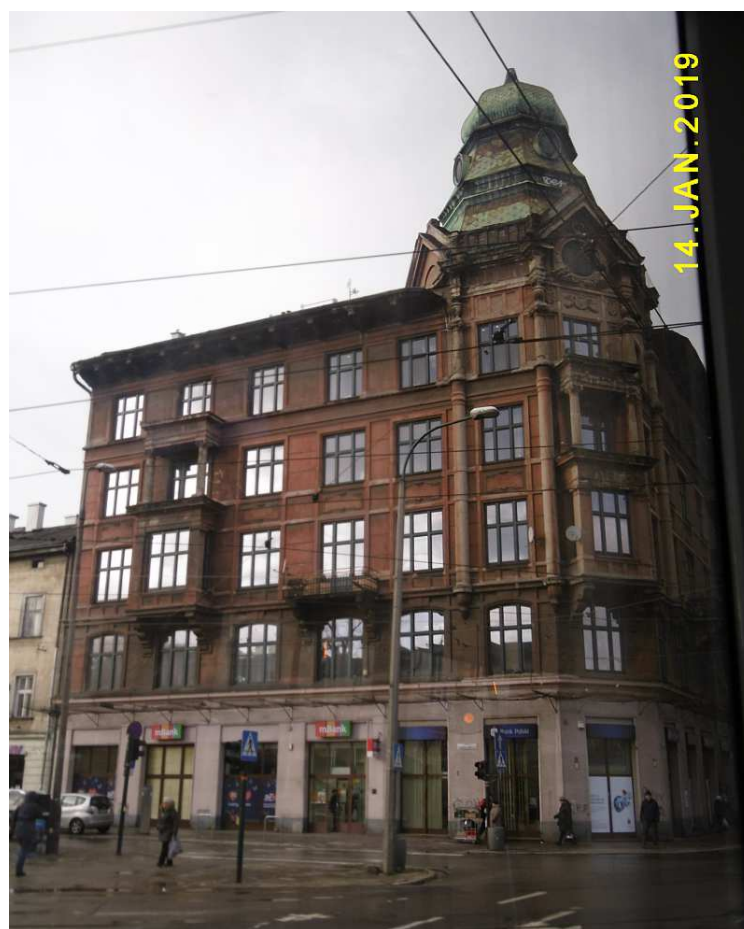
Fot. nr 302. Pełna architektonicznej ekspresji, choć pozbawiona iglicy, kamienica Ohrensteina z ulicy Dietla 42, która od lat nie może się doczekać sensownego remontu.
