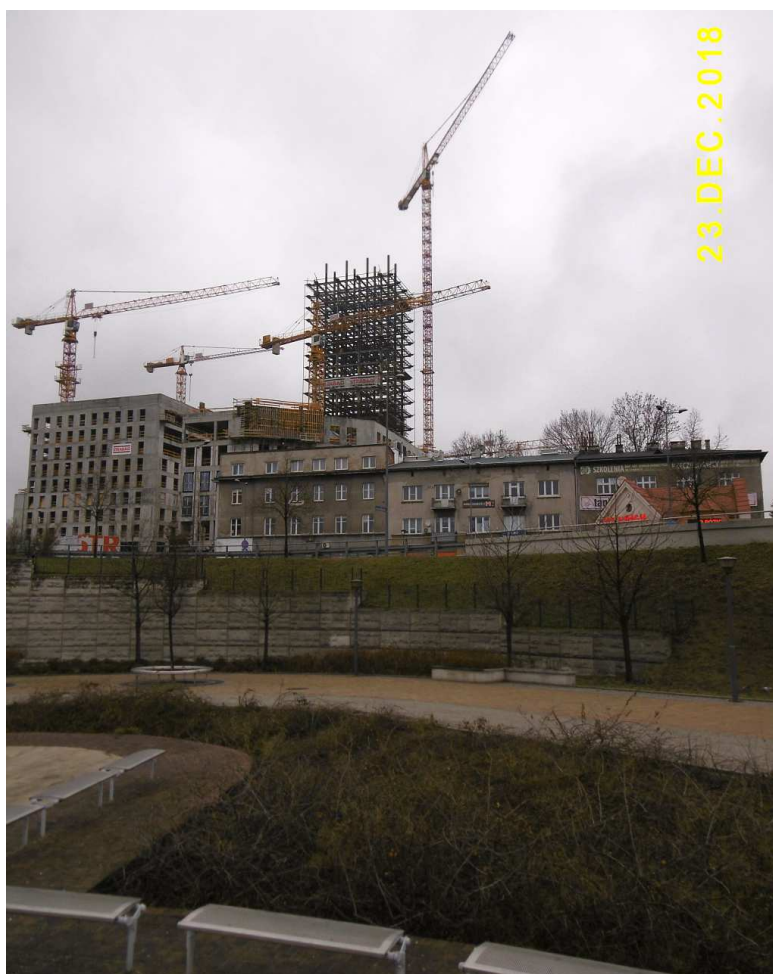
Fot. nr 138 (138-141). Kilka ujęć konstrukcji „szkieletora” i obrastającego go gmachu o wielkiej kubaturze. Ujęcie spod ruin fortu mogilskiego.
