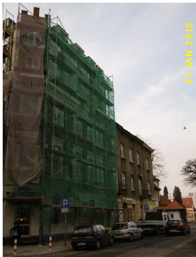
Fot. nr 231. Fragment ulicy Borelowskiego o nr: 22 i 24.
