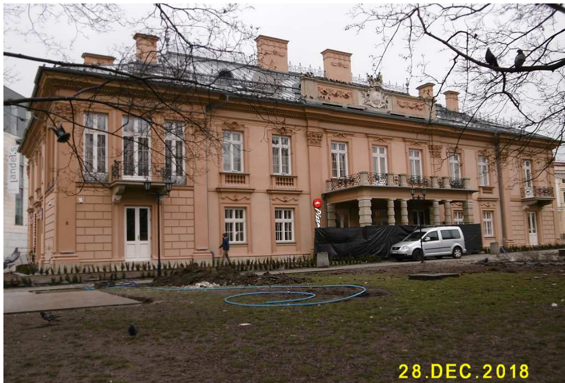
Fot. nr 136 (136-137). Pałac Wołodkowiczów z ulicy Lubicz 4 tuż po remoncie.
