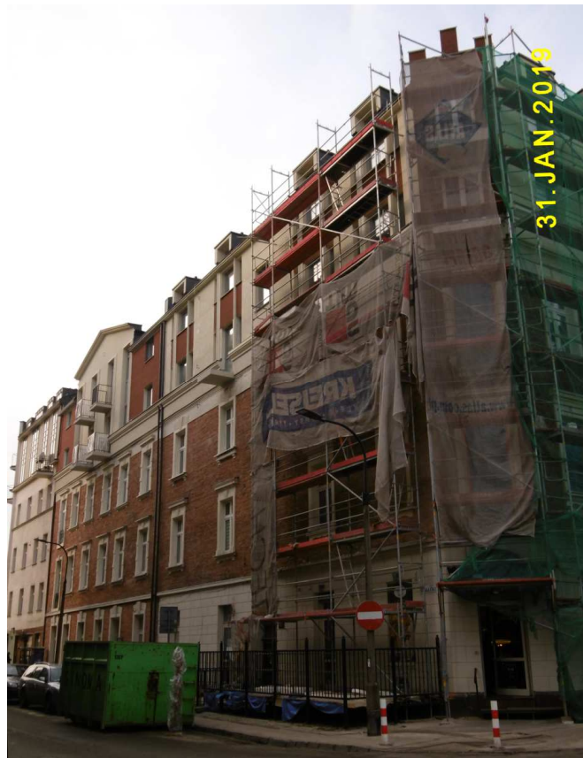
Fot. nr 230. Demolka architektoniczna kamienic ulicy Stachowicza: 13-17.
