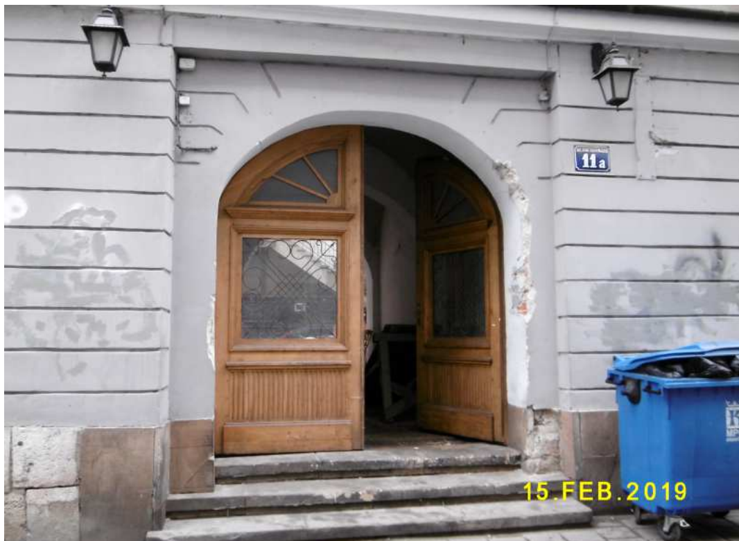
Fot. nr (107-108). Kamienica pod nr 11a i jej podwórko.
