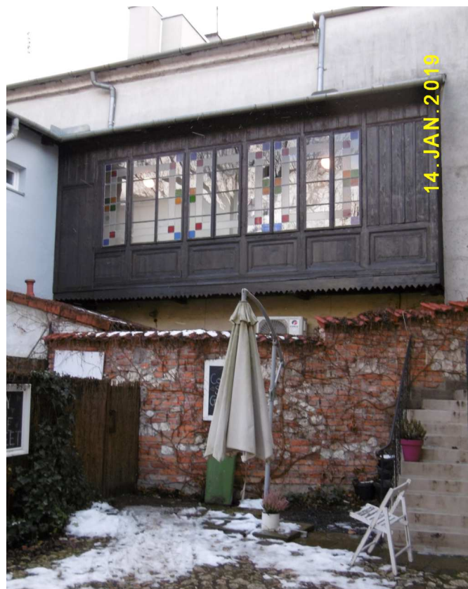
Fot. nr 208 (208-209). Podwieszane ganki.
