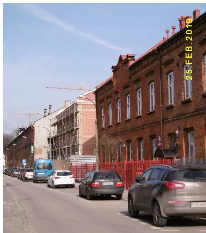
Fot. nr 147. Fragment od budynku SP nr 38 pod nr 15.
