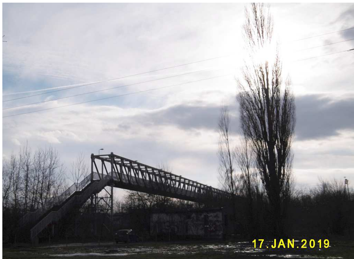
Fot. nr 360. Kładka dla pieszych nad torami kolejowymi.
