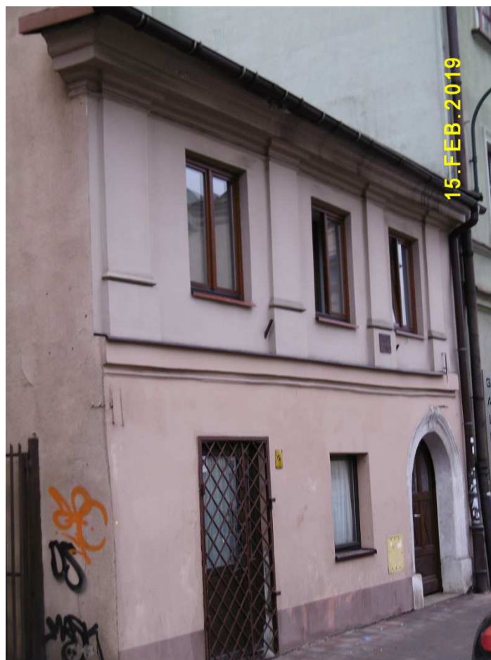
Fot. nr (187-190). Wiekowy domek z roku 1826 spod nr 22, na który już został wydany wyrok oraz jego tylna część, oficyna i podwórko.
