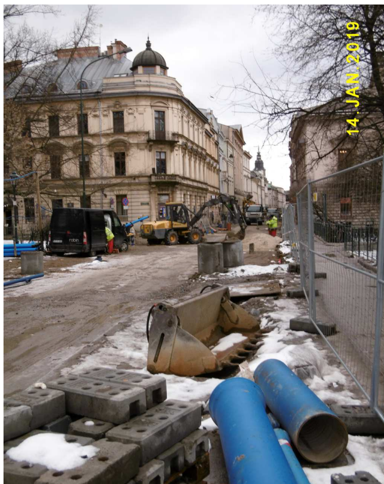
Fot. nr 95. Ulica Sławkowska na etapie remontu.
