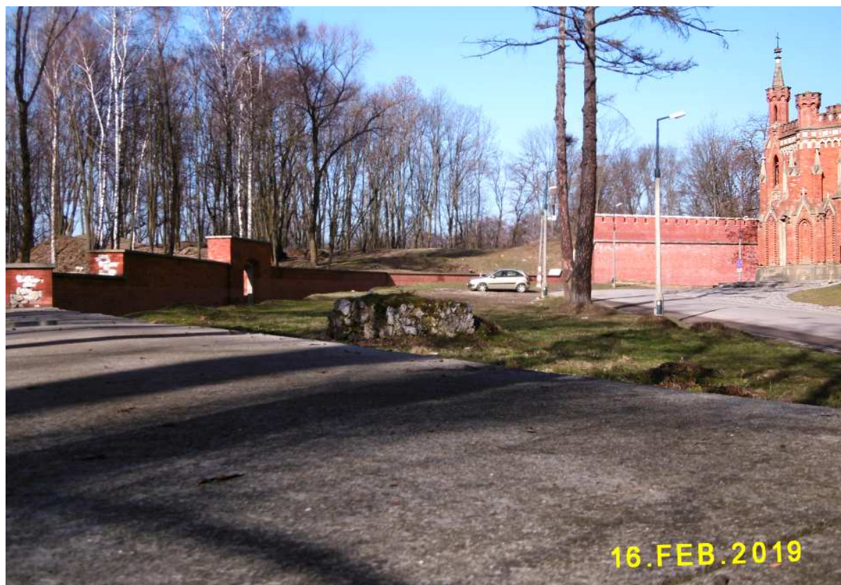
Fot. nr 240(240-241). Odtworzony narys kurtyny I-II i ściana wewnętrzna bastionu nr II.
