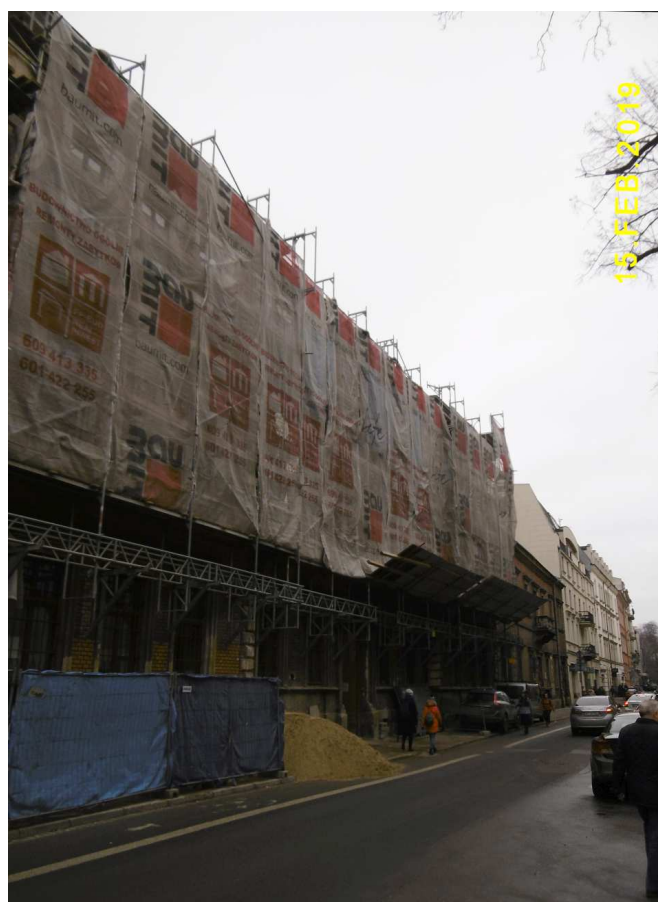
Fot. nr 213 (213-216). Ulica Krupnicza. Tu remont i rozbudowa kamienicy pod nr 11a.
