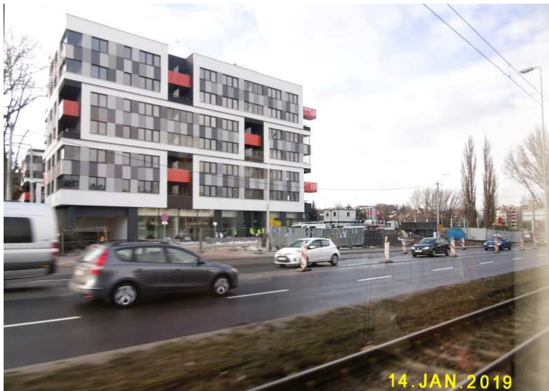
Fot. nr 320 (320-322). Właśnie znikł fragment zabudowy ulicy Wielickiej o podmiejskim charakterze pod nr 105-111. I tam powstanie nowe blokowisko.
