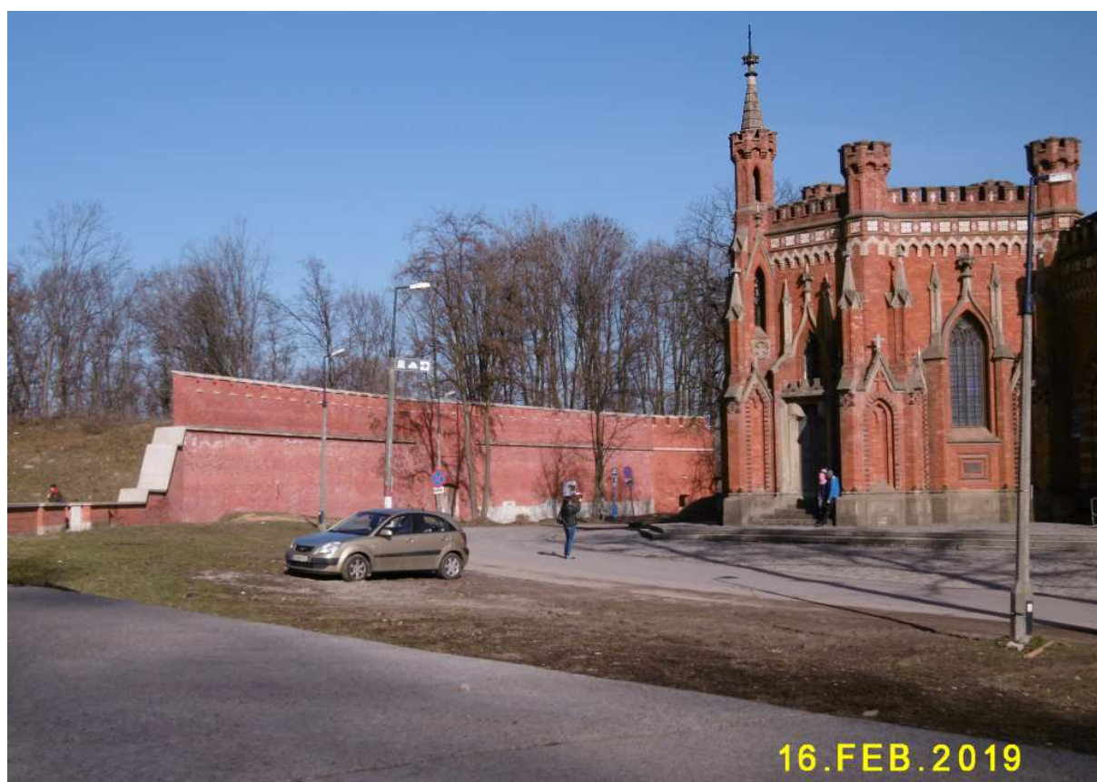
Fot. nr 241. Ściana wewnętrzna bastionu nr II obok kapliczki św. Bronisławy.
