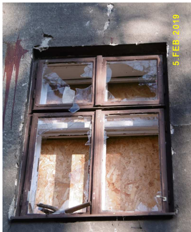
Fot. nr 349. Oryginalne okno sprzed ok. 90 lat.
