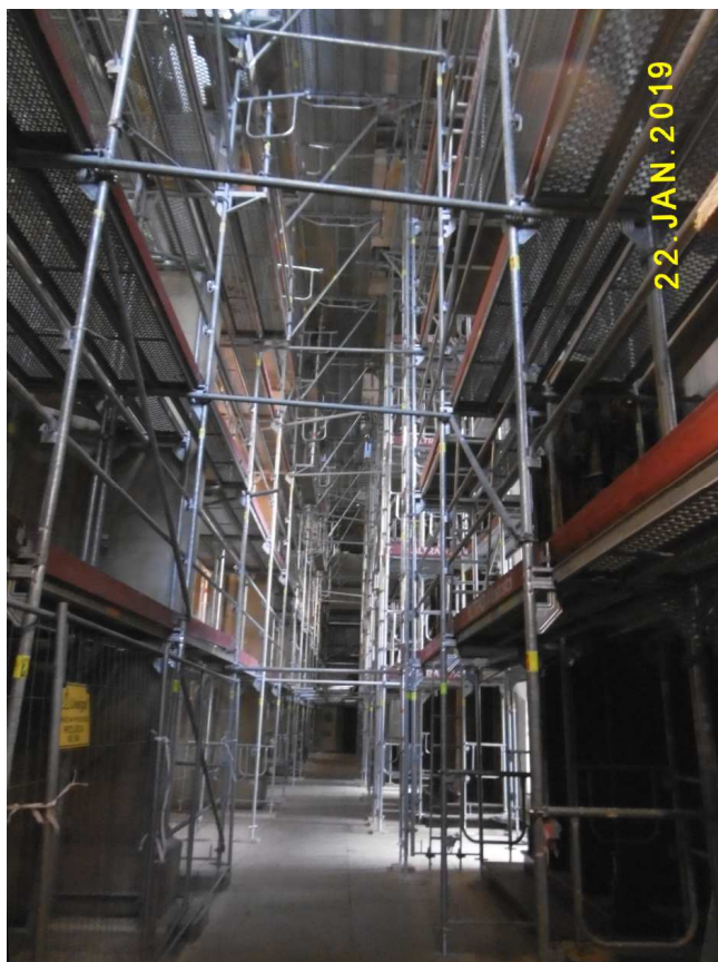
Fot. nr 13. Nawa boczna kościoła Dominikanów na etapie prac konserwacyjnych.
