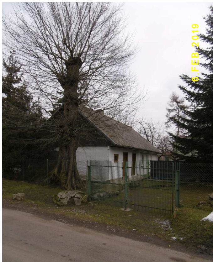
Fot. nr 172. Chałupa z ulicy Fatimskiej 11 od strony ulicy Szybkiej.
