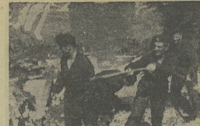
Tak jak na wielu naszych budowach — tak i na przebudowie skoczni Wielka Krokiew w Zakopanem — odnajdziemy naszych żołnierzy. fot. CAF — Memo
