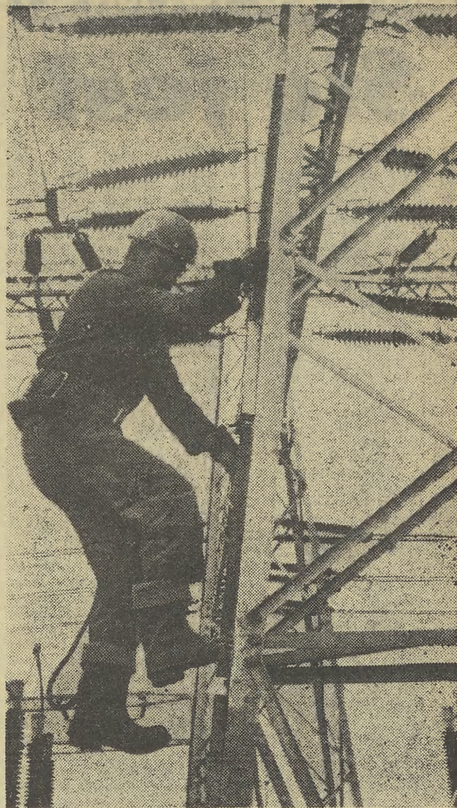
Montaż konstrukcji stalowych dla elektrowni szczytowo-pompowej „ŻARNOWIEC”. CAF — Ukolewski
