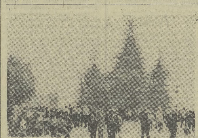
W związku z przewidywanym napływem turystów w okresie Igrzysk Olimpijskich 1980 w Moskwie liczne zabytki tego miasta poddane zostały ostatnio pracom konserwatorskim. Na zdj.: cerkiew na Placu Czerwonym w remoncie. CAF — WALCZAK
