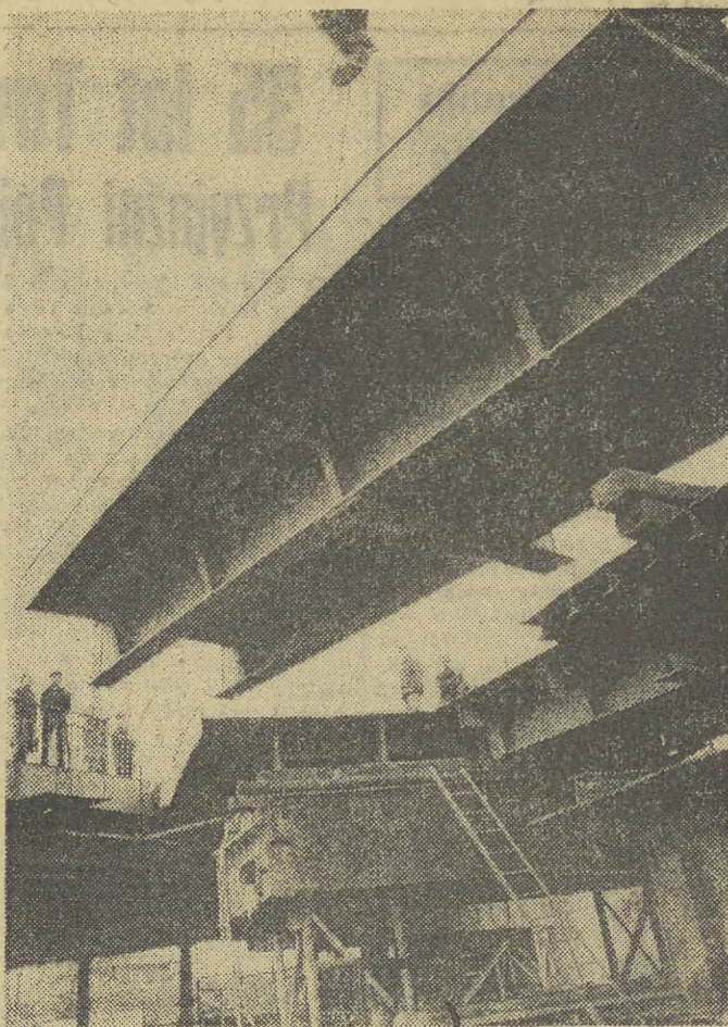
Montaż konstrukcji estakady.
