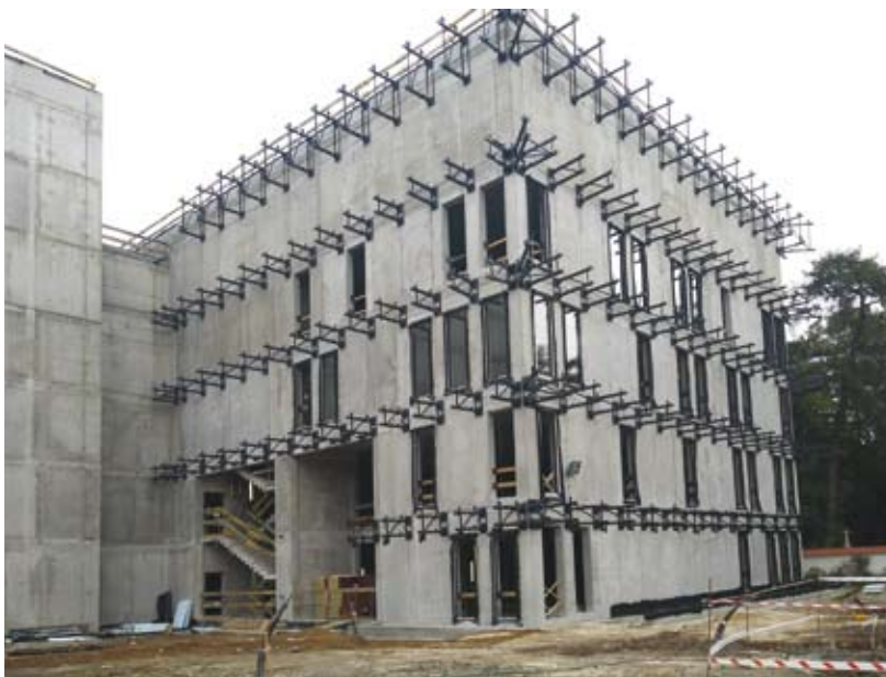
23. Budowa nowej siedziby Archiwum Narodowego w Krakowie. Segment biurowy wraz z podkonstrukcją do szklanej fasady, stan z października 2018 r. (fot. Paweł Ząbczyński)
