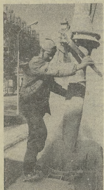
Śląskie Zakłady Przemysłu Wapienniczego w Tarnowie Opolskim: zakładunek na cysterny samochodowe mielonego wapna palonego. Fot. CAF
