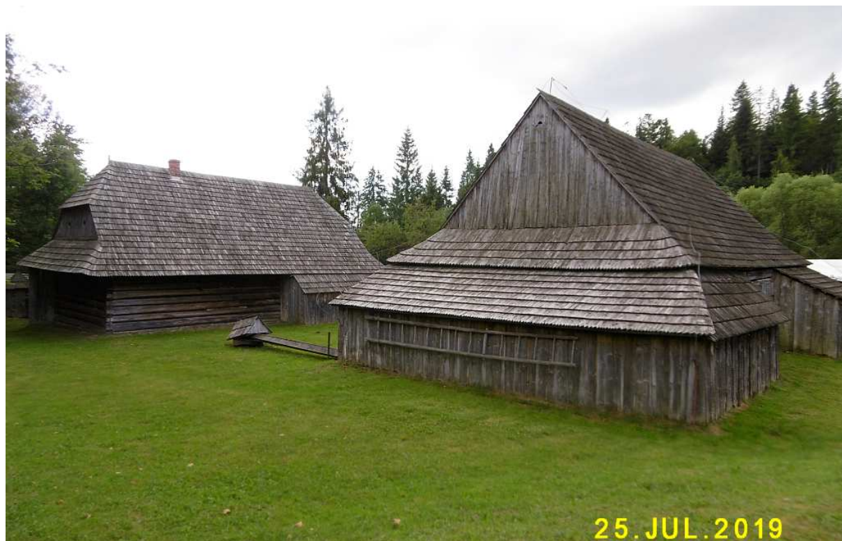
Fot. nr 197 (197-207). Zagroda Misińców zachowana „in situ” (nr 21), pochodząca z przełomu XIX i XX wieku. Tu widok z drogi.
