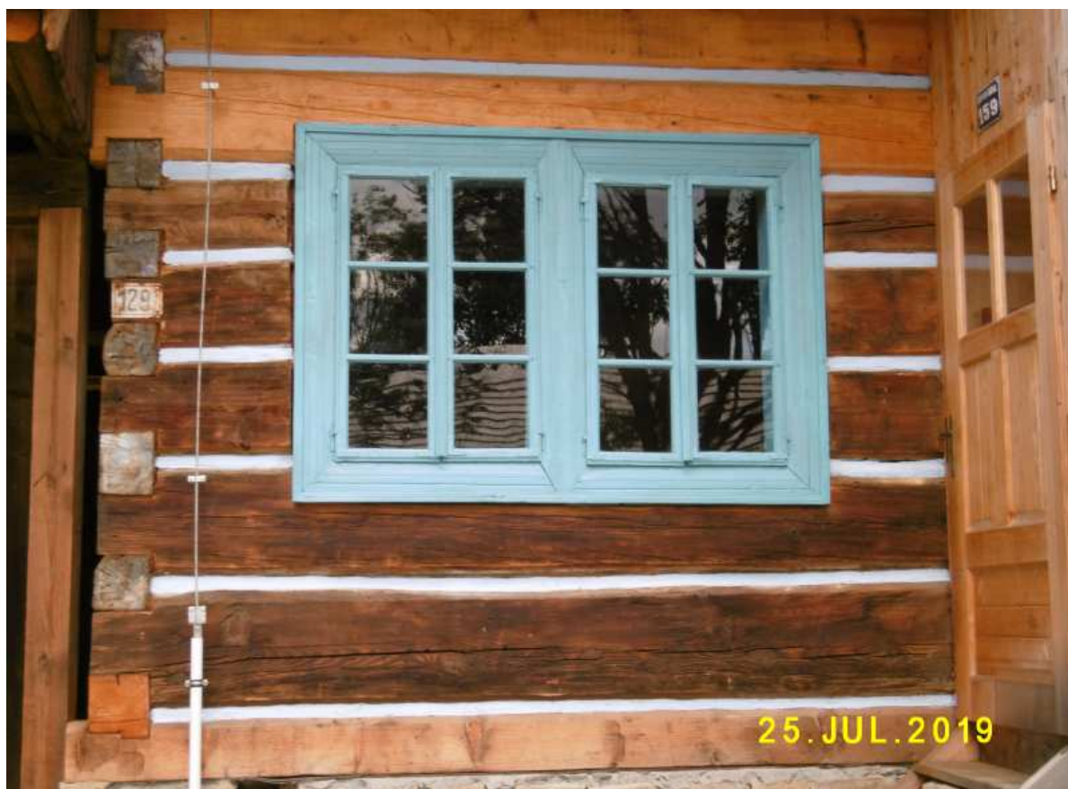
Fot. nr 145 (145-146). Oryginalne okna o cienkich szprosach, otwierane na zewnątrz.
