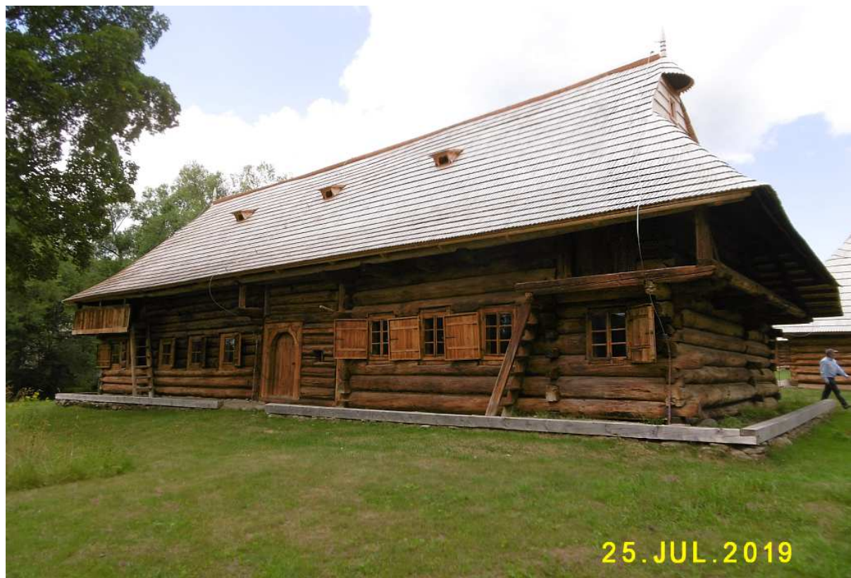
Fot. nr 36 (36-67). Dwór Moniaków wg stanu po rozbudowie w roku 1784, jego wnętrze i gospodarcze zaplecze (nr 6) – tu jego fasada.
