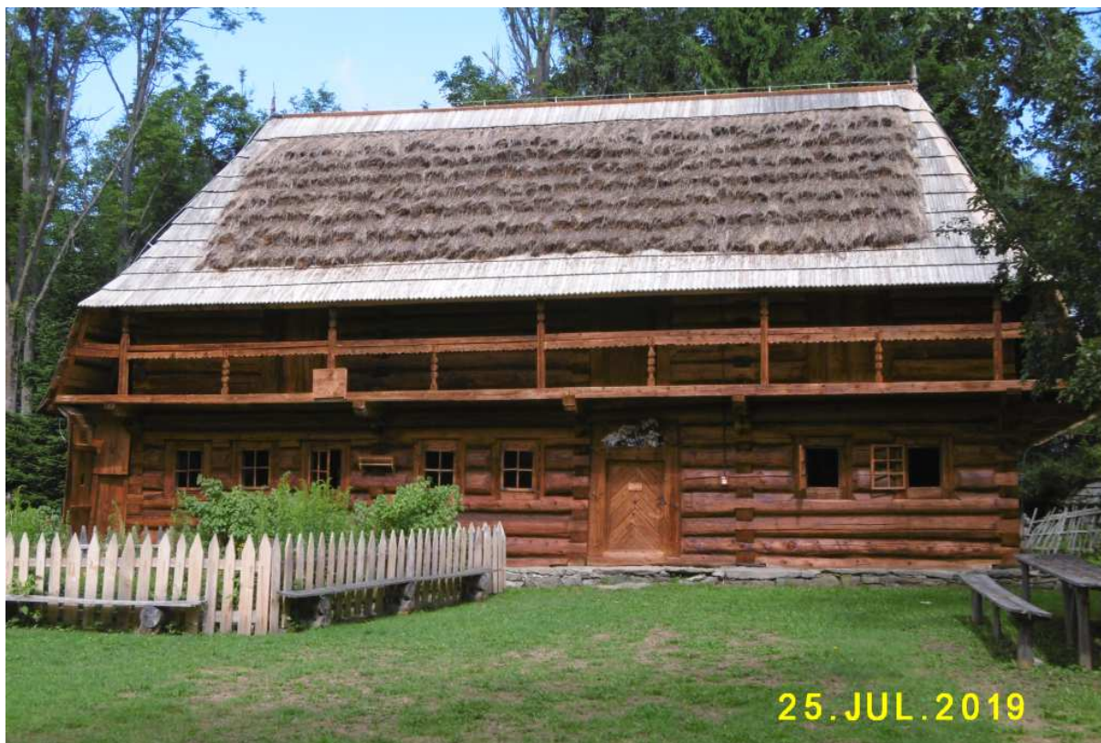
Fot. nr 18. Chałupa Alojzego Dziubka z Jabłonki – XIX-wieczny budynek z „wyżką”, spichlerzem na piętrze (nr 3).
