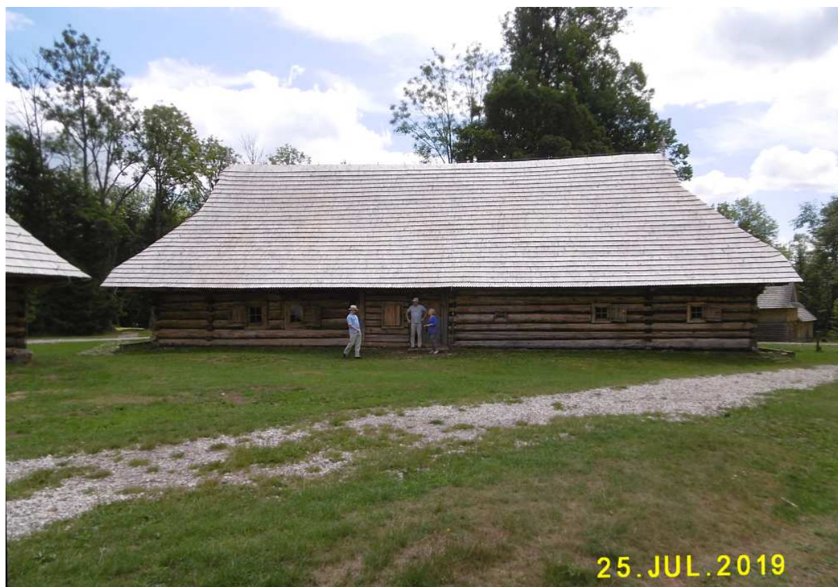
Fot. nr 38. Tylna część dworu.
