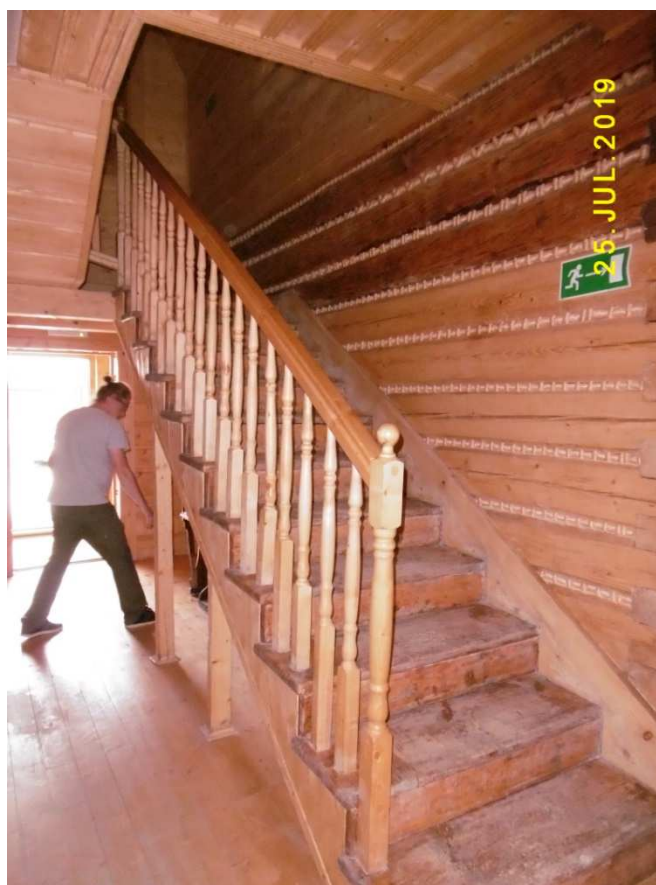
Fot. nr 88. Klatka schodowa sieni.
