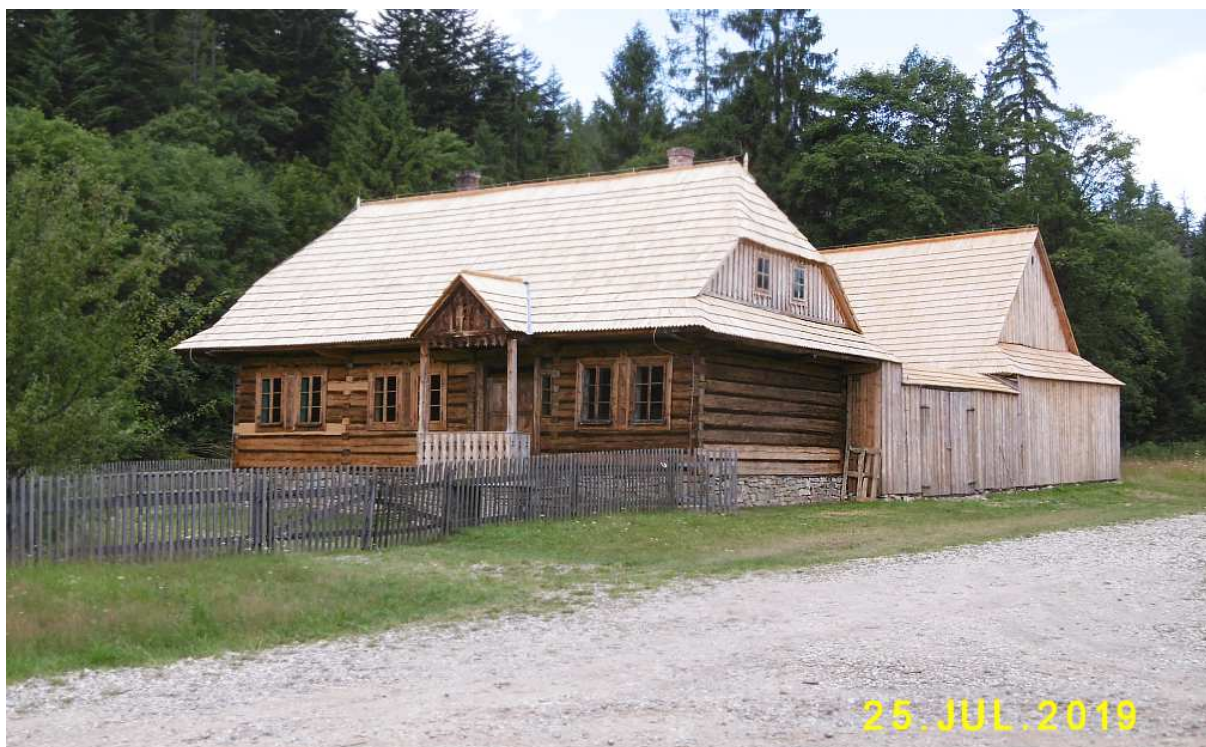
Fot. nr 120 (120-125). Dom z portykiem.
