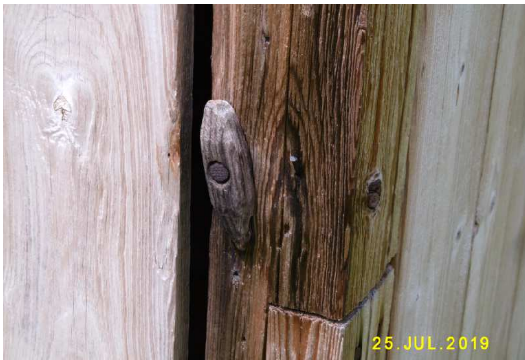
Fot. nr 65. Zamknięcie „przybytku ulgi”.
