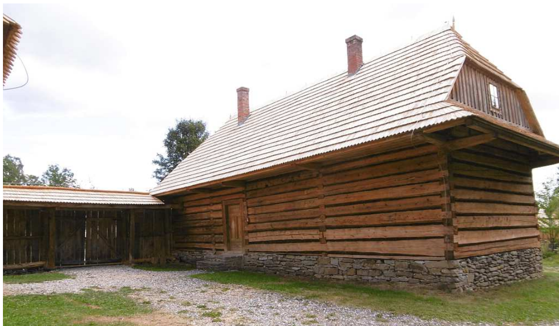
Fot. nr 124 (124-125). Tylna część.
