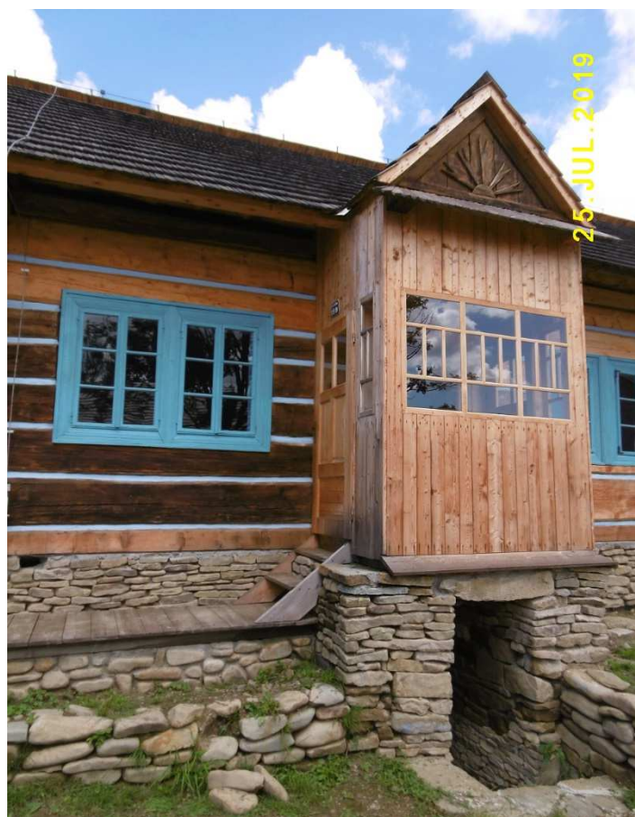
Fot. nr 144. Kryty ganek przy wejściu do części mieszkalnej.
