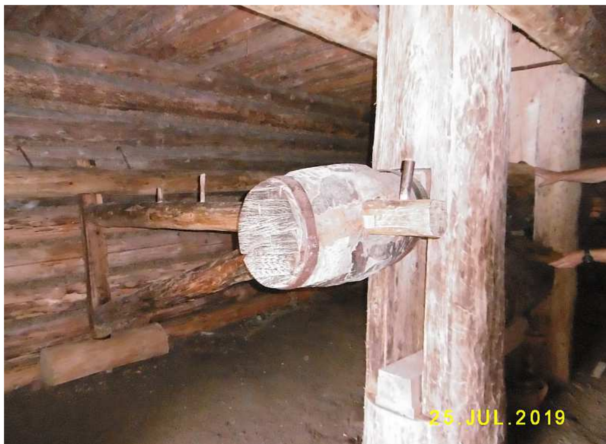
Fot. nr 72 (72-74). We wnętrzu olejarni. Fot. nr: 72 i 73 – „wybijac”.
