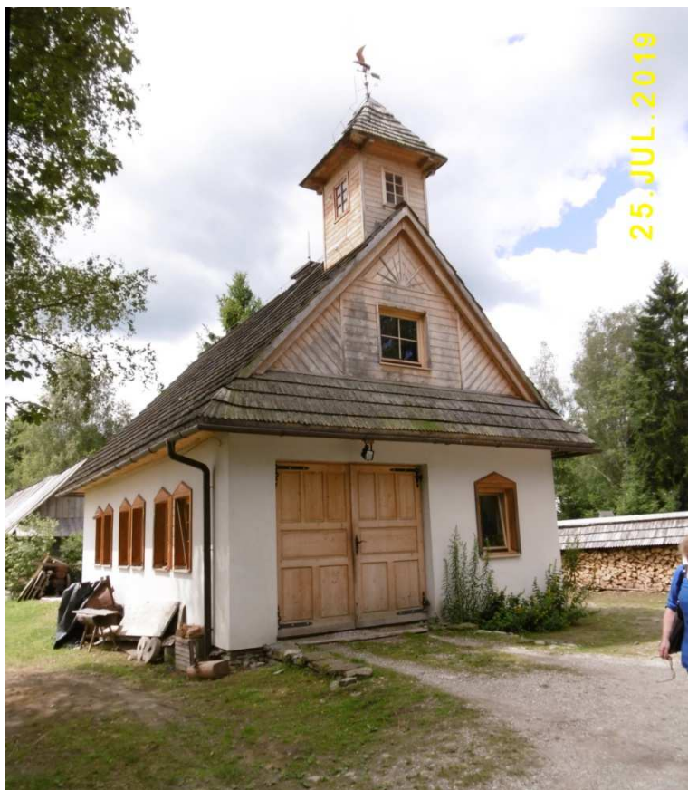
Fot. nr 75 (75-76). Remiza strażacka, kopia budynku z Harkabuza – nowy obiekt w skansenie.
