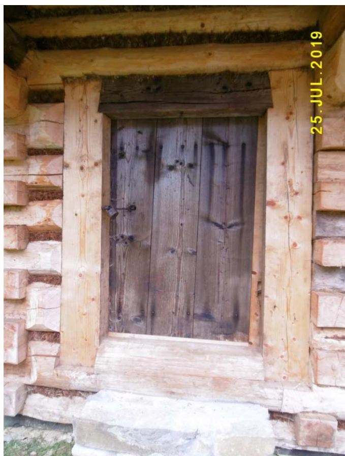
Fot. nr 176. Tylne wejście
