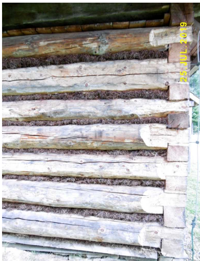
Fot. nr 184. Uszczelnienie ścian chałupy „kicokami”.
