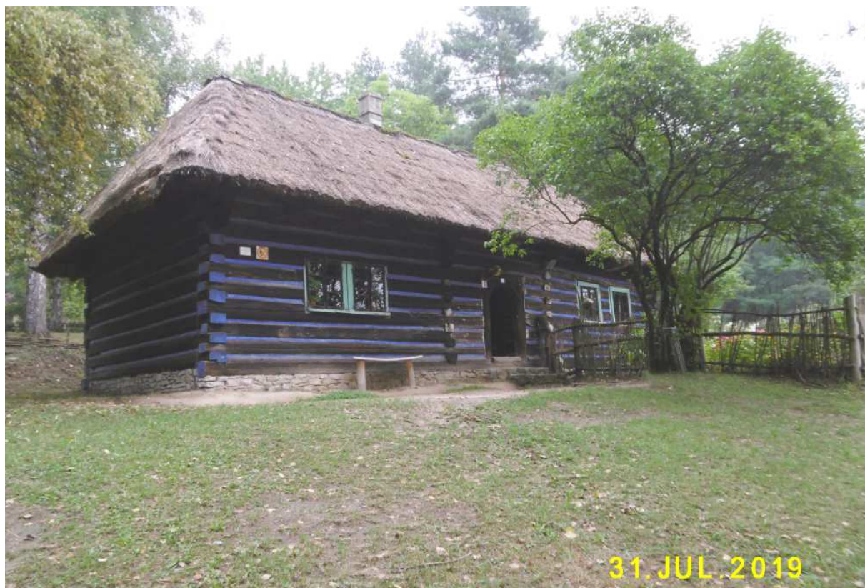
Fot. nr 43. Fasada.
