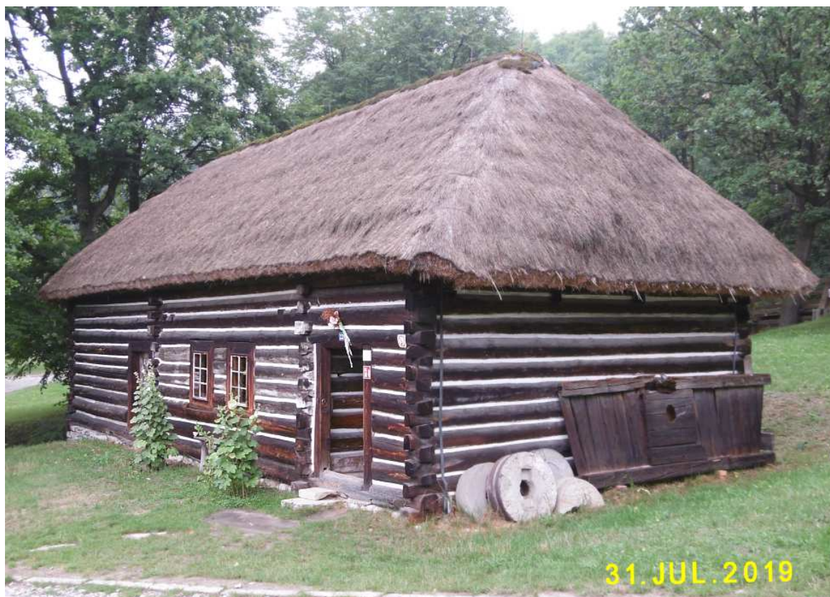
Fot. nr 93 (93-94). Fasada obiektu.
