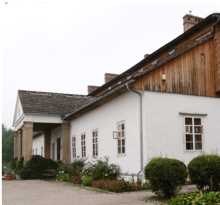
Fot. nr 120 (120-122). Fasada dworu.
