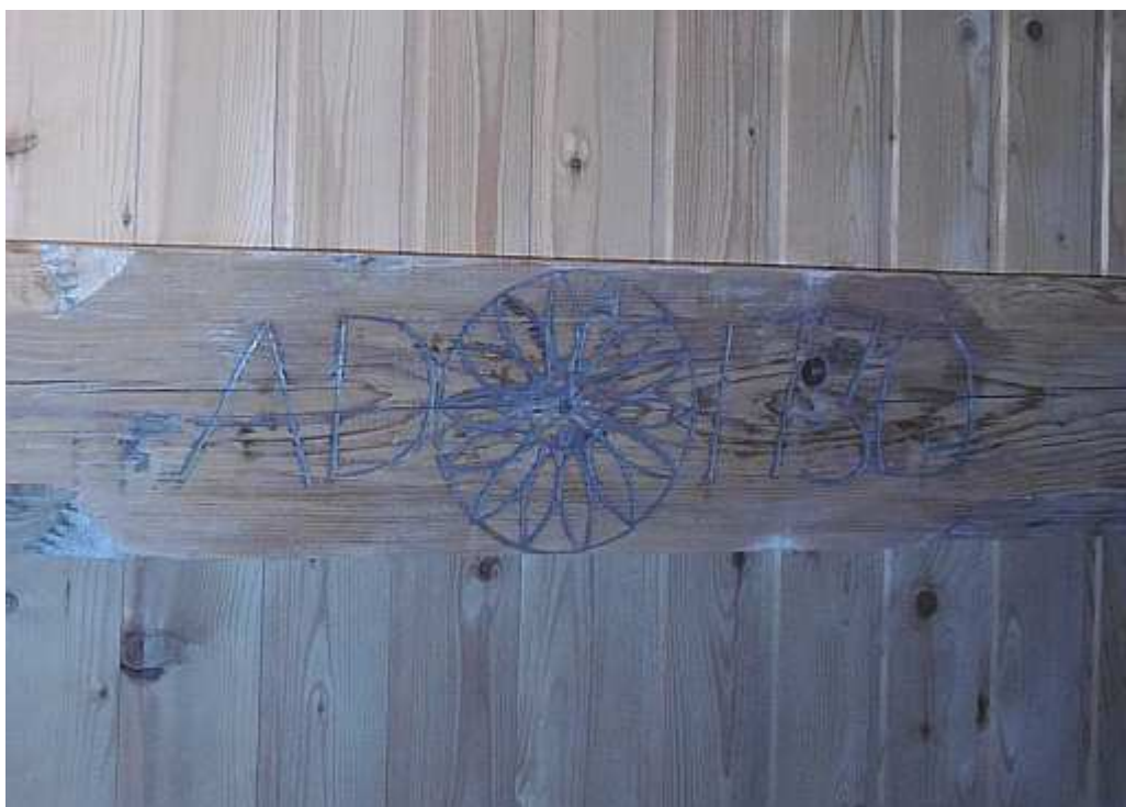
Fot. nr 142. Data budowy dworu na dźwigarze – 1730.
