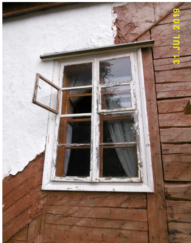
Fot. nr 123(123-125). Oryginalne okna drewniane: ośmiopolowe, otwierane na zewnątrz.
