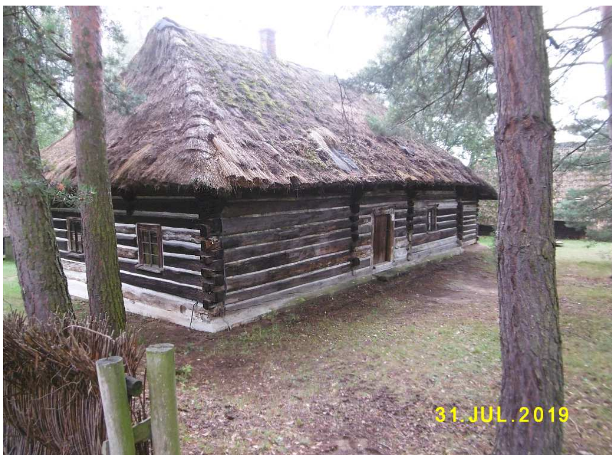
Fot. nr 50. Tylna część obiektu.
