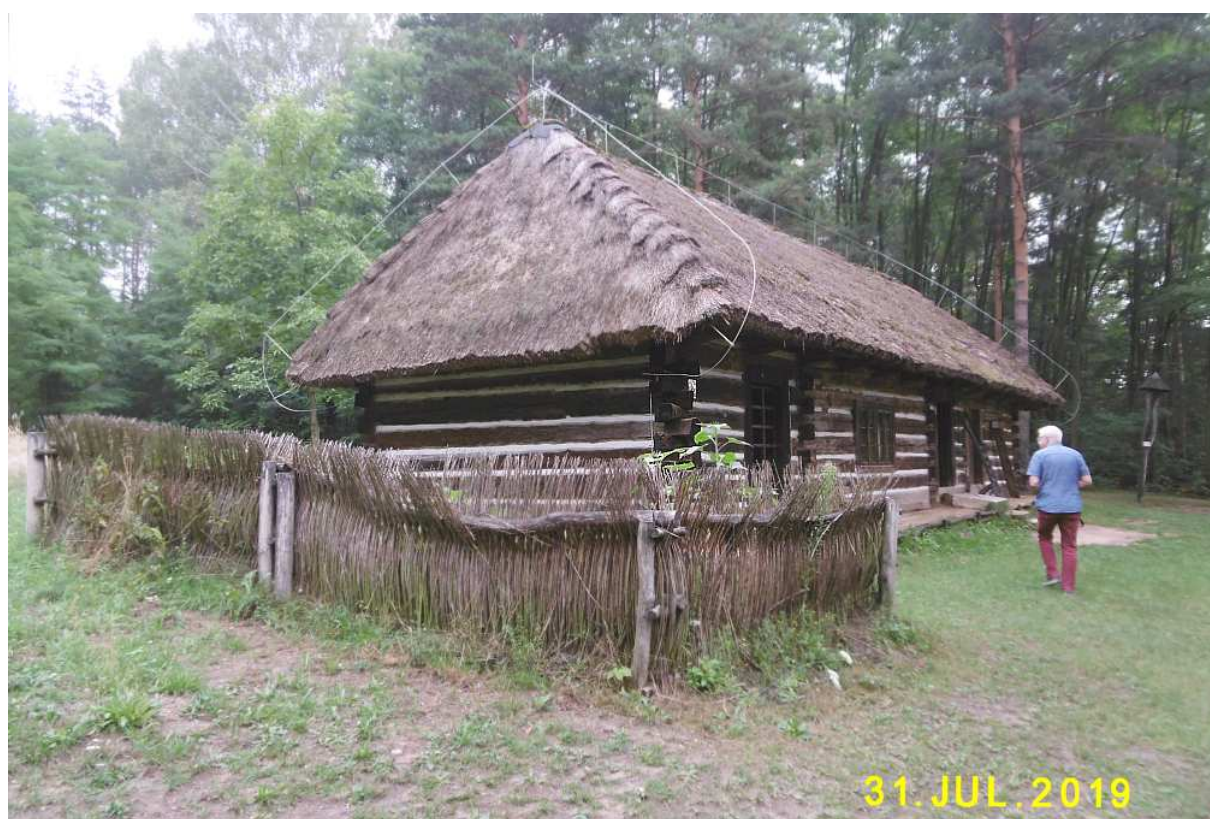
Fot. nr 62 (62-64). Fasada obiektu.
