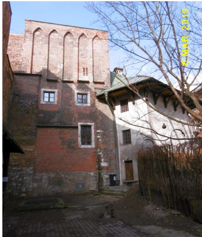
Fot. nr 4 (4-5). Dziejnec na tyłach posesji z Małego Rynku 3 i 4. Widoki z ulicy Mikołajskiej na gotycką wieżę obronną.
