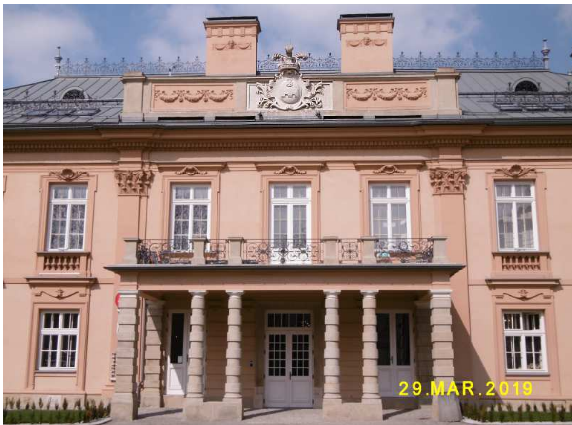
Fot. nr 178. Trzeba pochwalić dbałość o detal przy odnowie obiektu. Kontrowersje budzi jedynie kolor elewacji.
