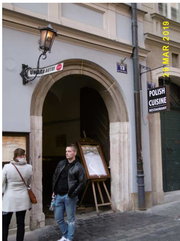
Fot. nr 23 (23-24). Detale kamienicy z ulicy Brackiej 13.
