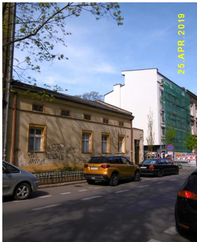
Fot. nr 283 (283-285). Parterowy dom zakonny dawnej ochronki z ulicy Krowoderskiej 38-40, do którego właśnie została dobudowana kamienica.
