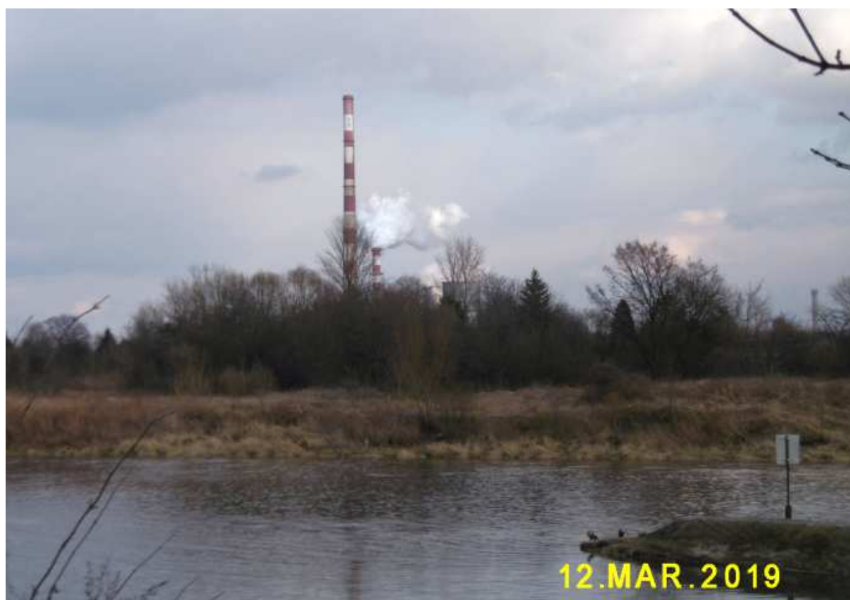
Fot. nr 213 (213-214). Kominy elektrowni w Łęgu ponad Wisłą – widoki z Bulwaru Kurlandzkiego.
