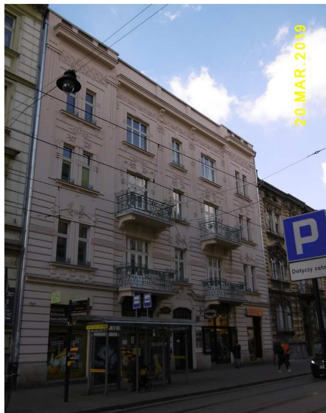
Fot. nr 259 (259-265). Secesyjna kamienica przy ulicy Karmelickiej 46 i jej detale.
