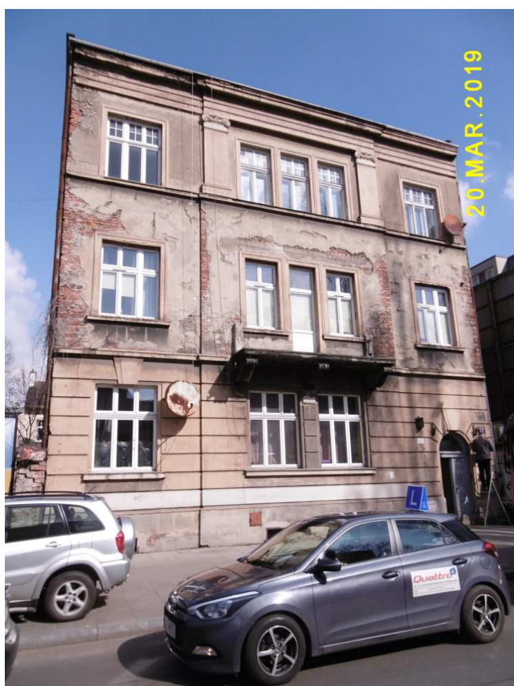
Fot. nr 250. Modernistyczna kamienica pod nr 15.
