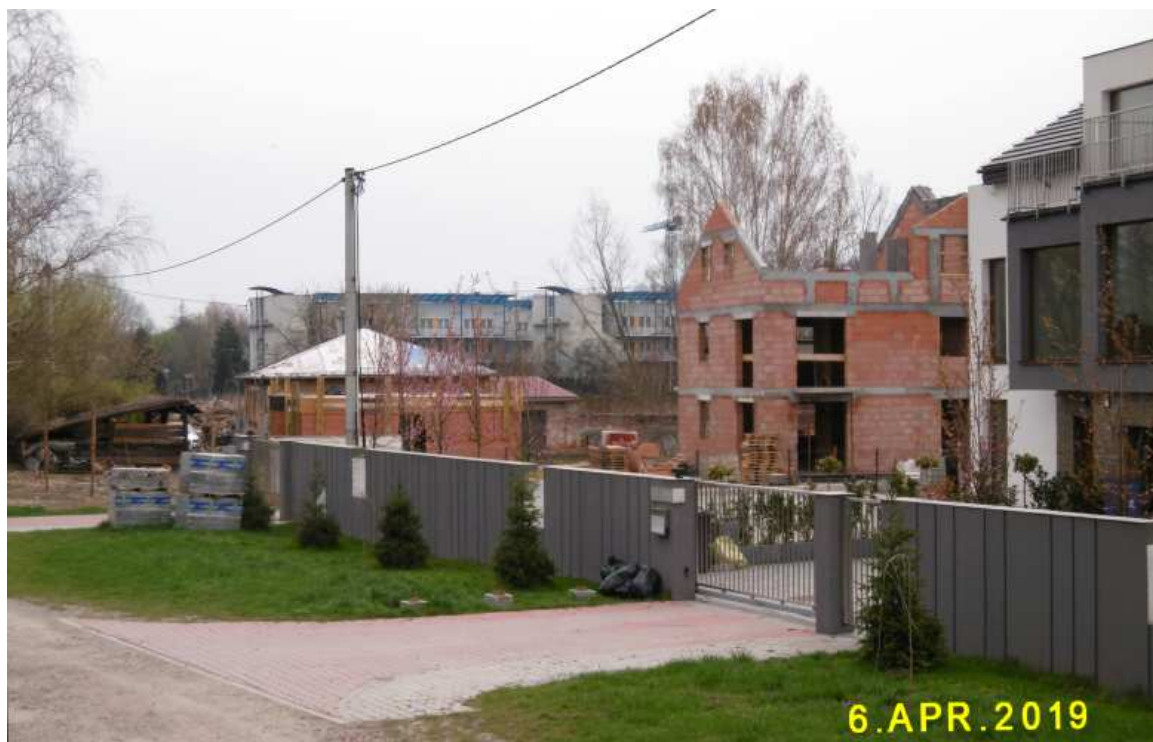
Fot. nr 391 (391-394). Trwa zabudowa terenów przybrzeżnych na odcinku od ulicy Korbutowej do Korzeniowskiego. Tu nowa zabudowa w miejscu domu przy ul. Emaus 53.
