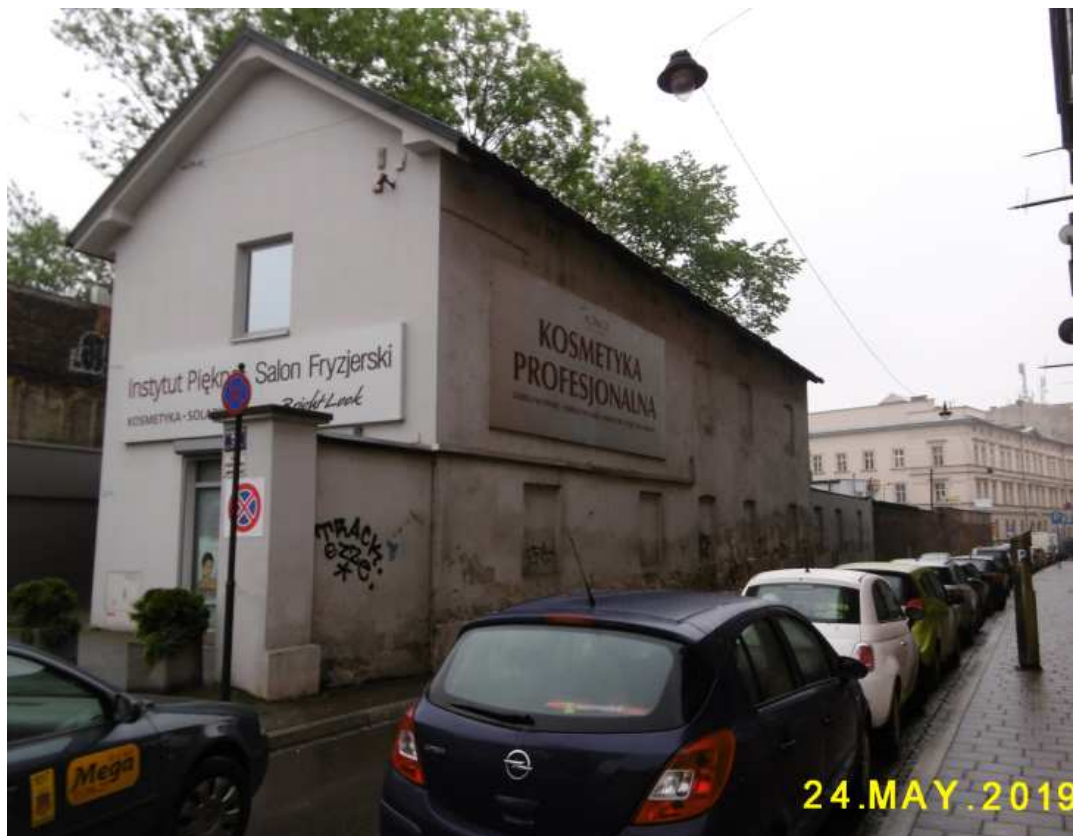
Fot. nr 146. Zabudowa końcowego odcinka ulicy Zacisze.
