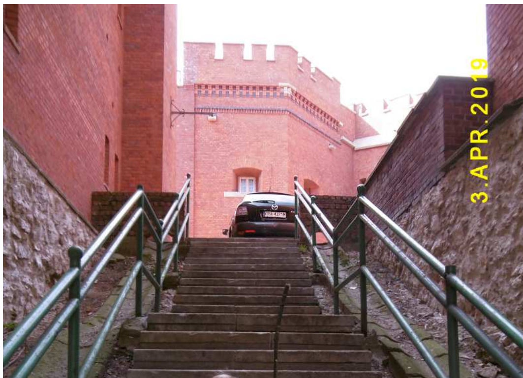
Fot. nr 372 (372-373). Schdody spod bastionu nr IV na dziedziniec fortu.
