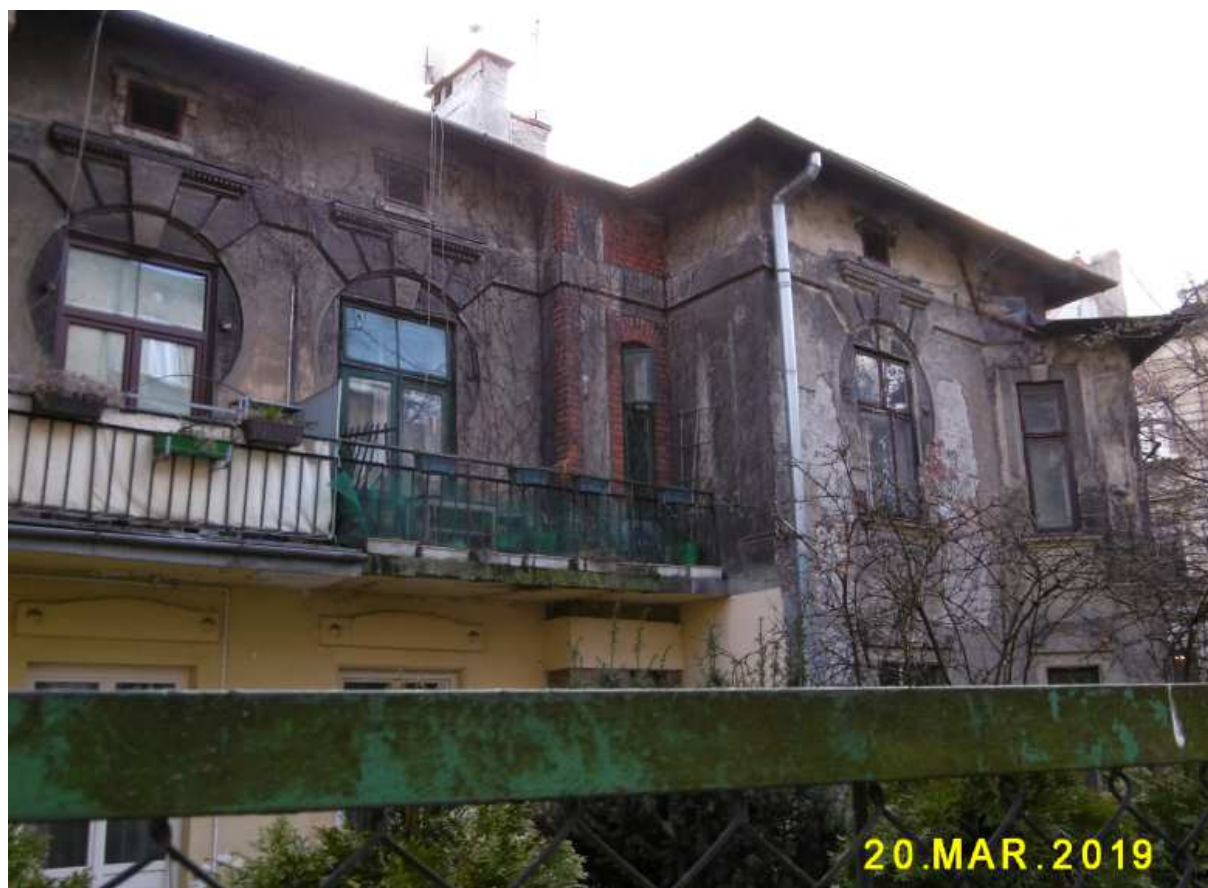
Fot. nr 257. Piętro fasady od strony ulicy Grabowskiego.
