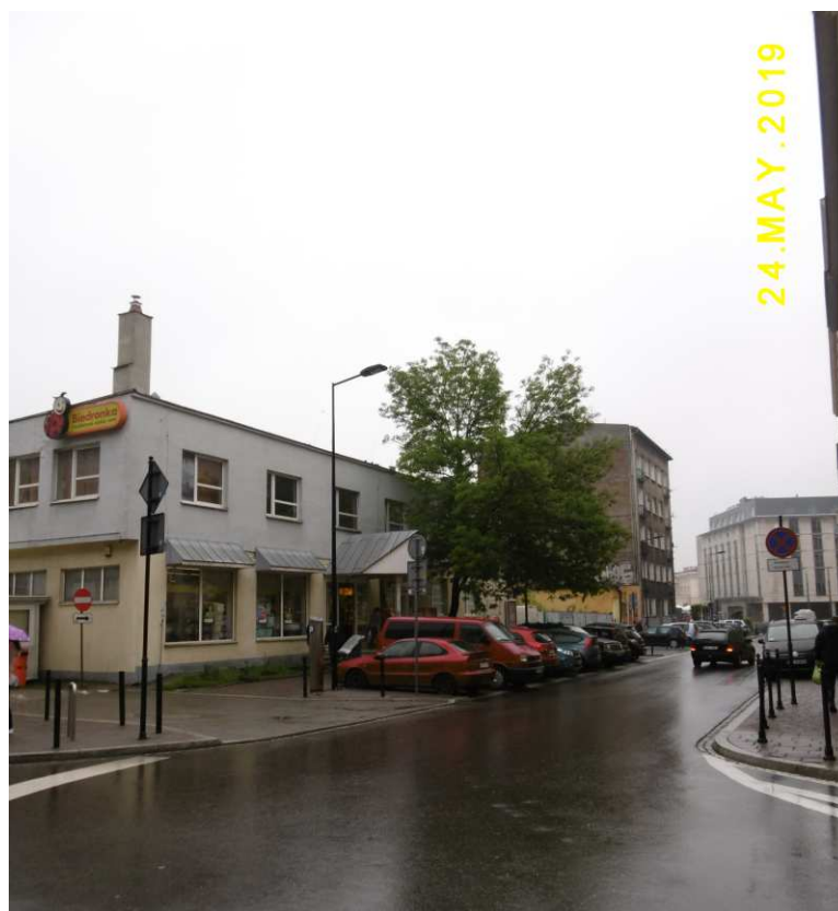
Fot. nr 147 (147-148). Na styku ulic: Worcela i Zacisze. Tu widok w stronę ulicy Pawiej.
