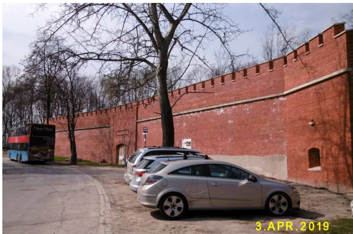
Fot. nr 346. Świeżo zrekonstruowana ściana wewnętrzna bastionu nr II.
