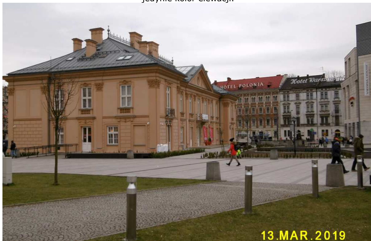
Fot. nr 179. Z hotelami Polonia i Warszawskim w tle.
