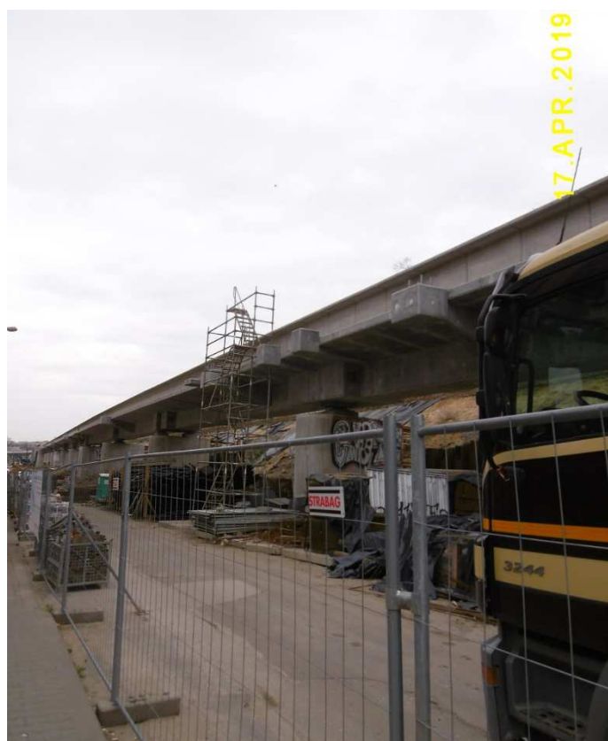
Fot. nr 195. Rozbudowa toru kolejowego w stronę Płaszowa – widok wzdłuż ulicy Blich.
