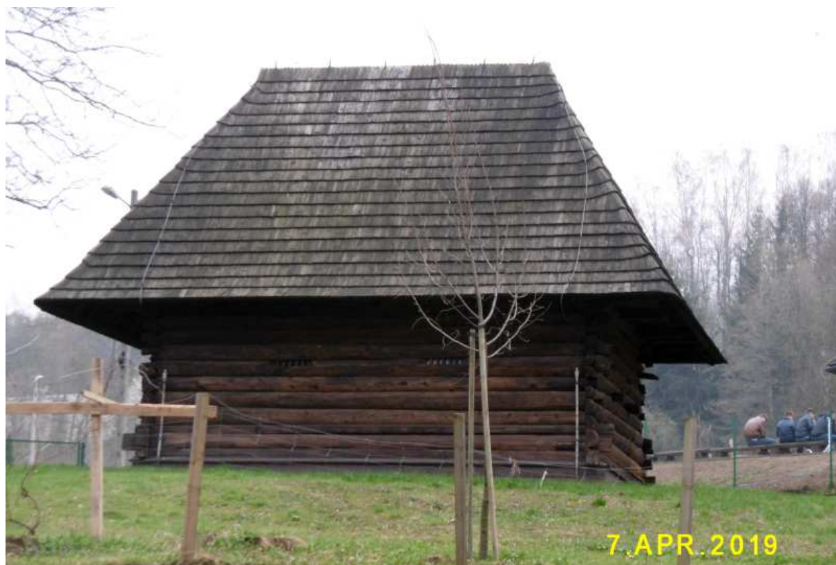
Fot. nr 426. W związku z budową betonowej plebanii trwają tu przemieszczenia zabytkowych obiektów.
