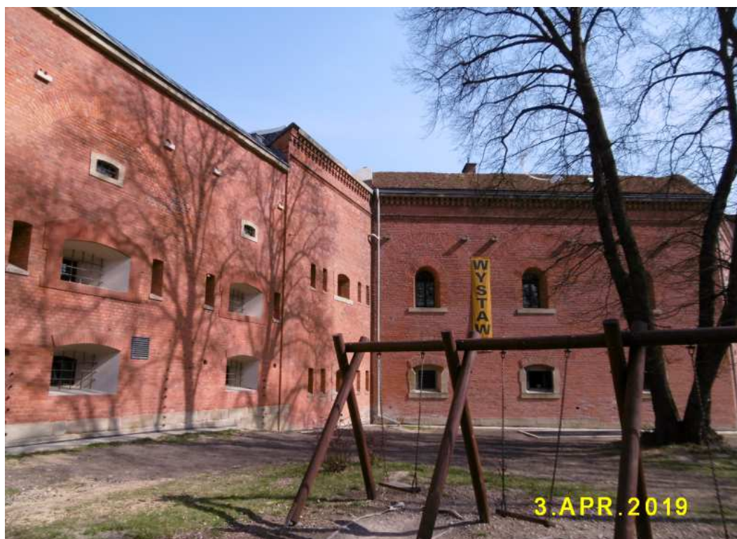
Fot. nr 340. Bastion nr V i kurtyna I-V.
