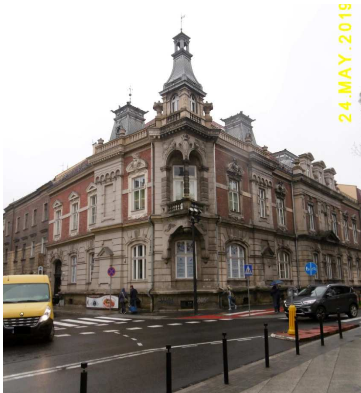
Fot. nr 140. Pałac Włodków pod nr 25, w narożu z ulicą Warszawską 2.
