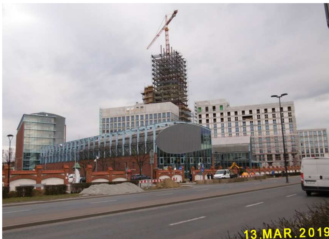
Fot. nr 198(198-199). Trwa rozbudowa giganta mieszkaniowo-biurowego wokół „szkieletora” – widoki z ulicy Frycza-Modrzewskiego.
