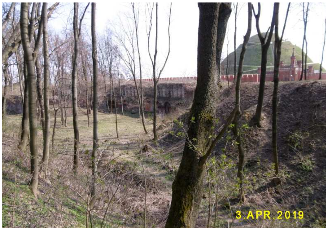
Fot. nr 351 (351-361). Przedpole, fragmenty i detale zrujnowanego pod koniec II wojny światowej bastionu nr II.
