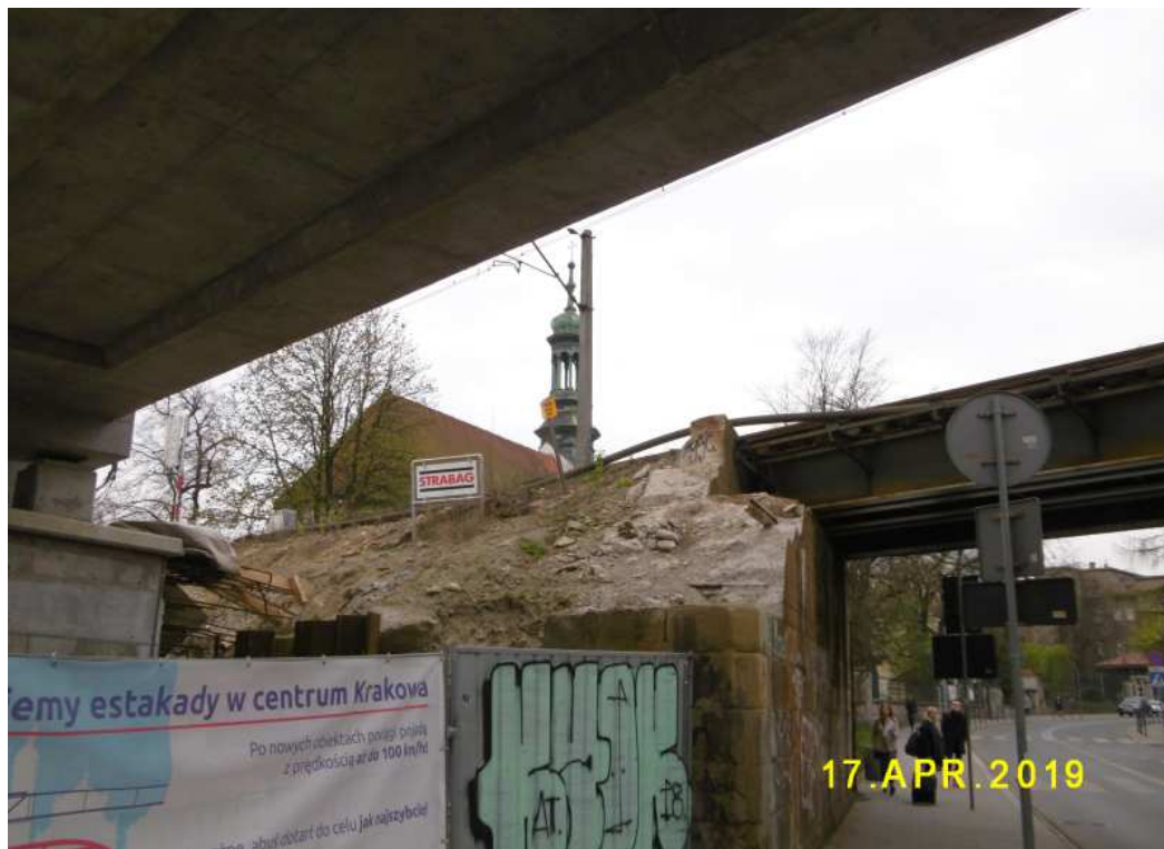
Fot. nr 193(193-194). Ponad rozbudowywanym wiaduktem w stronę kościoła św. Mikołaja.
