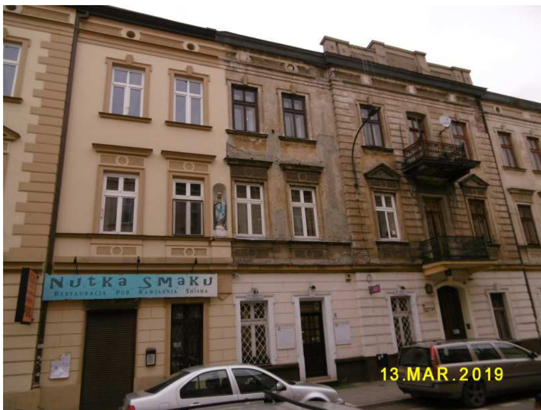
Fot. nr 166 (166-168). Kamienica przy ulicy Zamenhofa 3 i jej detale.
