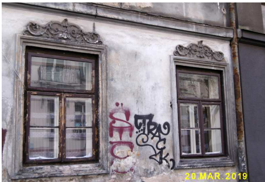
Fot. nr 271. Ostatnie oryginalne okna w prawej części parteru.
