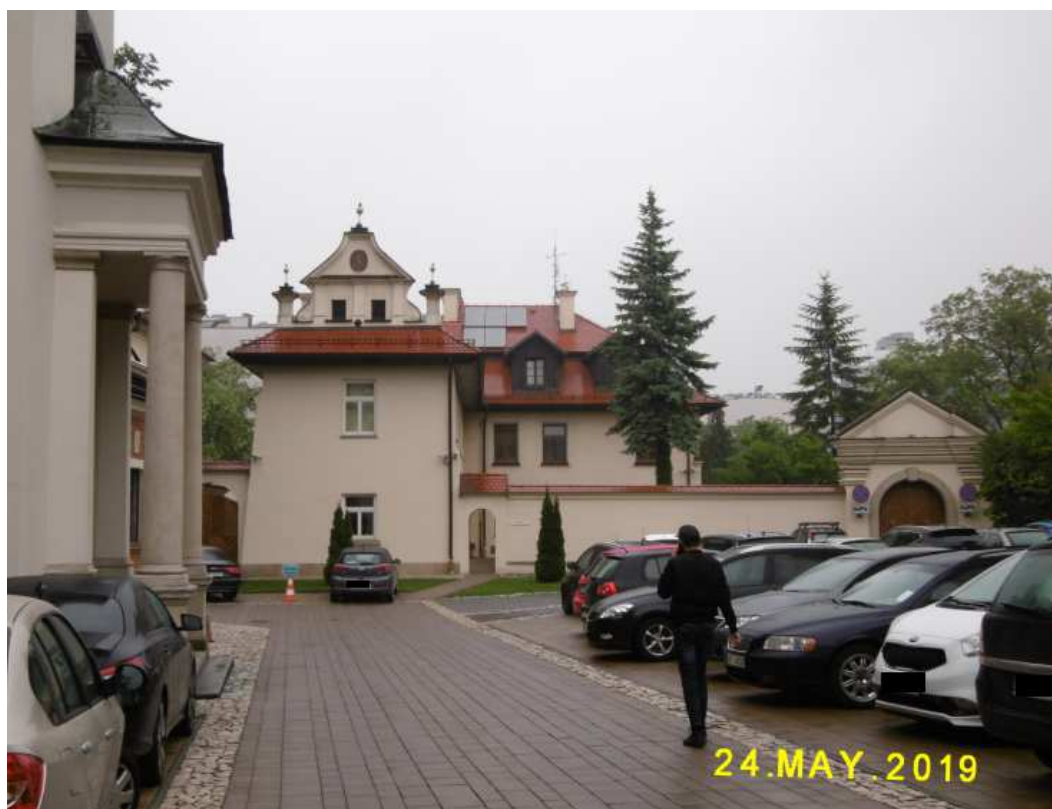
Fot. nr 142. Plebania kościoła św. Floriana – widok z ulicy Kurniki.
