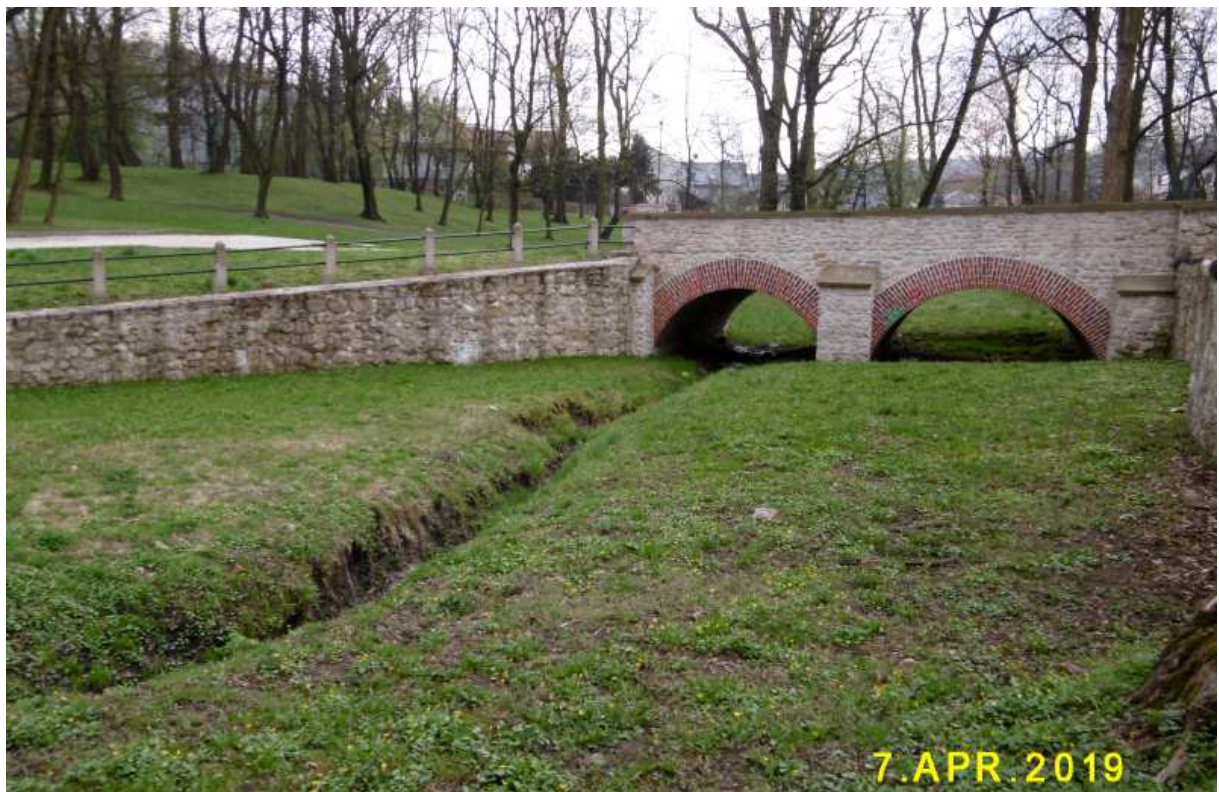
Fot. nr 417. Niedawno zrekonstruowany mostek dojazdowy do pałacu.
