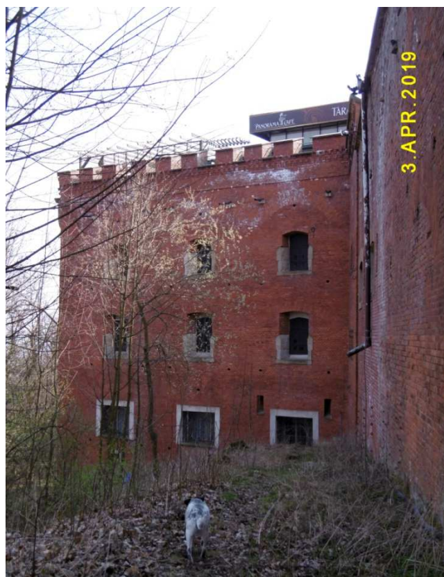
Fot. nr 368 (368-371). Różne ujęcia bastionu nr IV.
