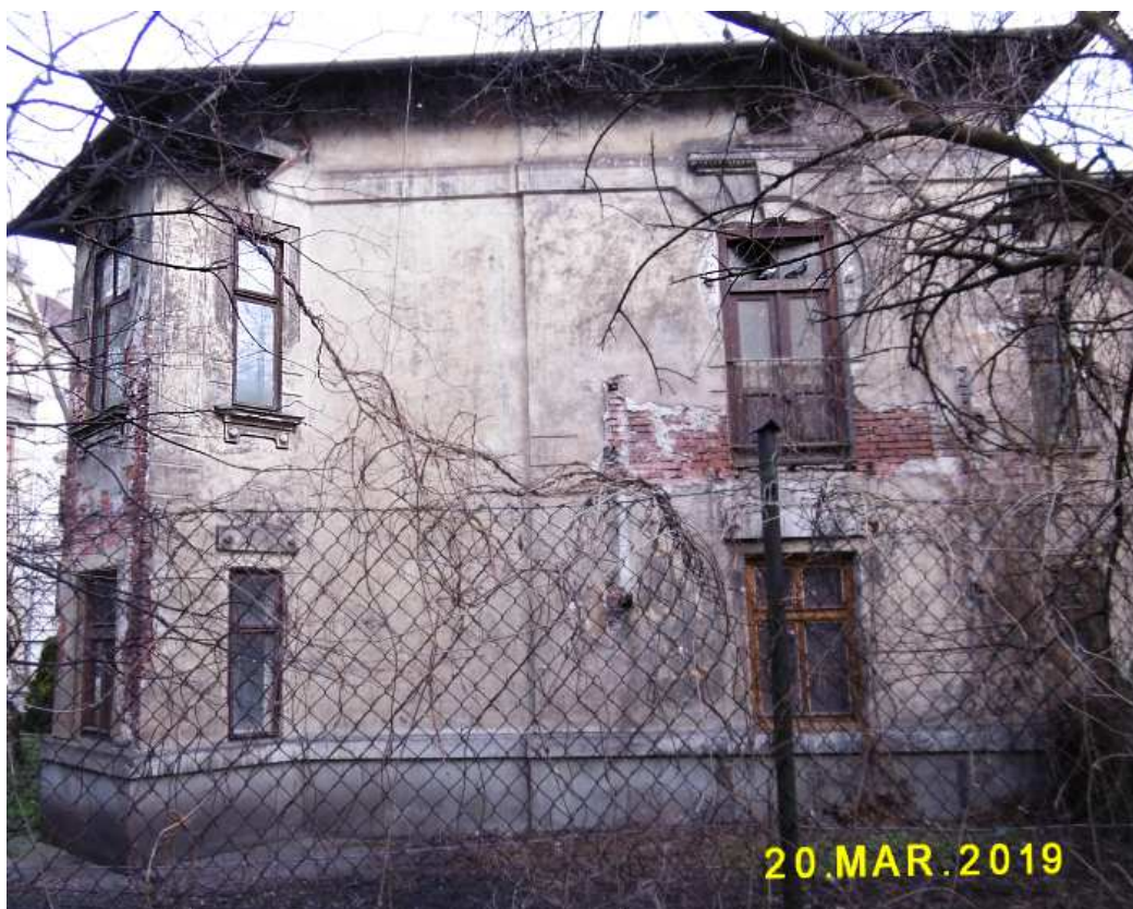
Fot. nr 255 (255-256). Wykusz w narożniku, a nim oryginalne okna I piętra.
