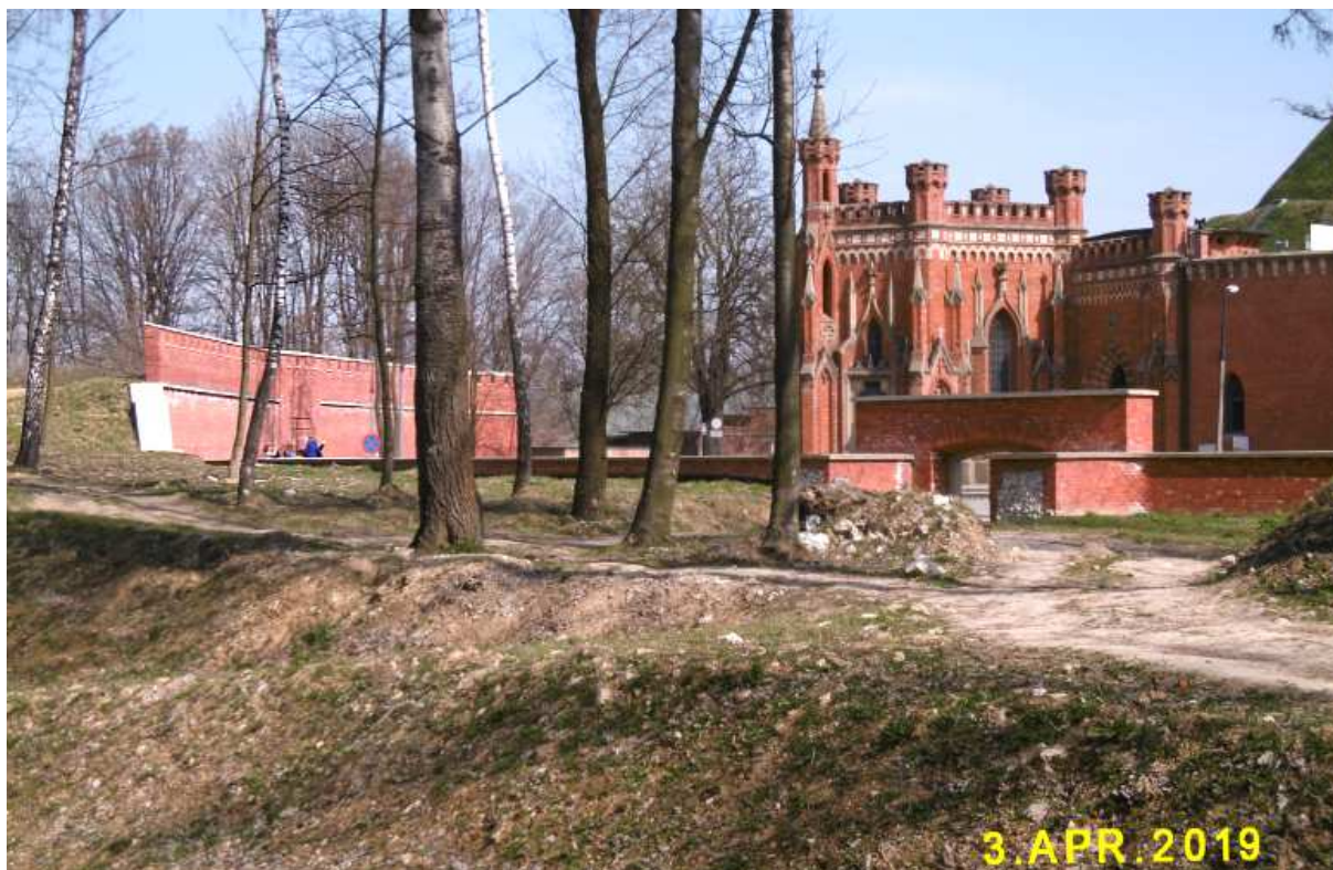
Fot. nr 345. Narys kurtyny I-II i ściana wewnętrzna bastionu nr II w ujęciu od strony fosy.
