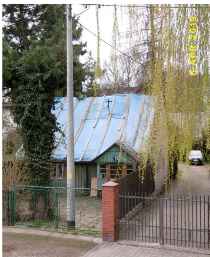
Fot. nr 395 (395-396). Jeden z kilku ostatnich reliktów wiejskiej zabudowy Zwierzyńca. Chałupa z ulicy Emaus 39 ciągle stoi. Jeszcze.
