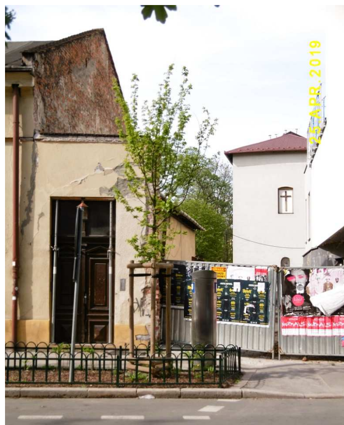
Fot. nr 284 (284-285). Widoki na dziedziniec z kaplicą w tle.
