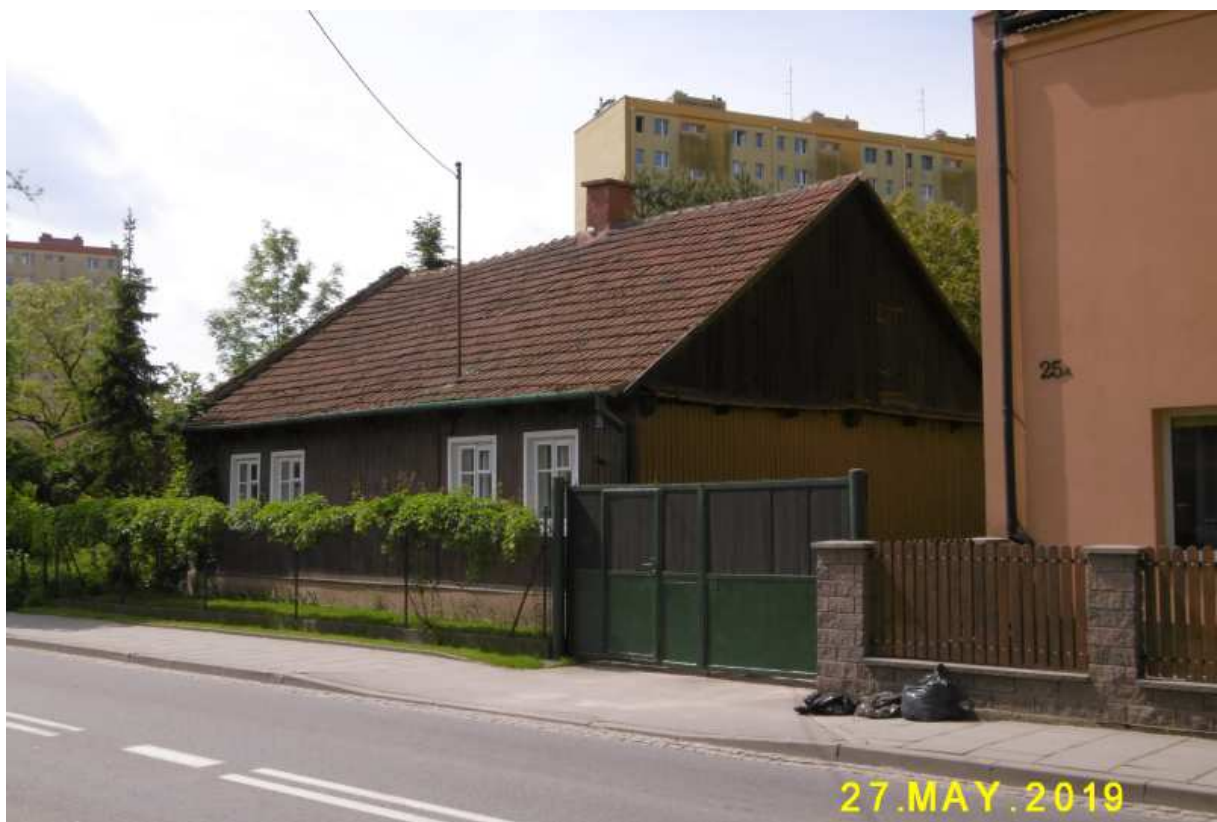
Fot. nr 306 (306-307). Chałupa pod 25, a obok (z lewej) pod nr 23 pustka po niedawno wyburzonym domu.
