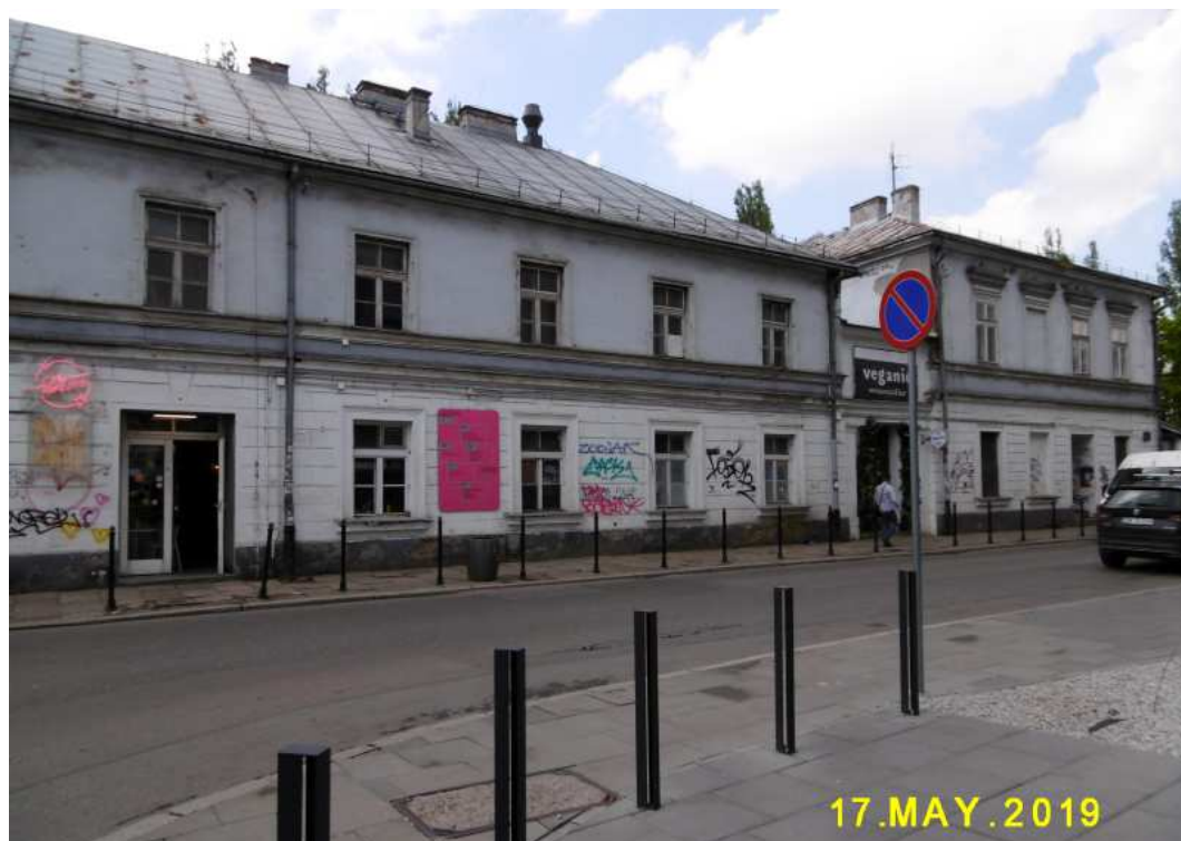
Fot. nr 242 (242-244). Chaotyczne modyfikacje na cele gastronomiczne parteru dawnego budynku socjalnego „cygar fabryki” przy ulicy Dolnych Młynów 10-12, czyli (po prostu) niszczenie fasady.
