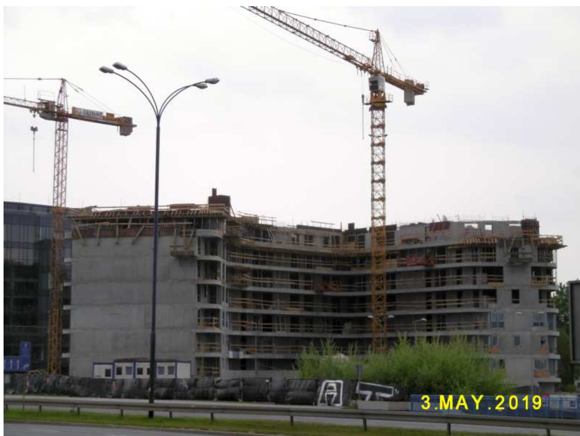
Fot. nr 103. Betonowanie Ludwinowa trwa.
