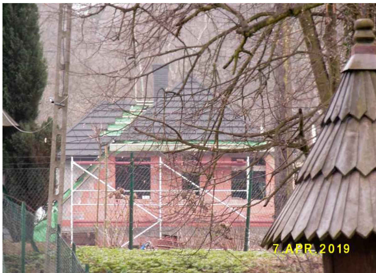
Fot. nr 430 (430-433). Plebania na etapie prac budowlanych. Jej lokalizacja zmusza do przenosin zabytkowych obiektów drewnianych w inne miejsca.
