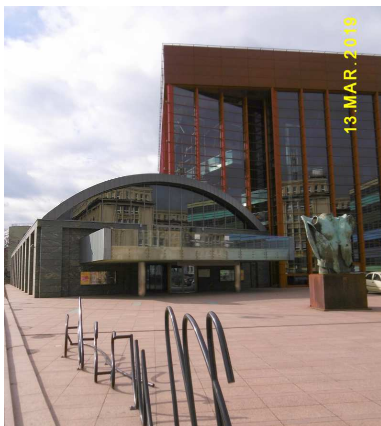
Fot. nr 187. Budynek Operetki po przebudowie z Domu Żołnierza i wylukrowaniu jego fasady.
