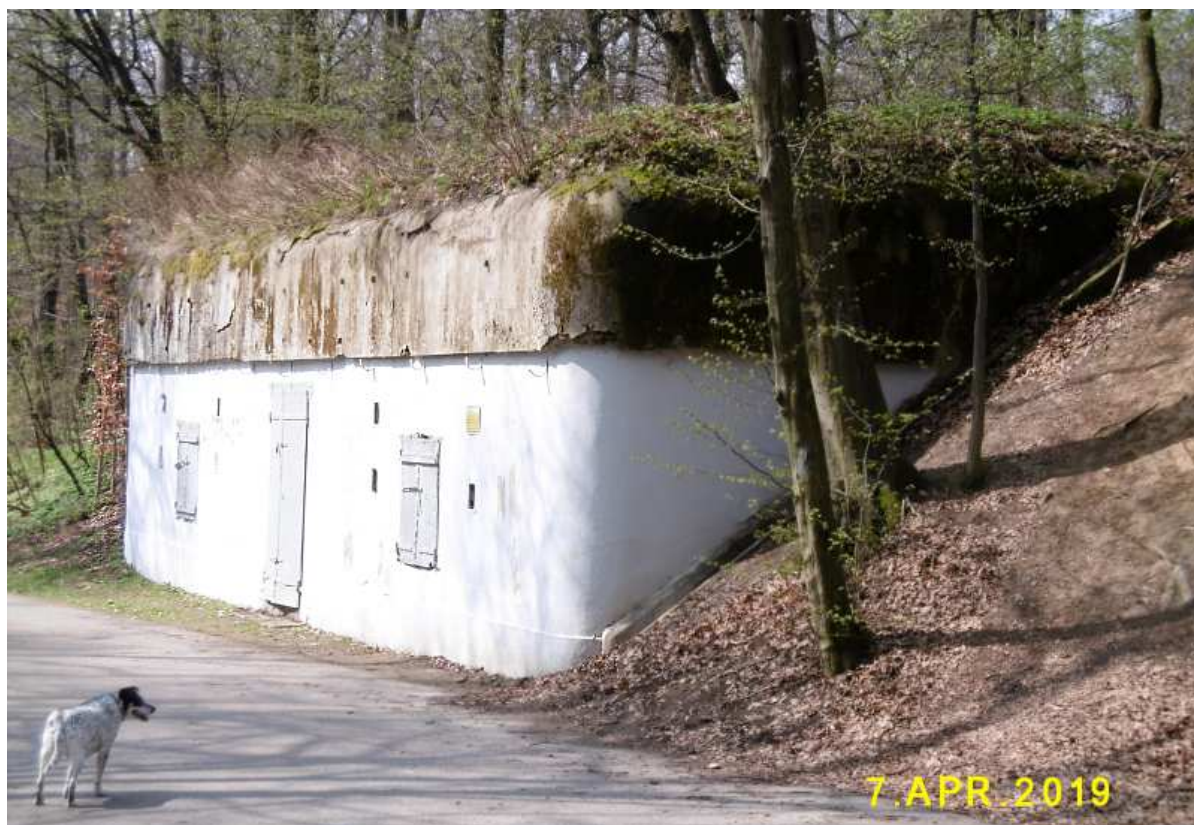
Fot. nr 458 (458-459). Schron amunicyjny na Ostrej Górze, pamiątka po baterii FB 36 Twierdzy Kraków.
