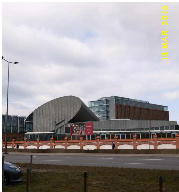
Fot. nr 197. Nowe budynki Akademii Ekonomicznej - widok z ulicy Modrzewskiego.
