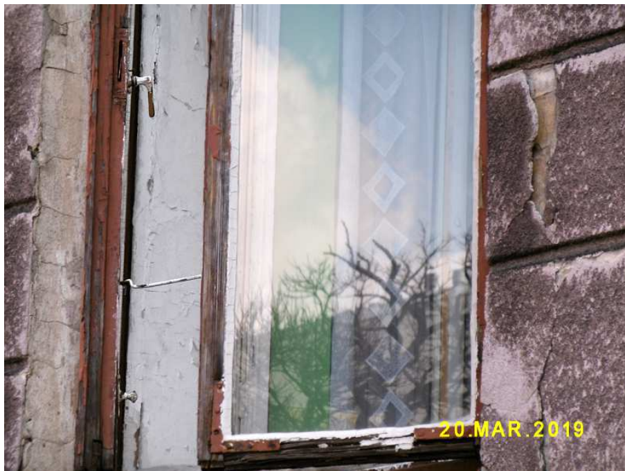
Fot. nr 130. Archaiczny detal: haczyk do blokowania kwater przed zatrzaskiwaniem.
