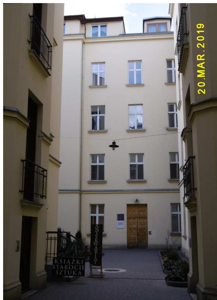
Fot. nr 265. Podwórko kamienicy. W tle oficyna.
