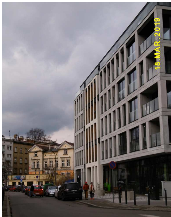
Fot. nr 241. A zdaniem poprzecznego WKZ miało to być nawiązanie do zabudowy z lat 50.
