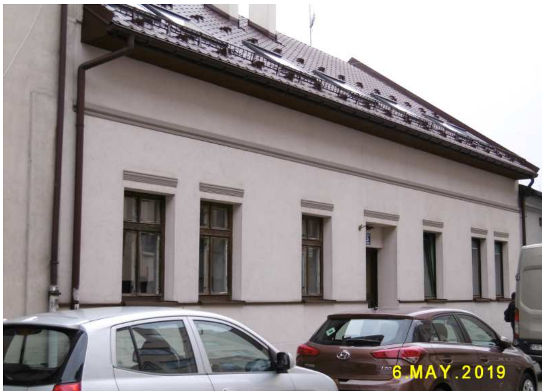
Fot. nr 138. Parterowy relikt spod nr 3.
