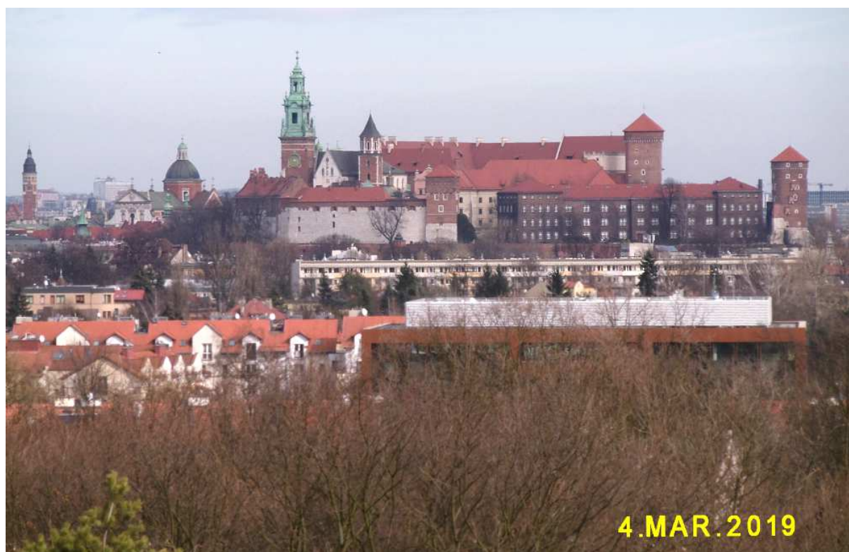
Fot. nr 30 (30-32). Zamek królewski na Wawelu.
