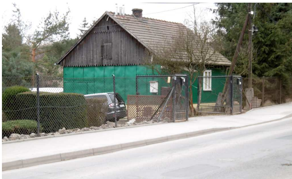
Fot. nr 366 (366-370). Dawna zabudowa ulicy Kosocickiej. Tu chałupa pod nr 51. (03.03.2019)
