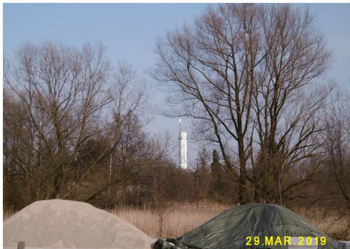
Fot. nr 314. Wieża ciśnień rurociągu Raba ponad ogródkami działkowymi przy ulicy Niebieskiej – widok z ulicy Do Luboni.
