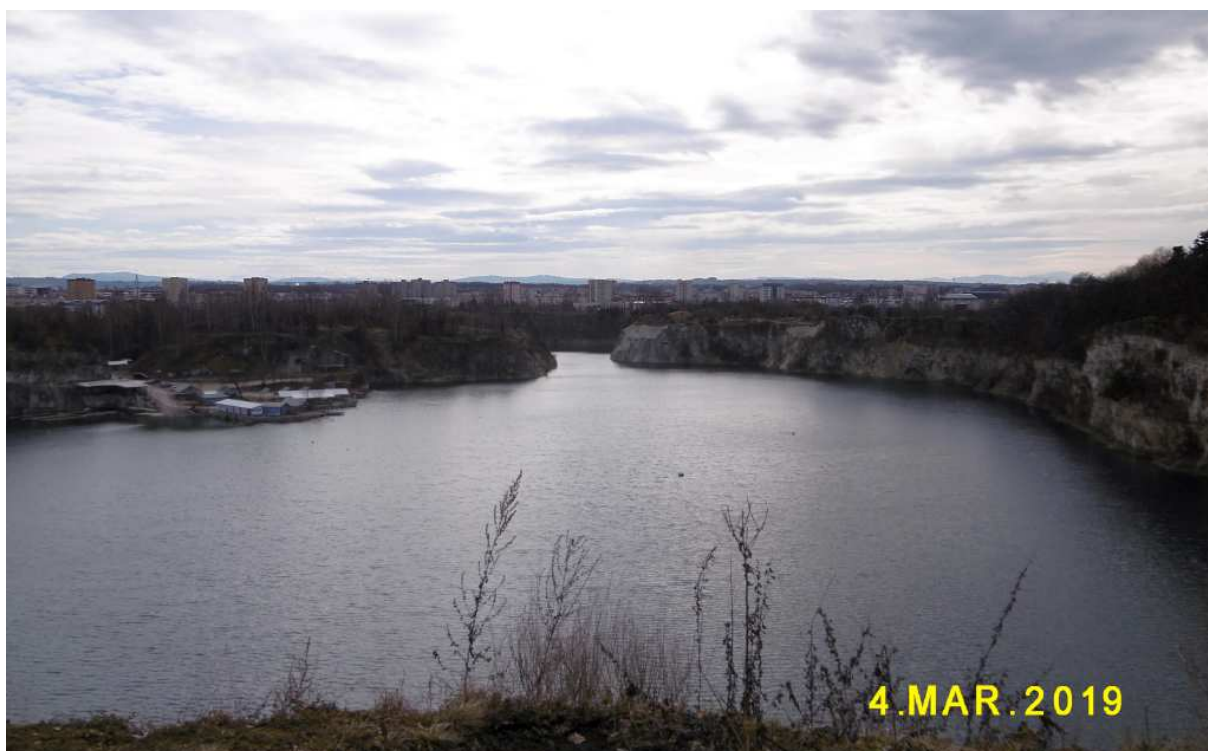
Fot. nr 38 (38-42). Zbiornik na Zakrzówku. Tu ujęcie ze wzgórza nad ulicą Twardowskiego.
