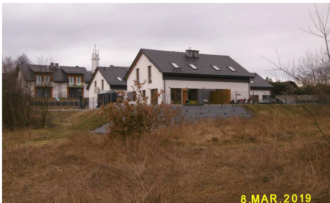
Fot. nr 361. Nowa zabudowa ulicy Kosocickiej pod nr: 108 i 110.
