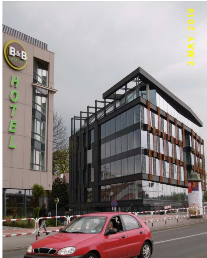
Fot. nr 7. Widok z ulicy Monte Cassino.
