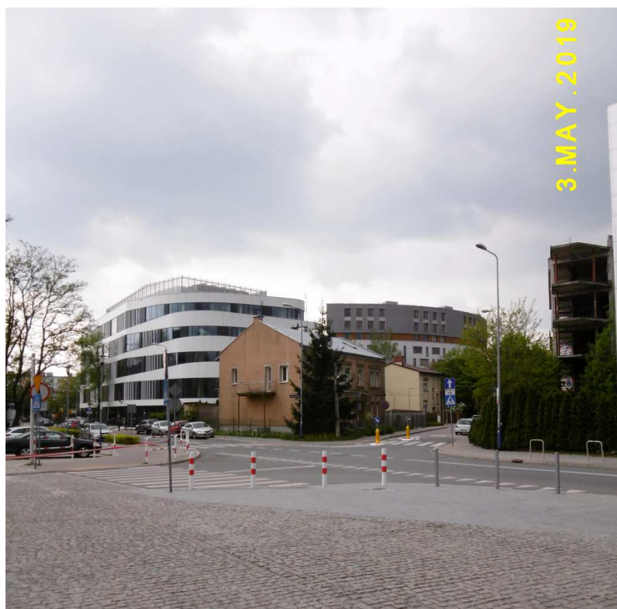
Fot. nr 34. Resztki dawnej zabudowy Zakrzówka na styku ulic: Twardowskiego i Bułhaka.
