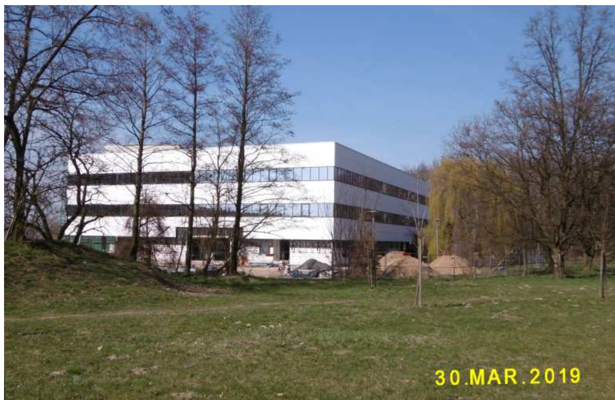
Fot. nr 267. Nowo wyremontowany budynek biblioteki przy ulicy Medycznej 7.
