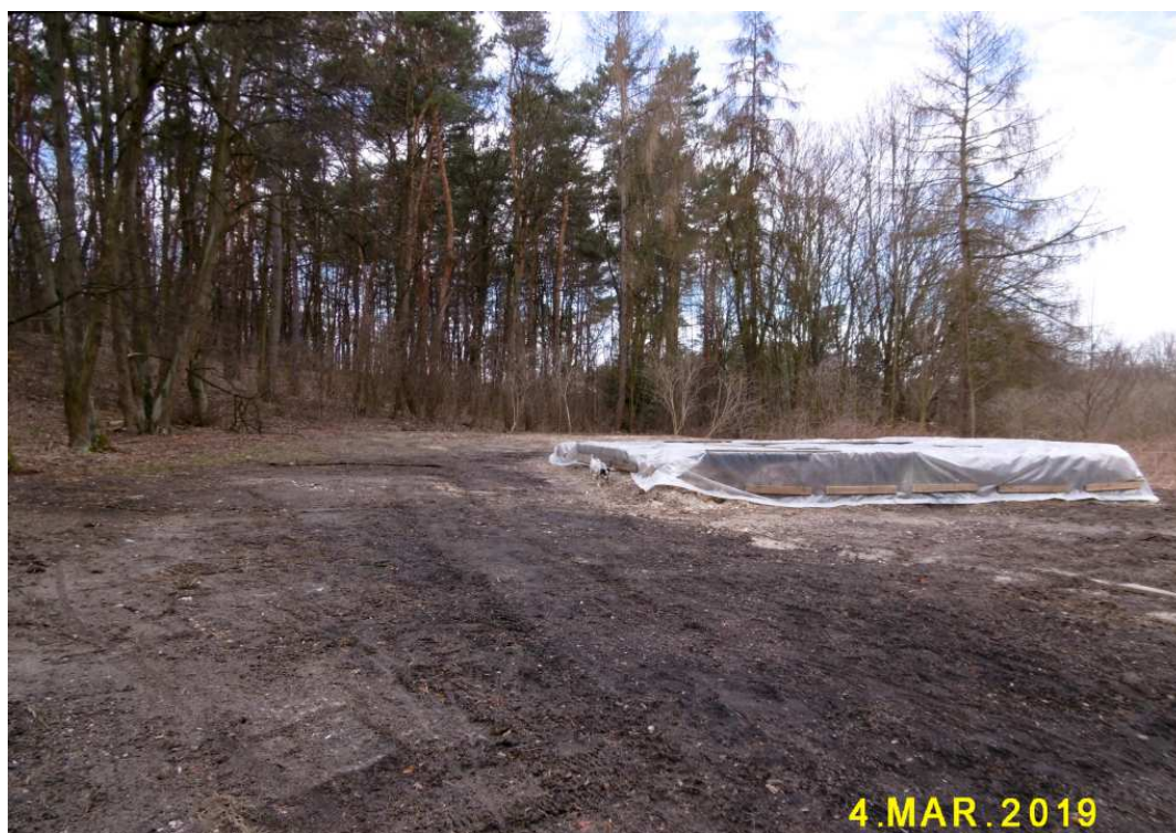
Fot. nr 14 (14-15). Pozostałości po przedwojennej leśniczówce z ulicy Do Groty 105. Czy zostanie odbudowana, skoro pozostały fundamenty?
