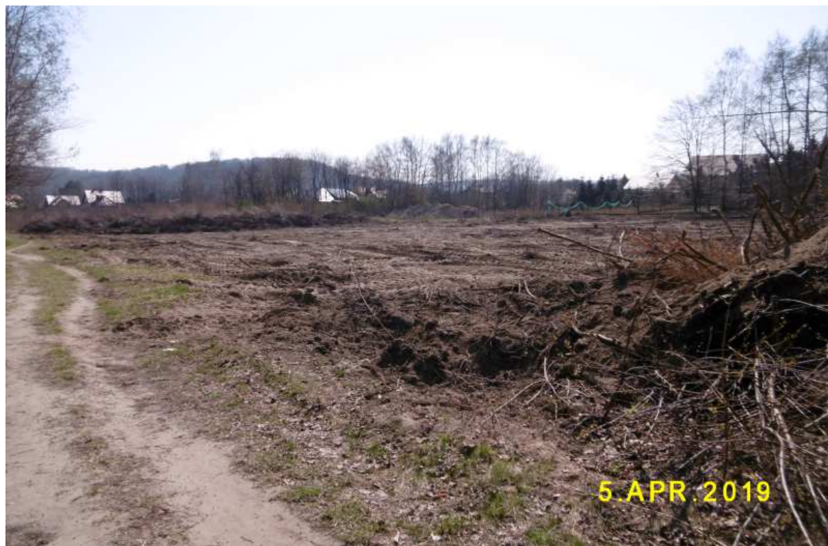
Fot. nr 348. Świeżo splantowany pod zabudowę fragment gruntu powyżej uliczki Snozy.
