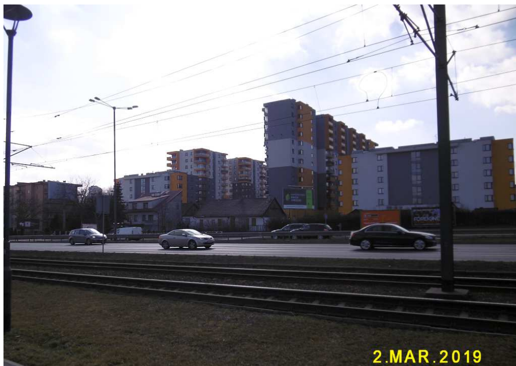
Fot. nr 269(269-275). Nowa zabudowa mieszkalna we fragmencie ul. Wielickiej pomiędzy ulicami: Włotową i Facimiech, a pośrodku relikty dawnej zabudowy pod nr: 249 i 251.
