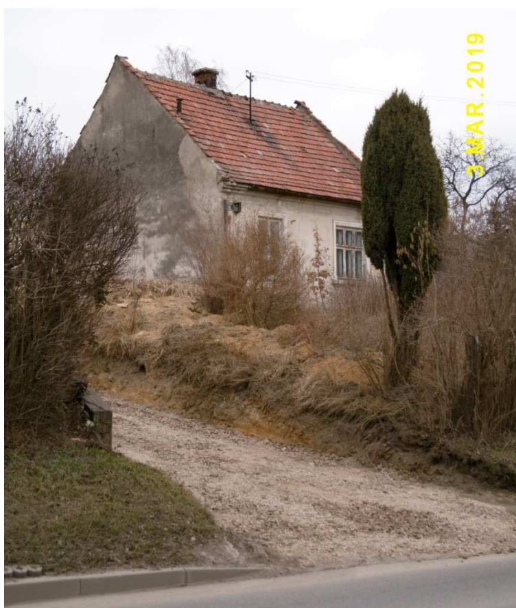
Fot. nr 368. Ostatnie tchnienia przedwojennego domku spod nr 46.
