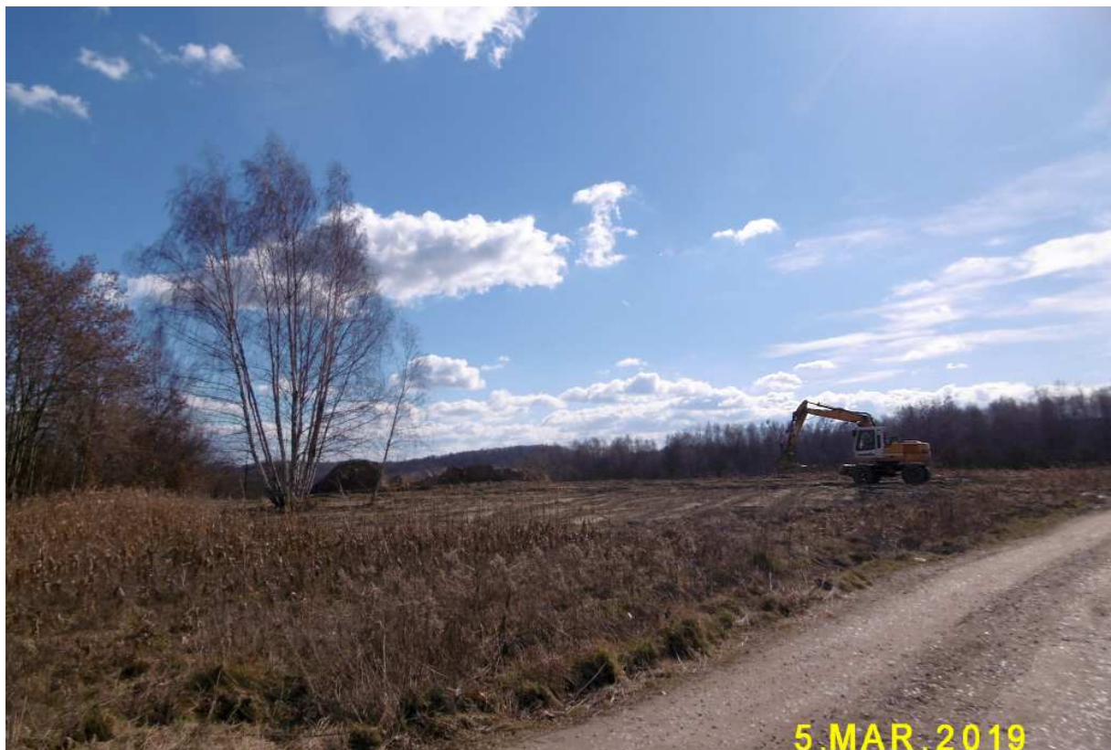
Fot. nr 317 (317-325). Prace ziemne w początkowym odcinku polnej ulicy Słona Woda. Czy jest to przygotowanie do powstania tu parku czy nowego blokowiska?
