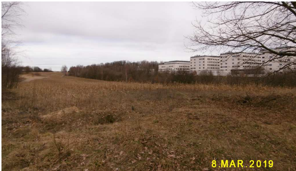
Fot. nr 333 (333-335). Niemal gotowy nowy kompleks szpitalny UJ, zlokalizowany wzdłuż ulicy Jakubowskiego, gdzie mają zostać przeniesione kliniki z ulicy Kopernika,.
