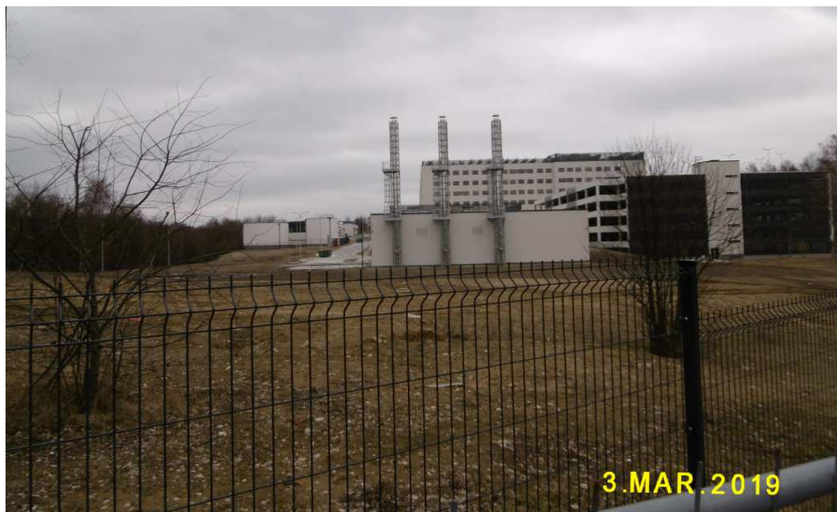
Fot. nr 364 (364-365). Nowy kompleks szpitalny UJ w ujęciach o d strony osiedla Rżąka.
