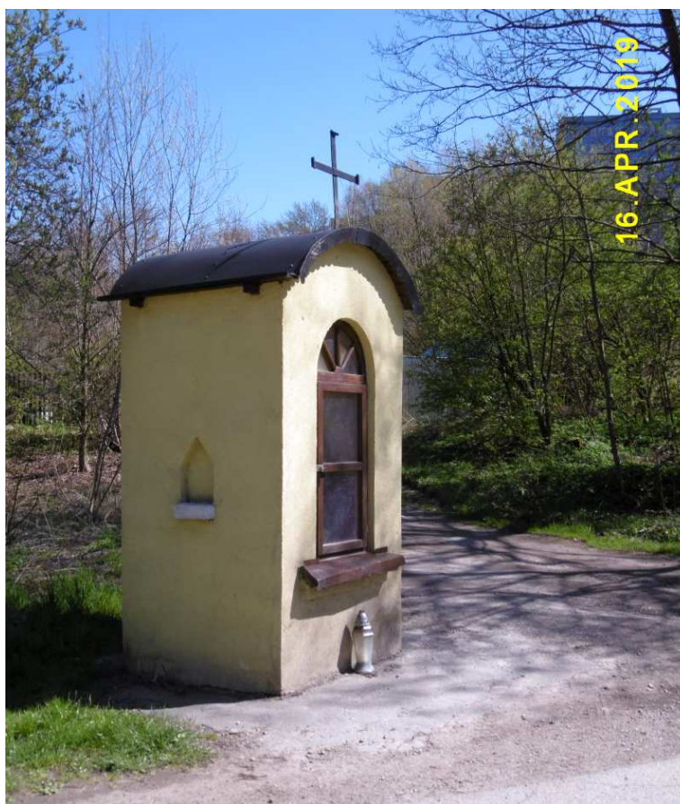
Fot. nr 308 (308-309). Krzywa kiedyś kapliczka przy ulicy Mokrej 41, która po wiernej odbudowie jakby znów traciła pion.
