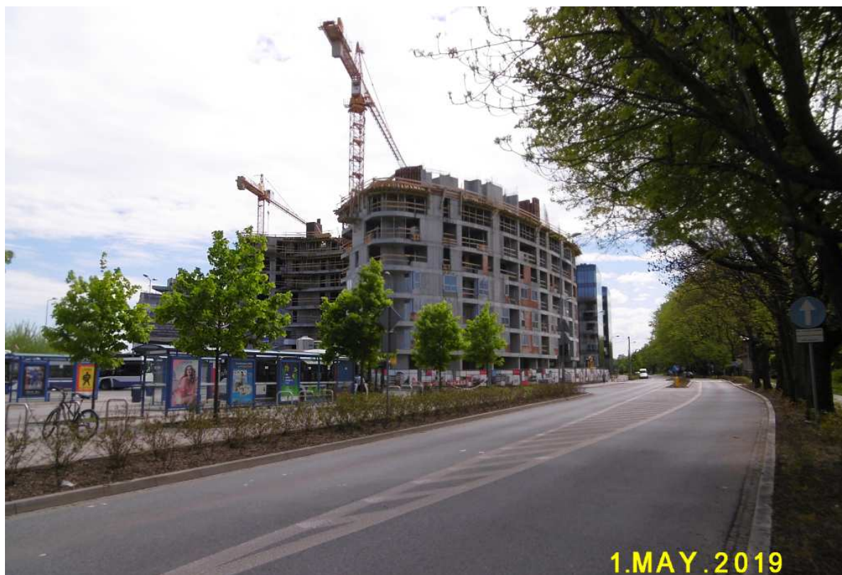
Fot. nr 89. Widok od strony Wierzbowej.
