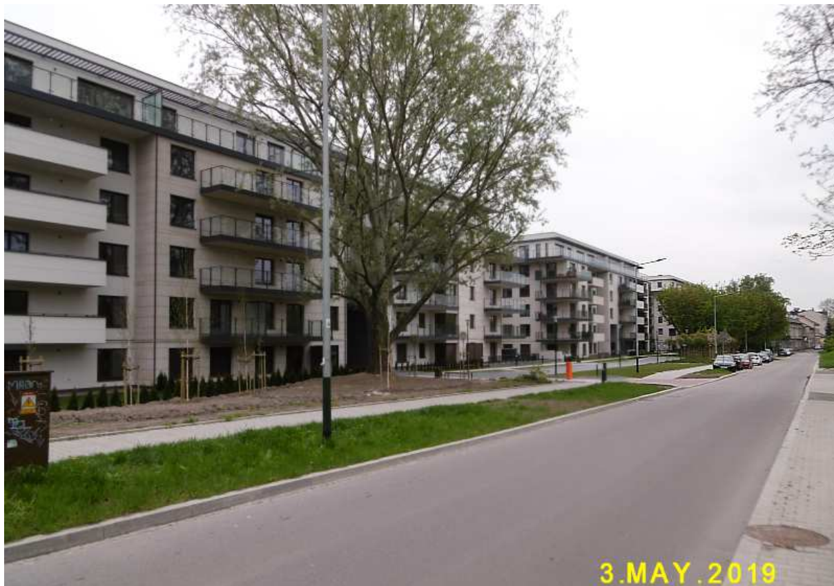
Fot. nr 83 (83-84). Zabudowa początkowego odcinka ulicy Przedwiośnie pod nr 2A i 2B, która powstała w miejscu tzw. „poziomkowego sadu”.
