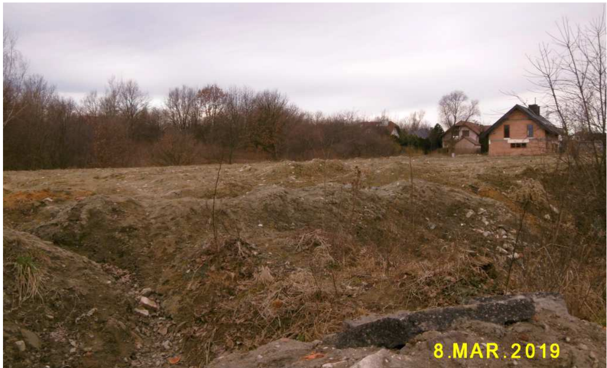
Fot. nr 328 (328-330). Splantowany i zasypany gruzem oraz śmieciami teren pod zabudowę we fragmencie między ulicami: Słona Woda i Obronną. Ponieważ zostało też zasypane źródliko rżączkiego stawu inwestor został zobowiązany do usunięcia nasypu.
