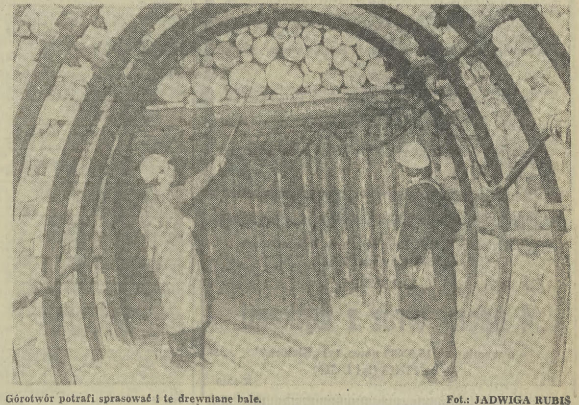
Górotwór potrafi sprasować i te drewniane bale. Fot.: JADWIGA RUBIS
