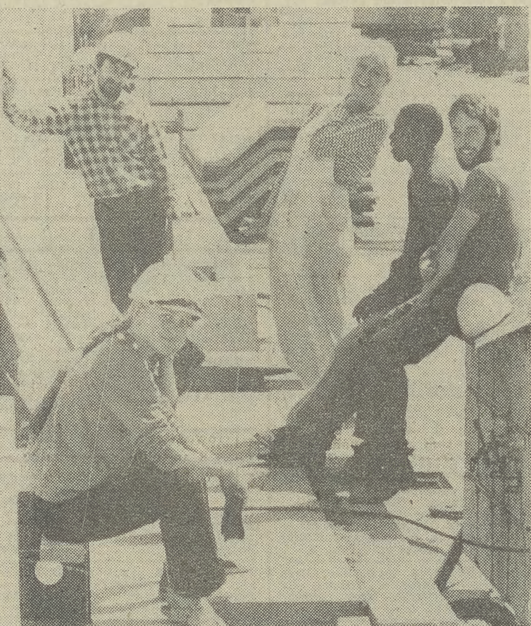
„Eine kleine Pause” — czyli krótka przerwa w pracy na budowie zakładu przemysłowego w Berlinie, gdzie pracują wspólnie z kolegami z Mozambiku studenci Uniwersytetu Warszawskiego.
