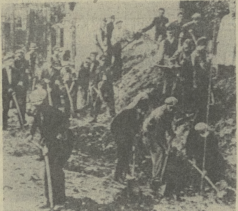
Żołnierze Robotniczych Batalionów Obrony Warszawy budują zapory przeciwczołgowe.
