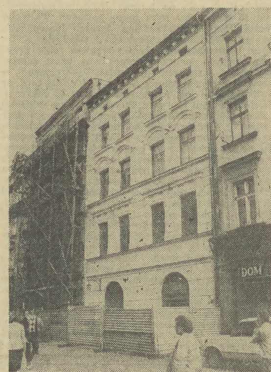
Floriańska 37 — w tym odnowionym już budynku parter przeznaczony został na sklep i galerię sztuki teatralnej, I piętro zajmie redakcja „Aury”, na II p. będą mieszkania prywatne, a na poddaszu znajduje lokum pracownia konserwacji zabytków.
