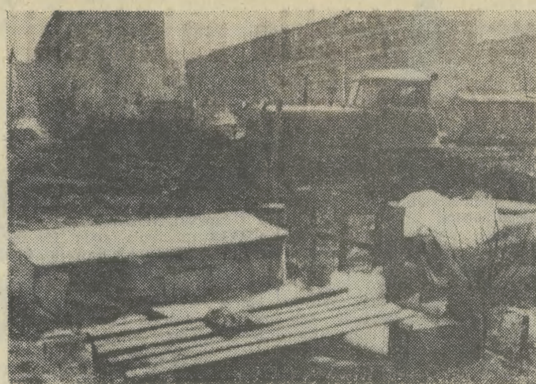
Za chwilę łopata spychacza zgarnie cały dobytek, a wkrótce w tym miejscu będą kwietniki.
