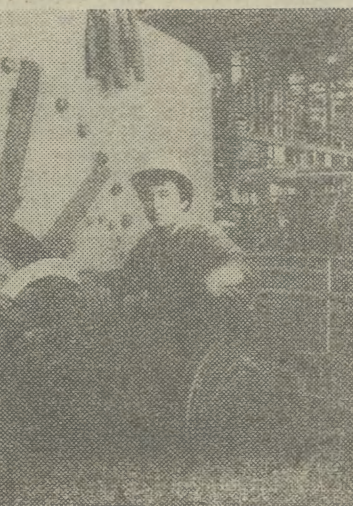
Przy remoncie generatora bloku nr 1 pracuje Andrzej Żmuda — monter uszczelnień wodorowych. Fot.: JADWIGA RUBIŚ
