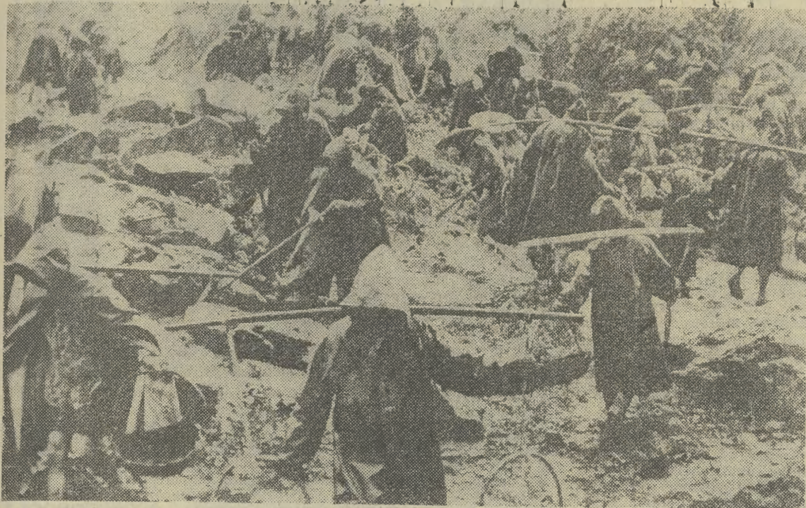
Chińczycy na placu budowy. Trzeba przyznać, że jest ich wielu.
